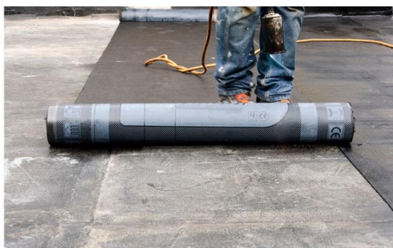
Figura 21: Aplicação da manta asfáltica com maçarico.
