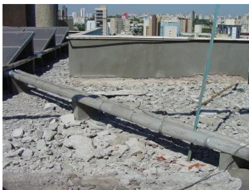
Figura 3: Reconstrução da laje.
