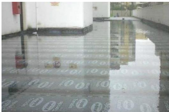
Figura 26: Teste de estanqueidade.
