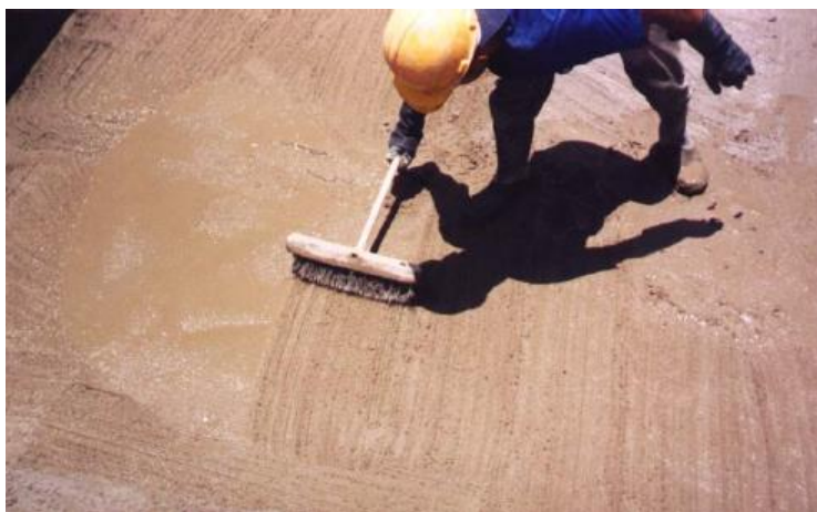
Figura 28: Proteção mecânica simples.
