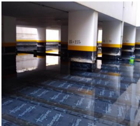
Figura 47: Teste de Estanqueidade em Pavimento Garagem.
