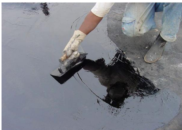
Figura 25: Espalhamento da membrana asfáltica quente.
