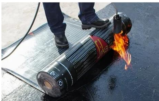
Figura 35: Detalhe da aplicação mantas asfálticas SikaShield.
