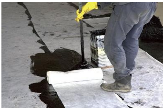
Figura 27: Aplicação da camada separadora.
