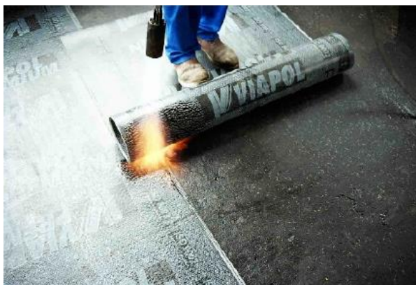
Figura 14: Aplicação de manta asfáltica.
