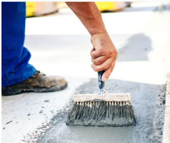
Figura 46: Execução argamassa polimérica.
