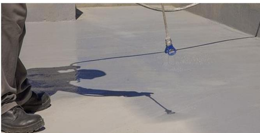
Figura 15: Aplicação de borracha líquida em pavimento de concreto.
