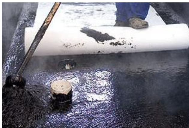
Figura 11: Aplicação a frio de membrana asfáltica.
