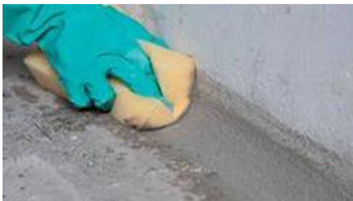
Figura 40: Mísula feita com argamassa.
