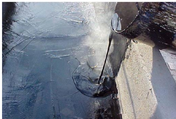
Figura 24: Lançamento da membrana asfáltica a quente.
