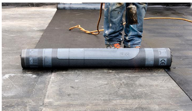
Figura 12: Aplicação a quente de membrana asfáltica.
