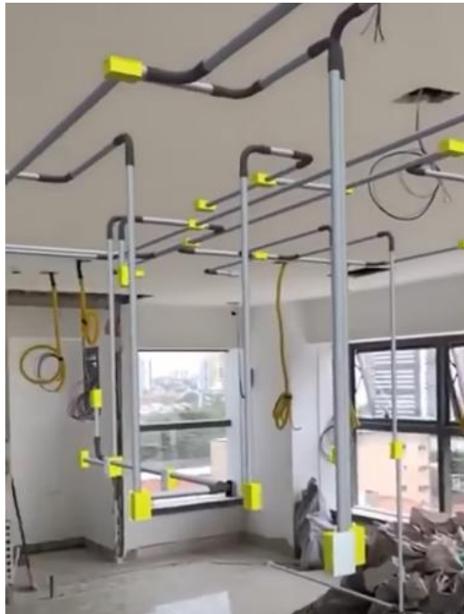
Figura 3.4 – AUGIN utilizado em uma reforma para mostrar as tubulações
