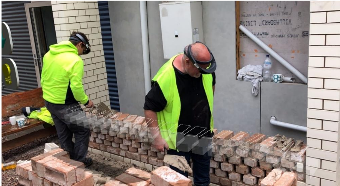
Figura 3.13 – Construção de uma parede curva com auxílio de óculos de realidade aumentada
