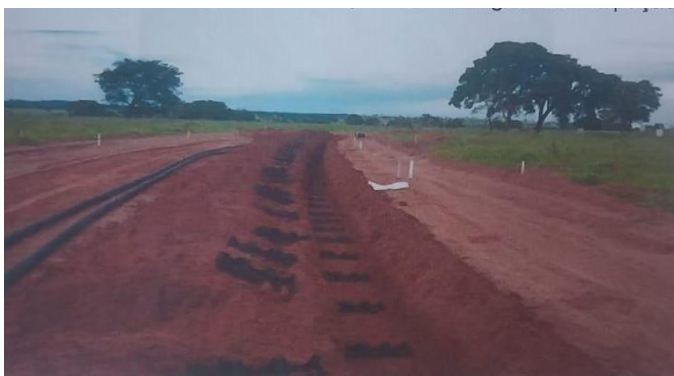
Figura 11: Preparação para Execução do Montagem dos Espaçadores
