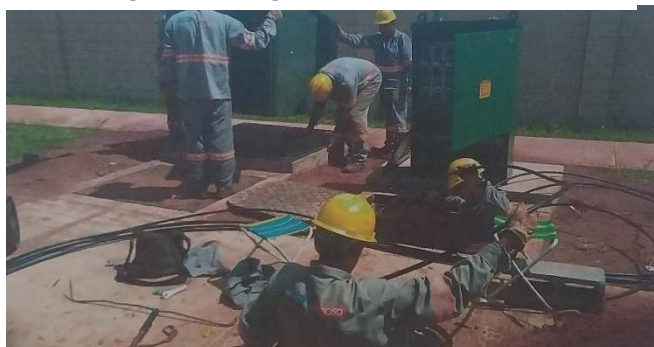
Figura 25: Passagem dos Cabos Elétricos
