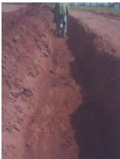
Figura 18: Execução do Reaterro e Compactação da Rede Elétrica Subterrânea
