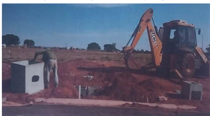
Figura 20: Instalação das caixas de passagem
