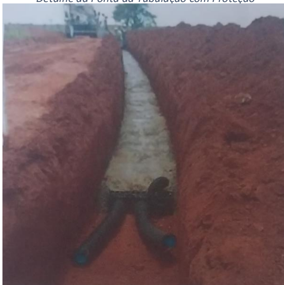
Figura 17: Envelopamento da Rede Elétrica Subterrânea - Detalhe da Ponta da Tubulação com Proteção
