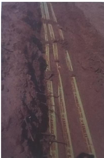
Figura 19: Aplicação das Fitas de Identificação da Rede de Energia Subterrânea
