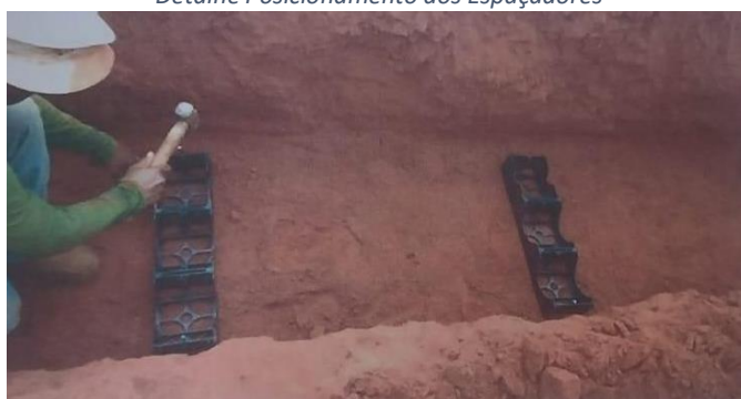
Figura 12: Início da Execução da Montagem dos Espaçadores - Detalhe Posicionamento dos Espaçadores
