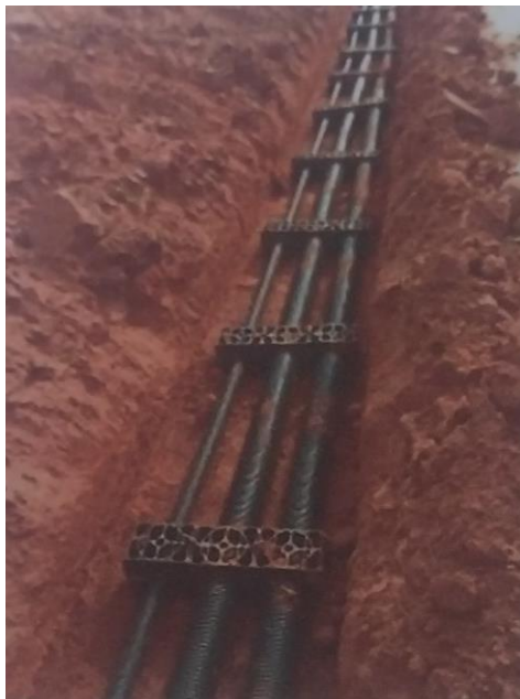
Figura 15: Execução Rede Elétrica de Média e Baixa Tensão
