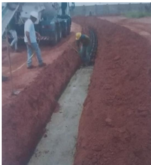
Figura 16: Envelopamento da Rede Elétrica Subterrânea
