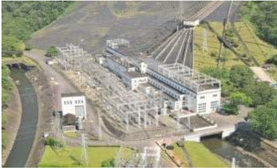
Fig.20: Vista aérea da usina de Henry Borden.
