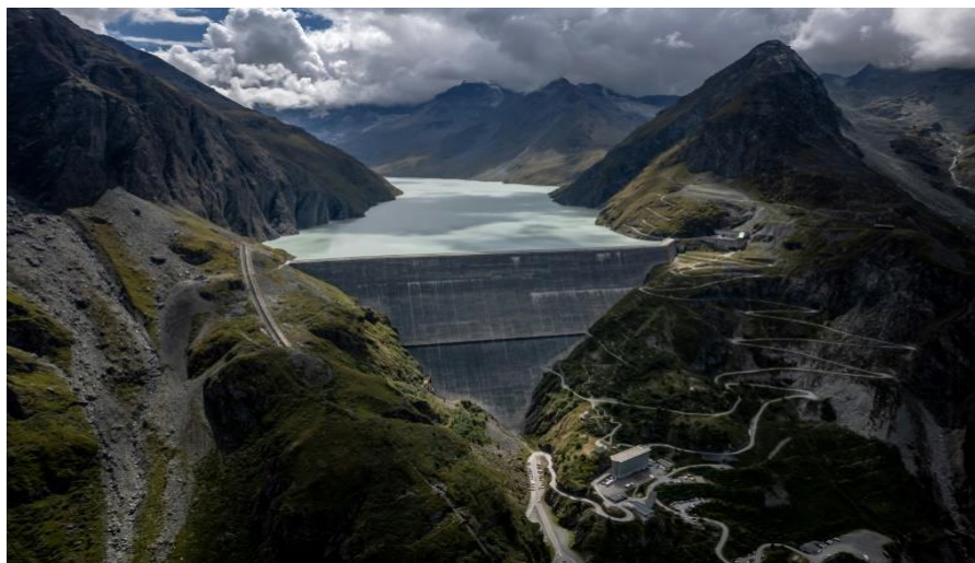
Fig. 19: A barragem Grande Dixence, com 285 metros de altura, no oeste da Suíça.
