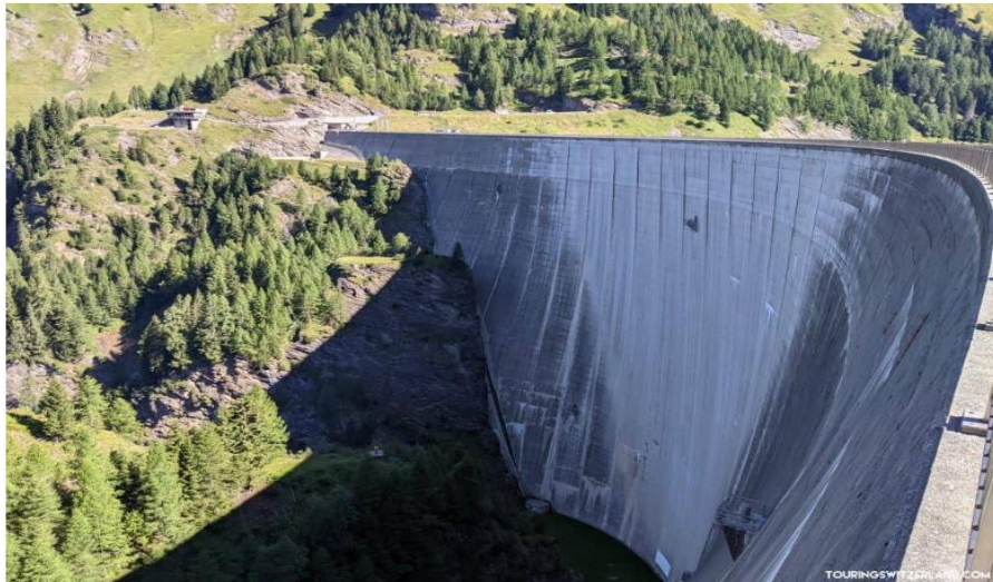
Fig. 18: Imagem da barragem de Luzzone.
