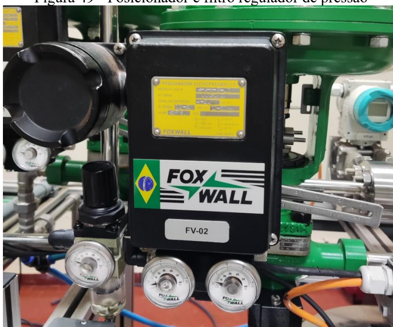
Figura 49 - Posicionador e filtro regulador de pressão
