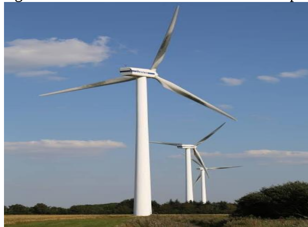
Figura 1.7 - Turbina eólica horizontal com 3 pás.
