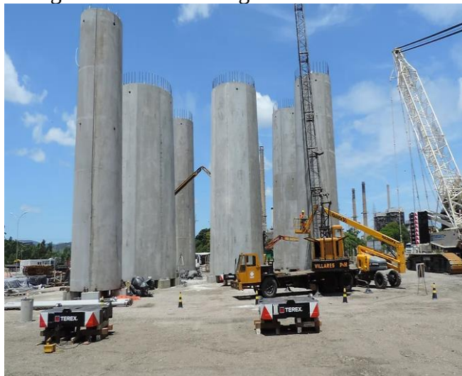
Figura 1.6 - Pré-montagem torre de concreto.
