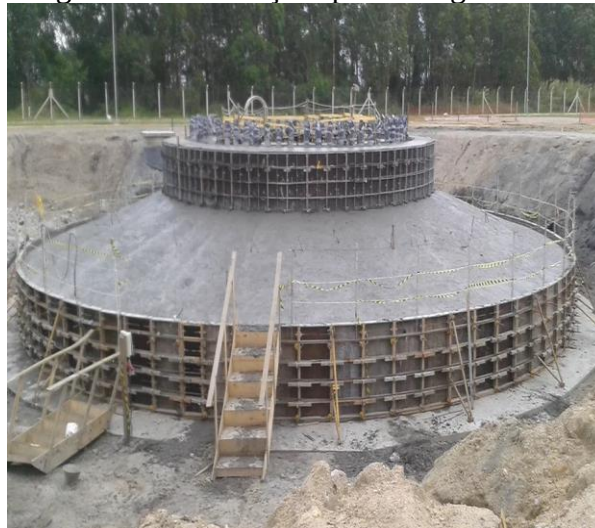
Figura 1.5 - Fundações para aerogeradores.
