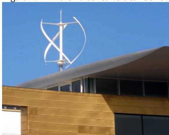
Figura 1.11 - Turbina eólica vertical Gorlov.
