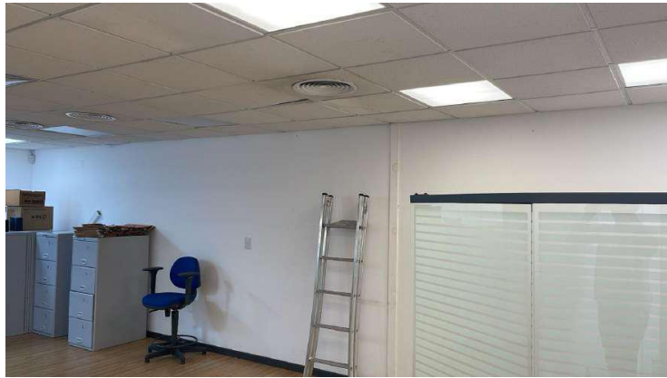
Figura 23 –Parede sendo danificada por má utilização-Agência Y
