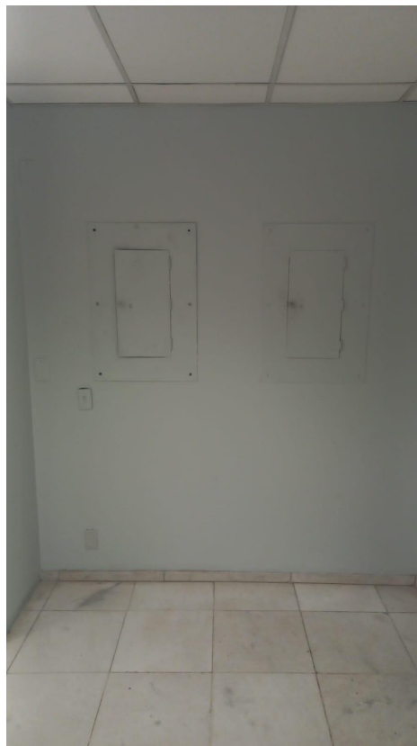
Figura 26 –Piso danificado por má utilização-Agência X
