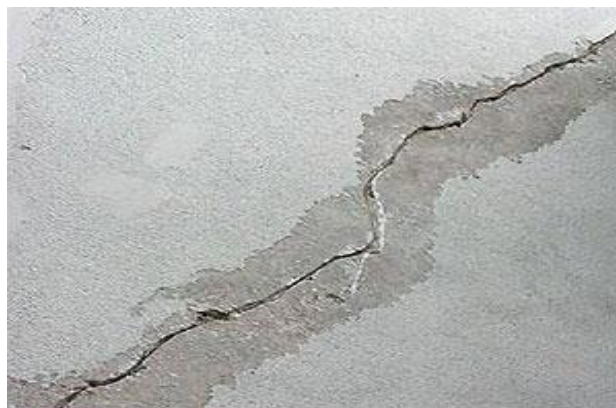
Figura 15 - Fissura geométrica
