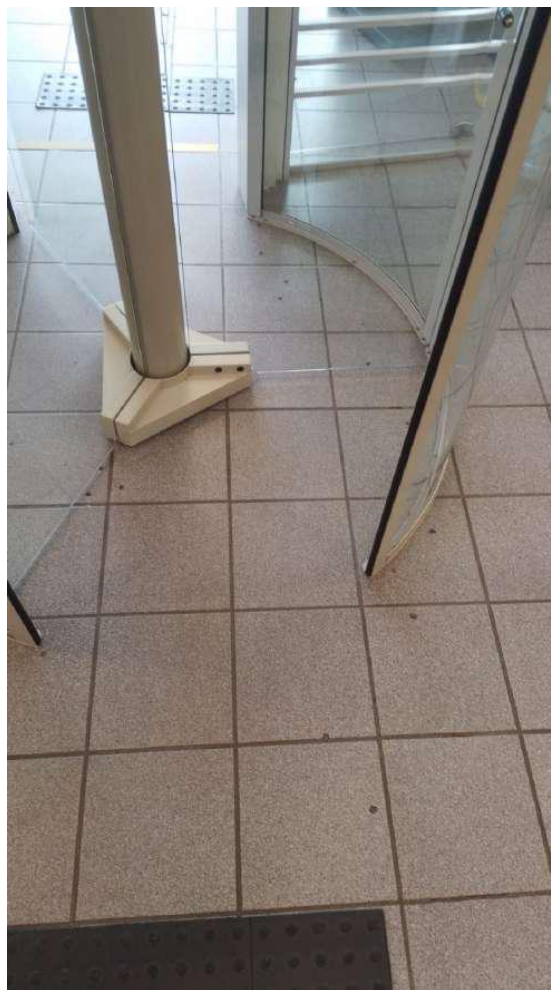
Figura 28 –Piso danificado por má utilização-Agência Z
