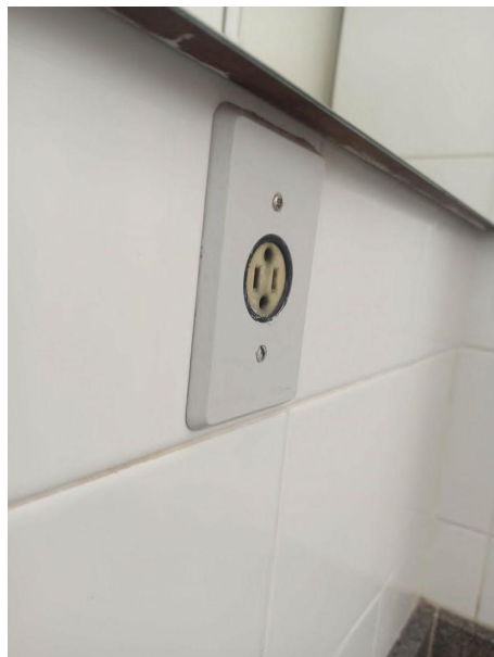
Figura 34 –Ponto elétrico fora do padrão de projeto -Agência X
