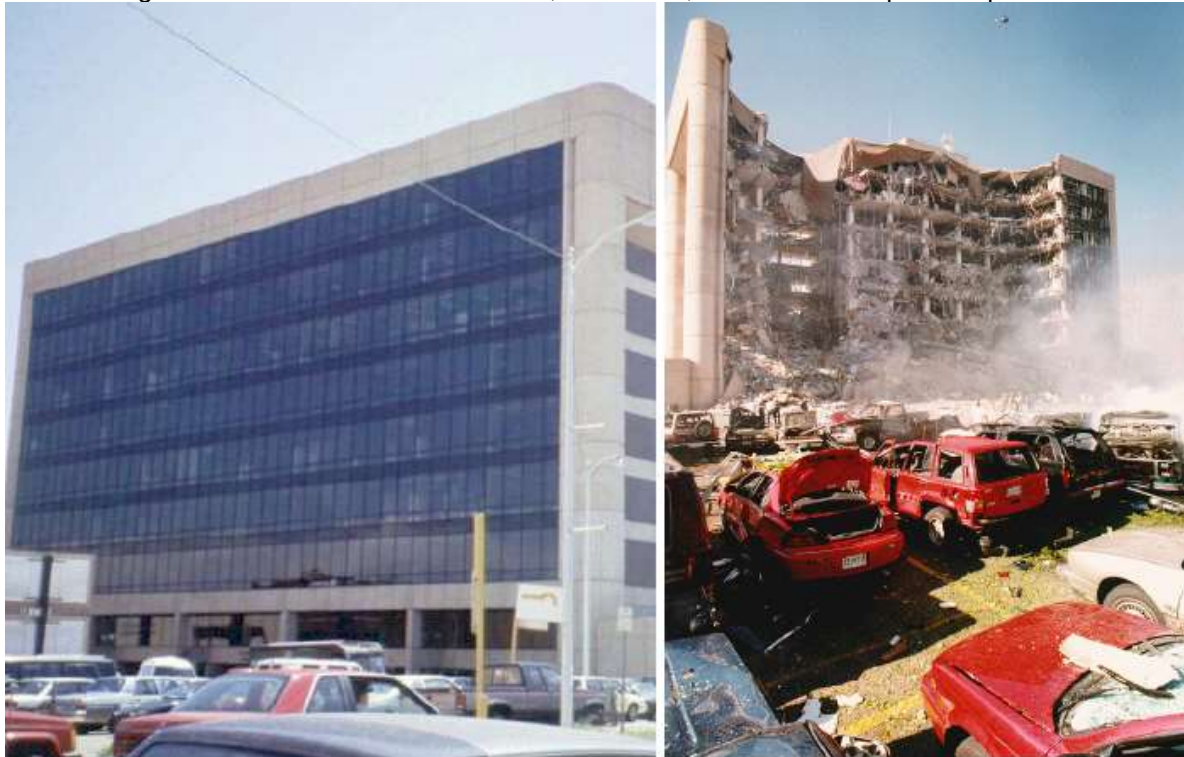
Figura 12 – Edifício Alfred P. Murrah, Oklahoma, 1995. Antes e após a explosão.
