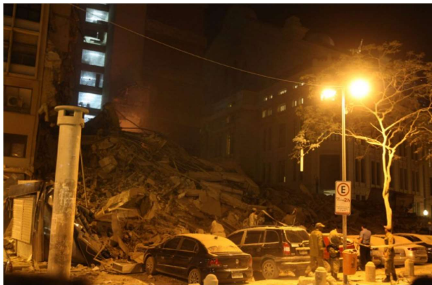
Figura 13 – Escombros do desabamento do Edifício Liberdade e prédios vizinhos.
