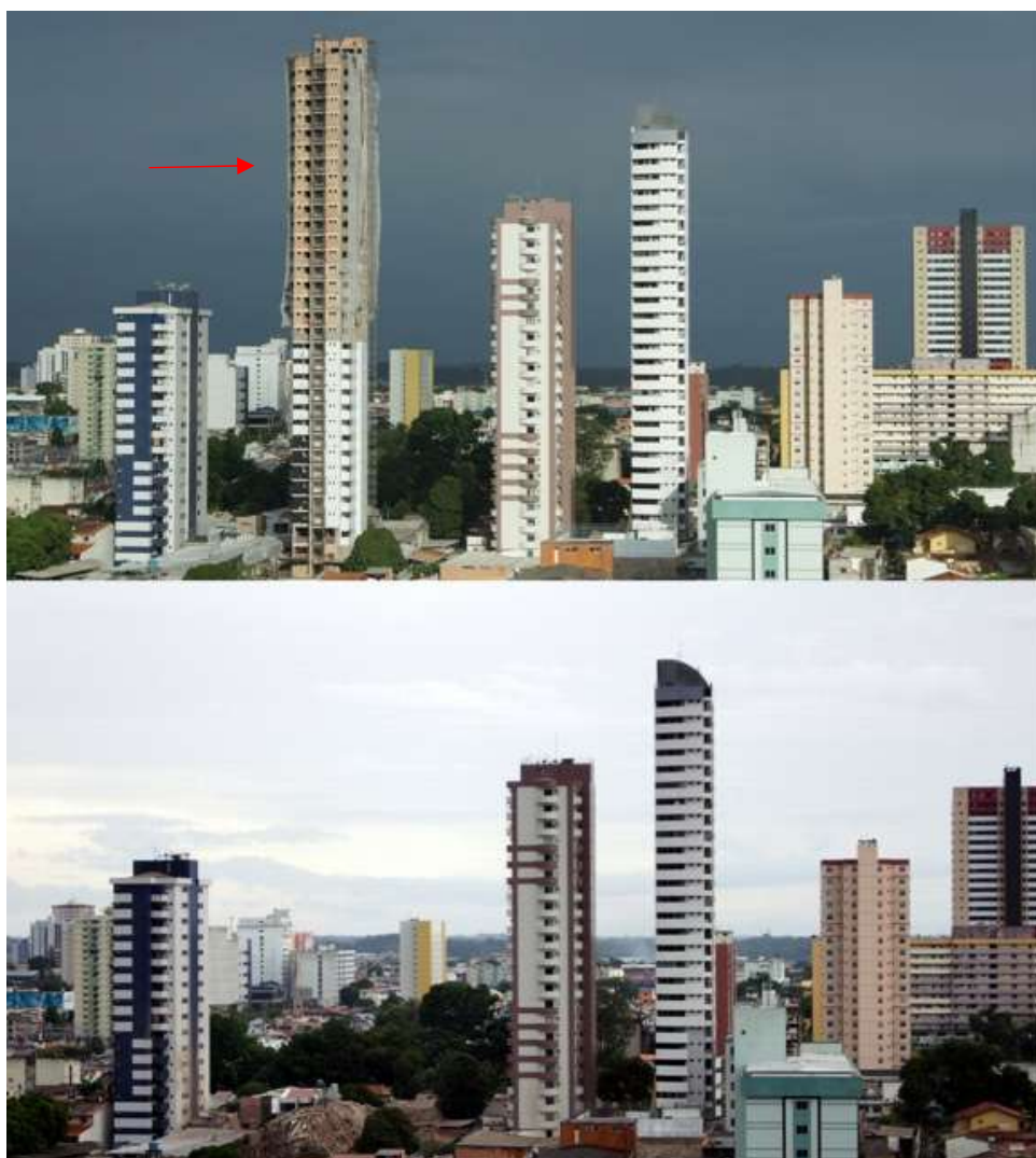
Figura 14 – Real Class antes e após o colapso.
