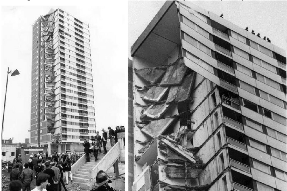
Figura 11 – Edifício Ronan Point, Londres, 1968. Destruição causada pela explosão.
