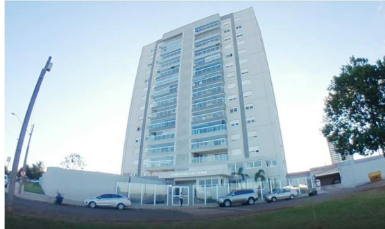
Figura 3.1 – Fachada do edifício.
