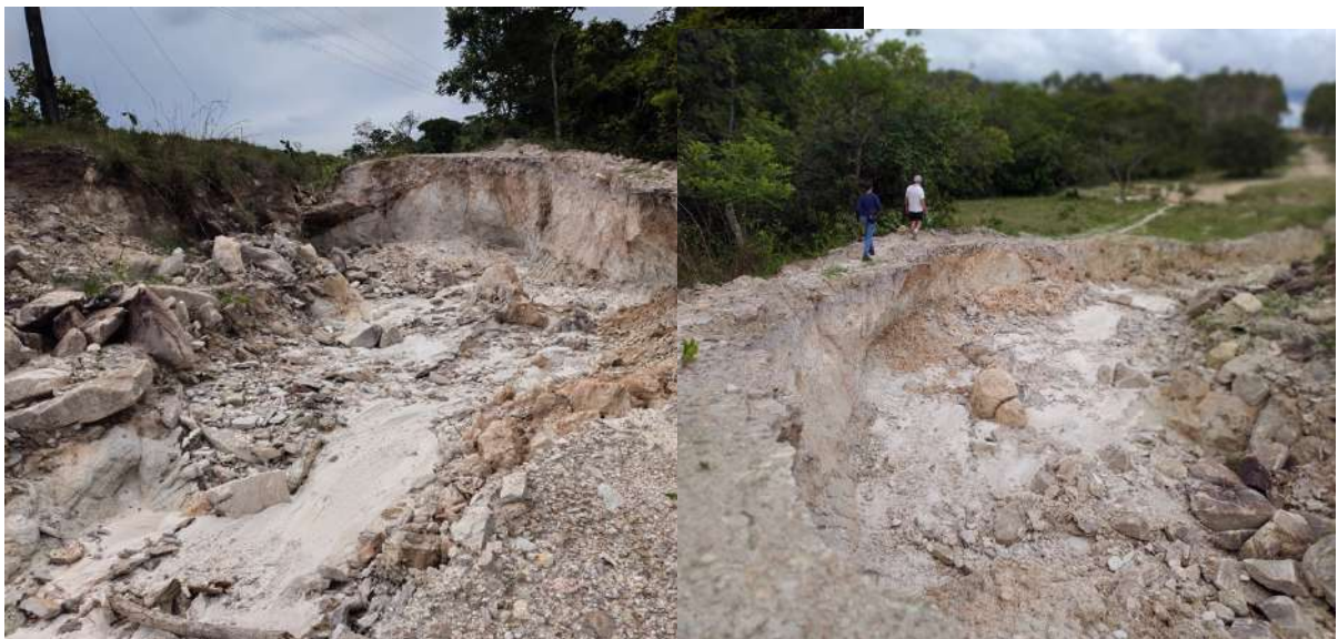
Figura 13 : Área de voçoroca, ao lado da rodovia e acima da nascente 01, fazenda Jatobá em 2024. Fonte: imagem capturada pelo próprio autor.
