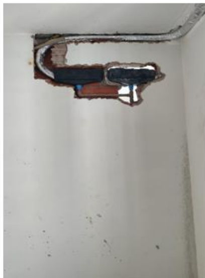
Figura 5 – Quebra de alvenaria para adição de caixa de passagem extra
