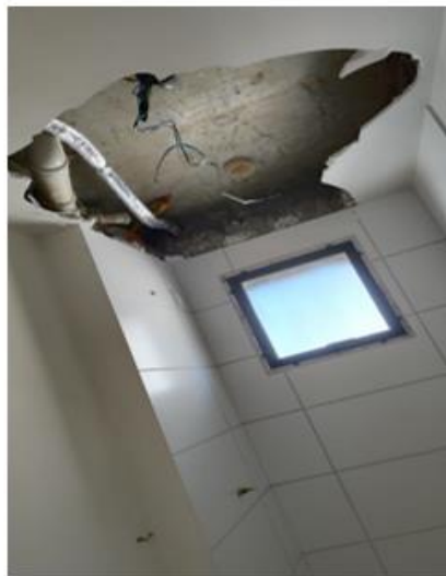
Figura 2 - Quebra do gesso em placa
