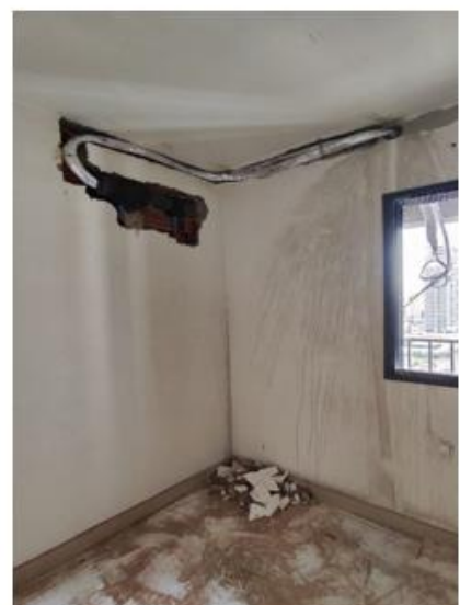
Figura 6 – Adição da tubulação da nova rede frigorígena
