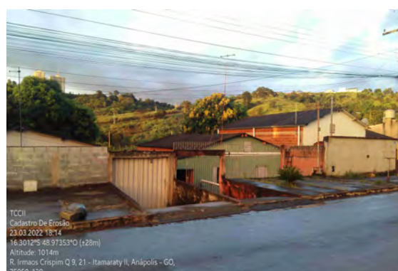
(b) O nível da pavimentação ficou muito elevado.
