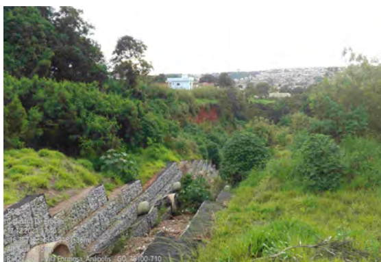
(c) Vista lateral do muro de gabião.
