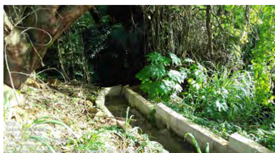
(d) Caneleta longitudinal com desnível de aproximadamente 15 m.
