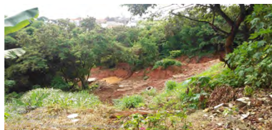
(b) Voçoroca com desnível de aproximadamente 20 m.
