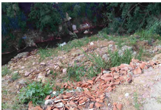
(a) Inclinação do terreno e entulho.
