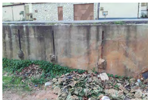
(d) Muro atirantado na rua Leopoldo de Bulhões.
