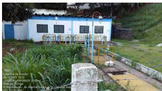
(c) Estação elevatória de esgoto.
