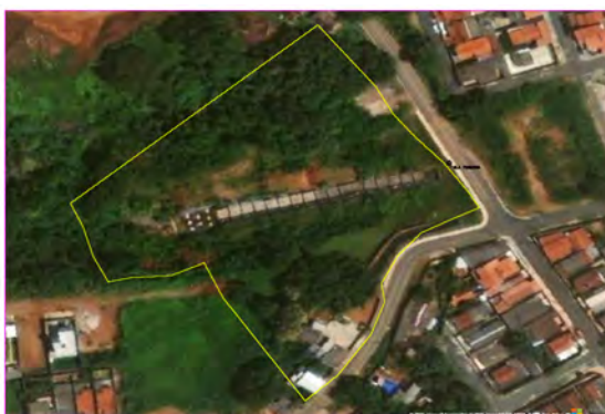
(a) Área demarcada da erosão margem fluvial.
