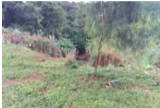
(b) Voçoroca com desnível de aproximadamente 10 m.
