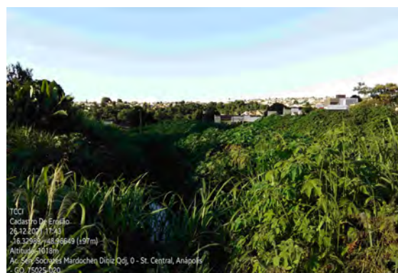
(d) A vegetação encobre a erosão.
