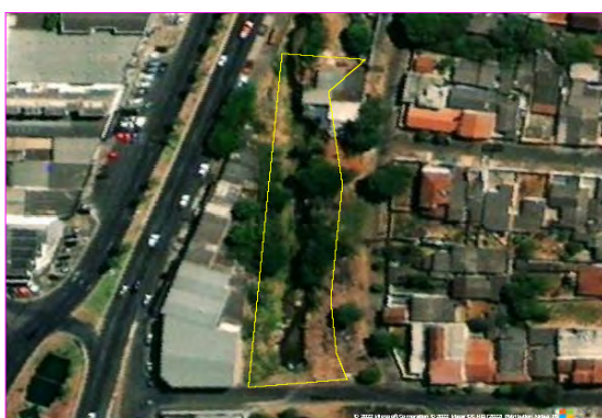
(a) Área demarcada da erosão margem fluvial.
