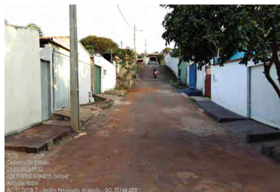
(d) Final da Rua 11 com uma inclinação acentuada.
