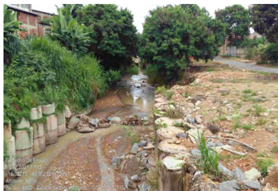
(d) Terreno ingreme com entulho.
