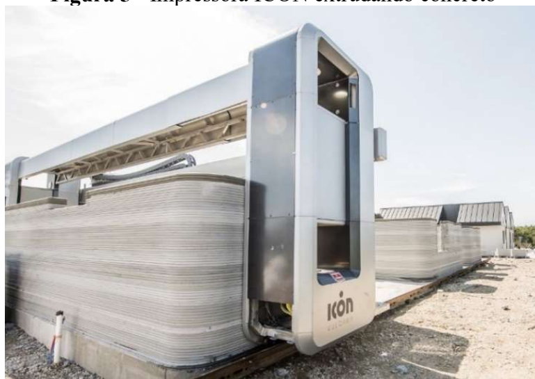
Figura 5 - Impressora ICON extrudando concreto
