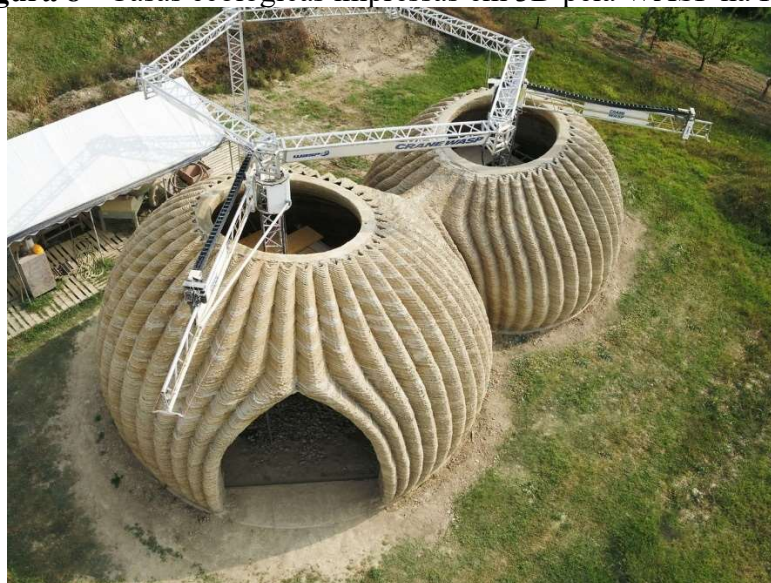
Figura 8 - Casas ecológicas impressas em 3D pela WASP na Itália
