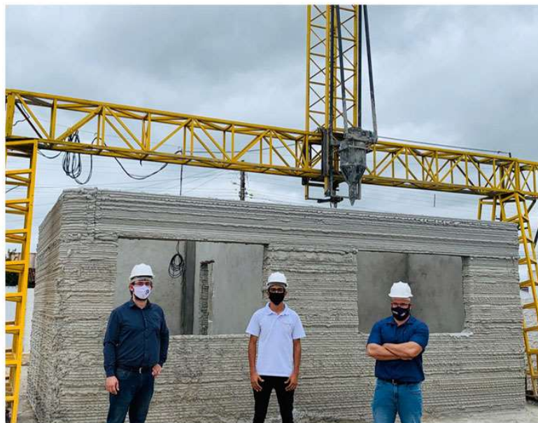
Figura 11 - Engenheiros responsáveis pelo empreendimento ainda na fase construtiva
