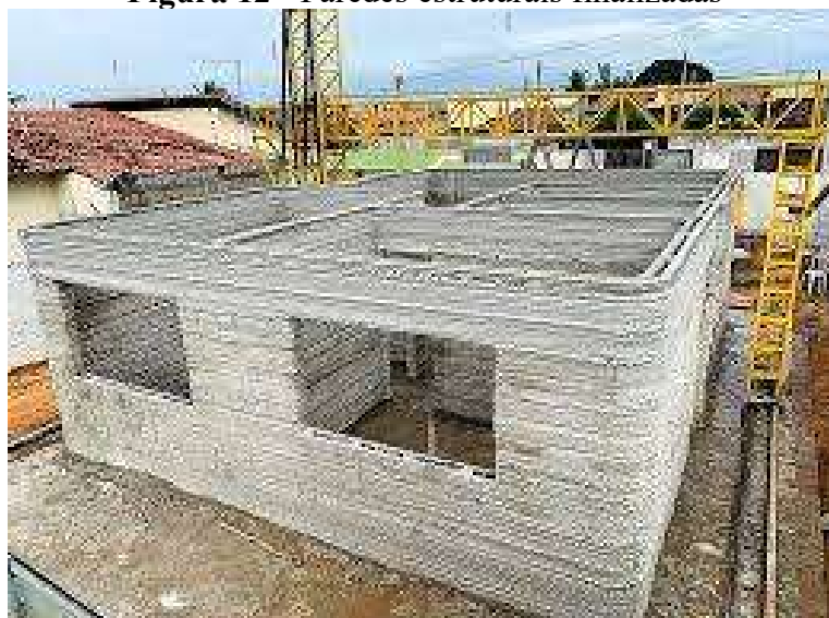
Figura 12 - Paredes estruturais finalizadas
