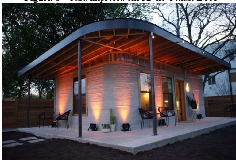
Figura 6 - Casa impressa em 3D no Texas, EUA
