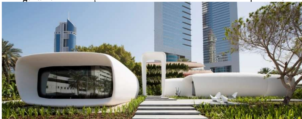
Figura 10 - Construção do Dubai Future Foundation com impressão 3D
