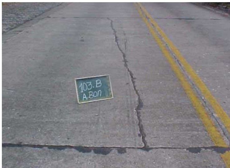
Figura 12 -Trinca longitudinal
