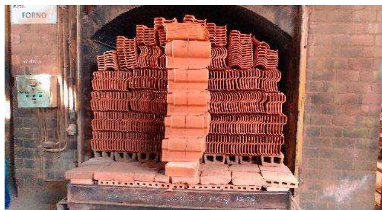
Figura 8 – Fornos do tipo contínuo (Túnel).
