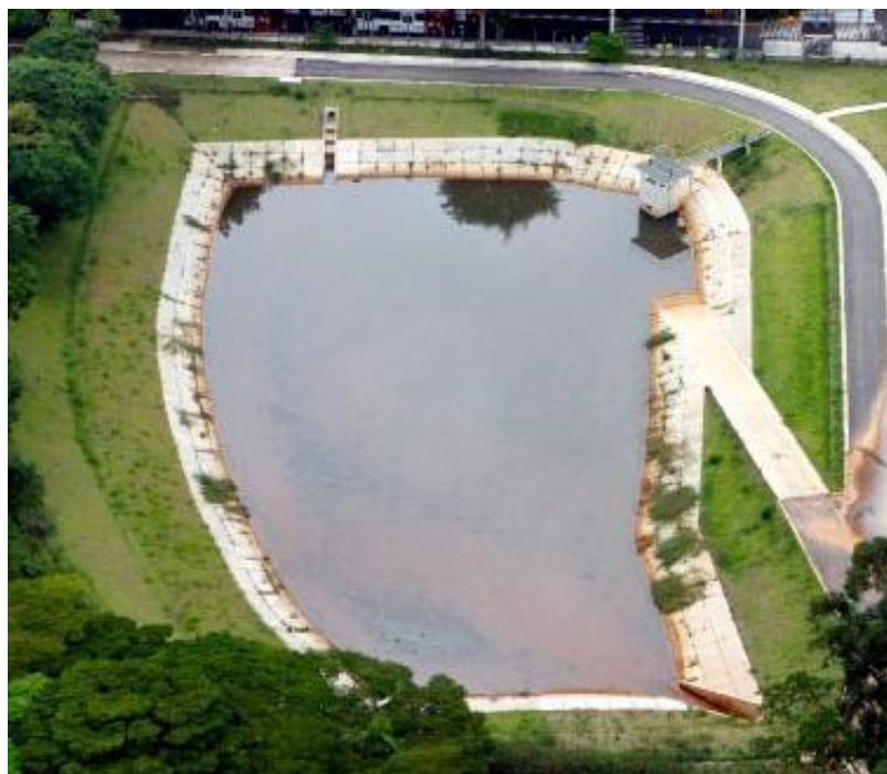
Figura 18 - Reservatório de Detenção
