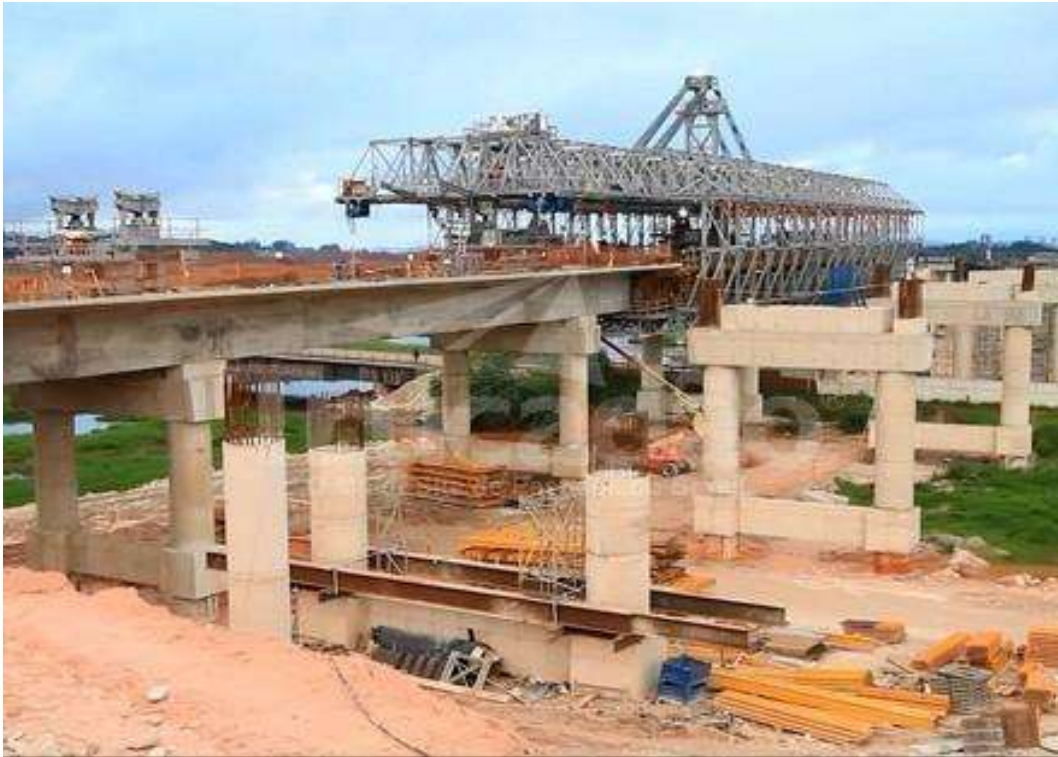
Figura 2.10 - Execução de cimbramento móvel
