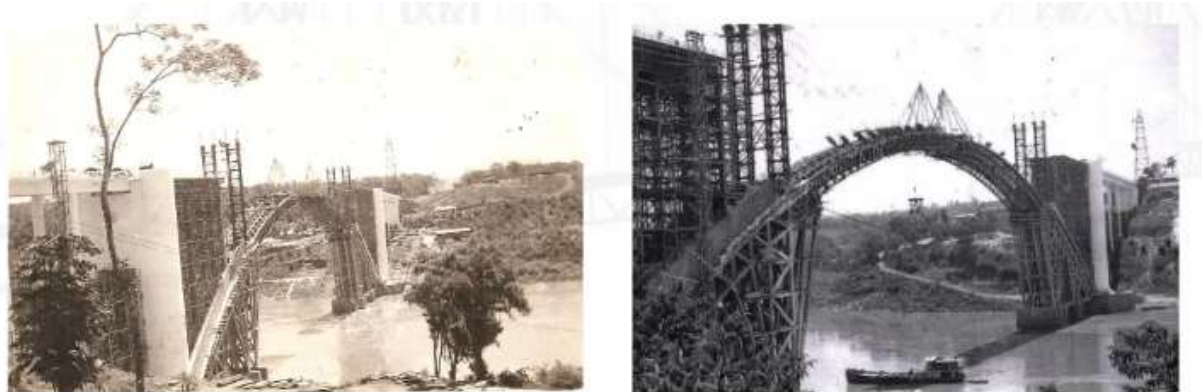
Figura 2.6 - Cimbramento fixo em ponte
