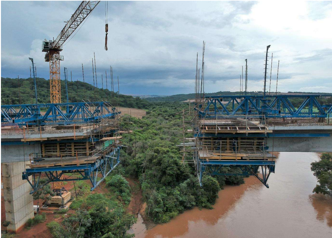
Figura 2.9 - Balanço sucessivo sobre a ponte do Rio Claro
