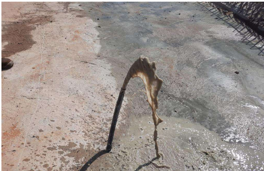
Figura 3.6 - Finalização de injeção de nata de cimento
