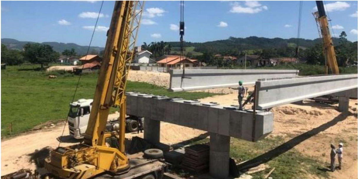
Figura 2.7 - Lançamento de vigas pré-moldadas na ponte da União em Braço do Norte
