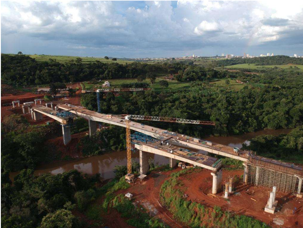
Figura 3.1 - Ponte sobre o Rio Claro
