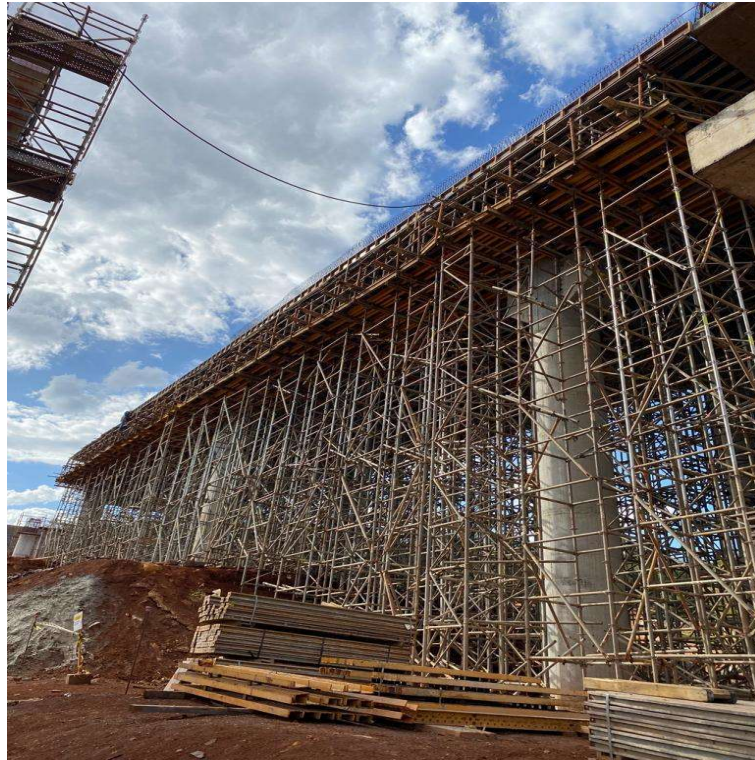
Figura 2.5 - Cimbramento fixo em viaduto
