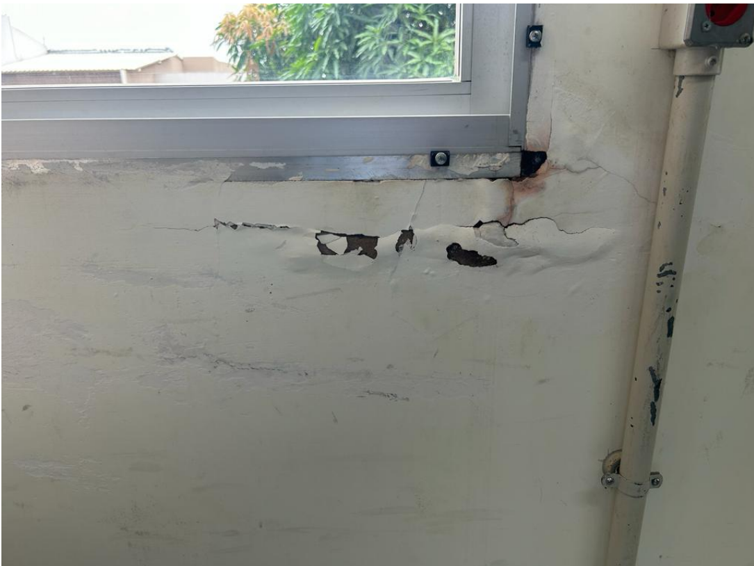
Figura 4.27 – Estufamento da pintura com a massa PVA por infiltração em parede interna
