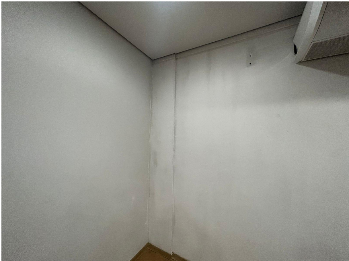
Figura 4.3 – Repintura do miniauditório 1
