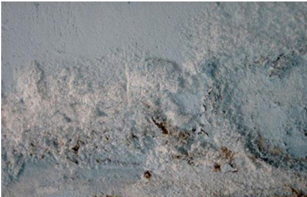
Figura 2.12 – Saponificação de tinta
