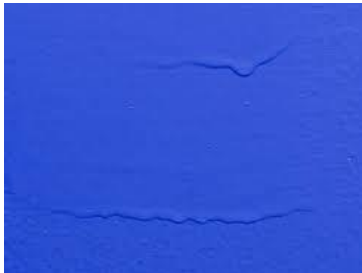
Figura 2.6 – Escorrimento de tinta
