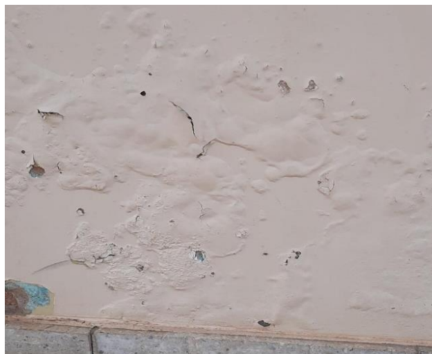
Figura 2.8 – Bolhas ou estufamento na pintura
