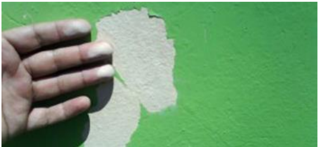
Figura 2.13 – Calcinação de tinta
