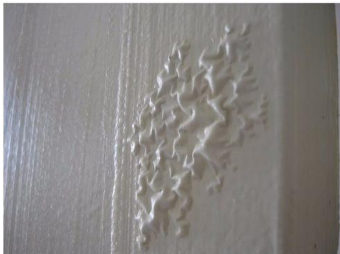
Figura 2.5 – Enrugamento ou encolhimento
