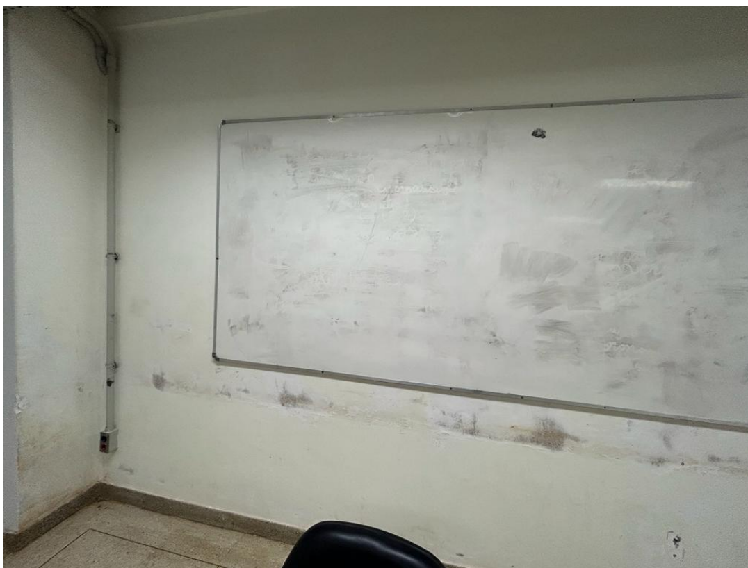
Figura 4.15 – Desgaste da pintura por atrito e sujidades
