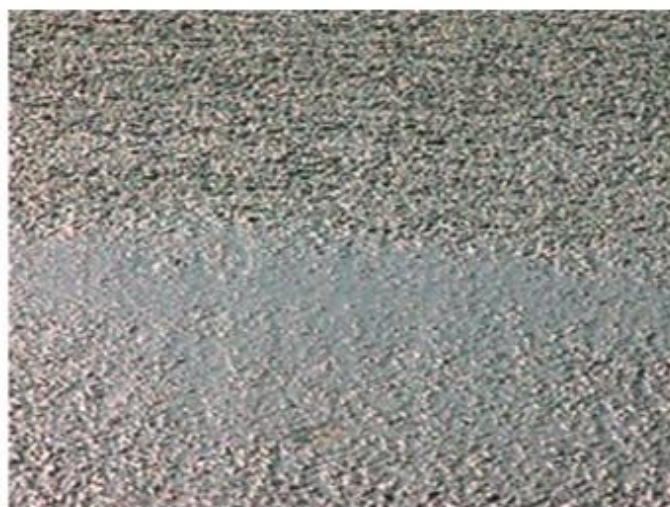
Figura 18 - Exsudação em detalhe
