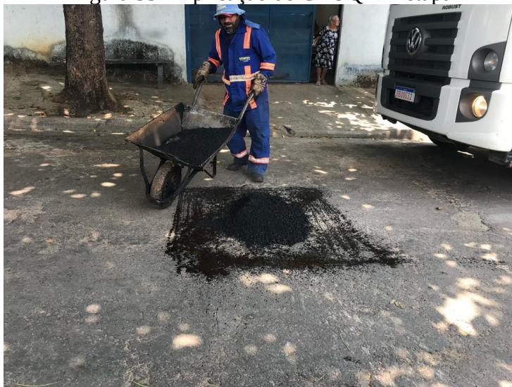
Figura 35 - Aplicação de CBUQ - 2ª etapa
