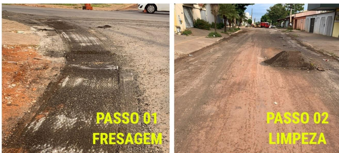
Figura 65 - Fresagem e limpeza no processo de recapeamento – Etapa Complementar 2
