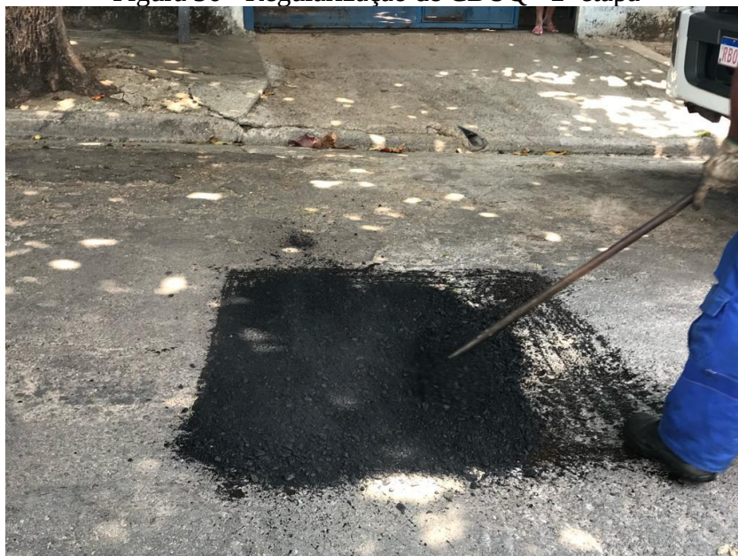
Figura 36 - Regularização de CBUQ - 2ª etapa
