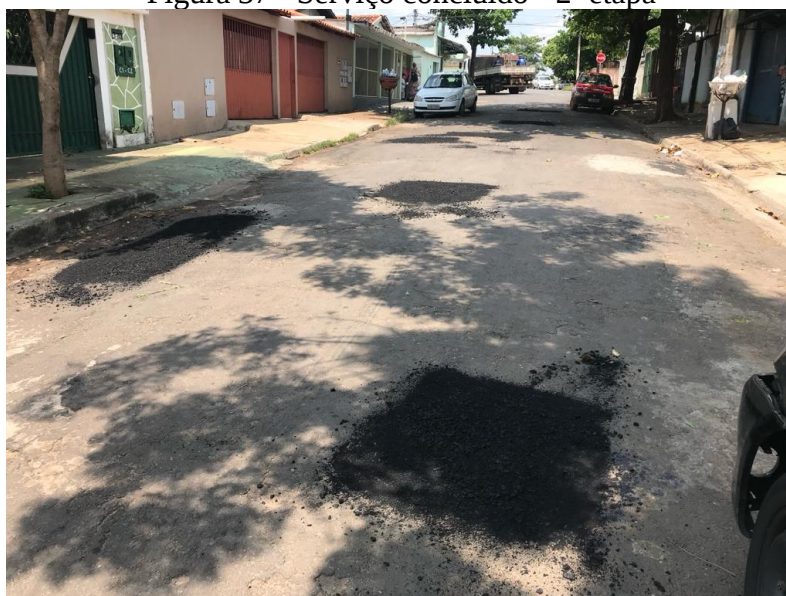
Figura 37 - Serviço concluído - 2ª etapa
