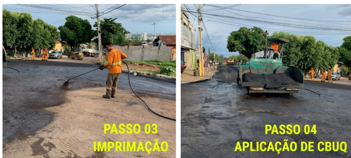
Figura 66 - Imprimação e CBUQ – Etapa Complementar 2
