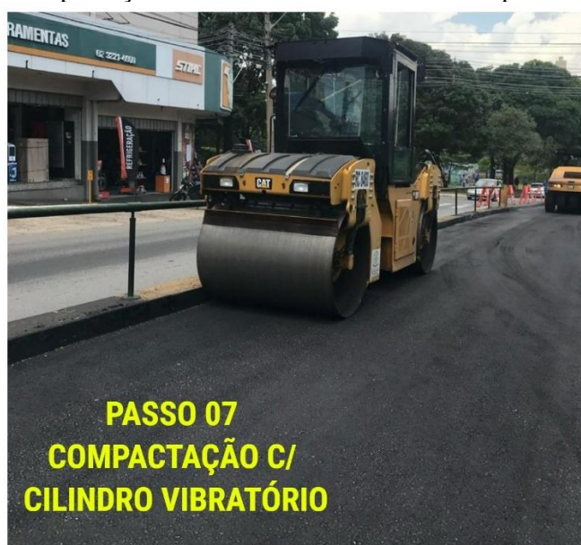
Figura 64 - Compactação com cilindro vibratório – Etapa Complementar 1
