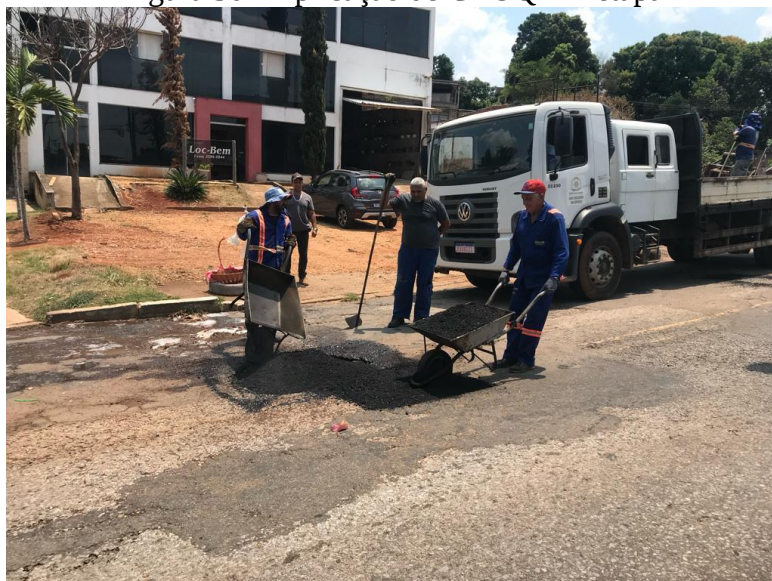
Figura 30 - Aplicação de CBUQ - 1ª etapa
