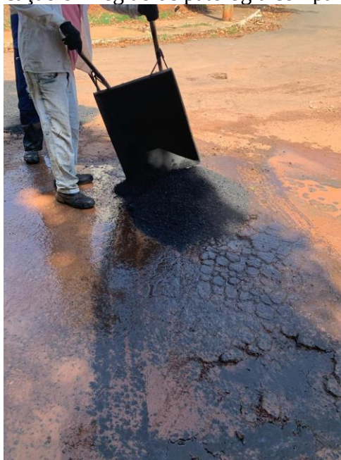
Figura 49 - Aplicação em região de patologia compartilhada - 4ª etapa
