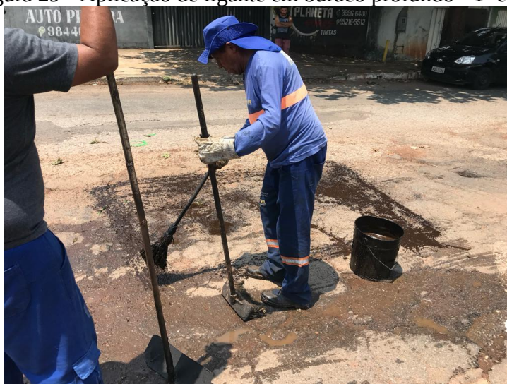
Figura 29 - Aplicação de ligante em buraco profundo - 1ª etapa
