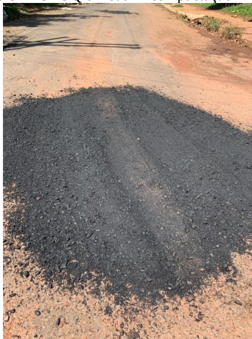
Figura 51 - CBUQ em sua 1ª compactação - 4ª etapa
