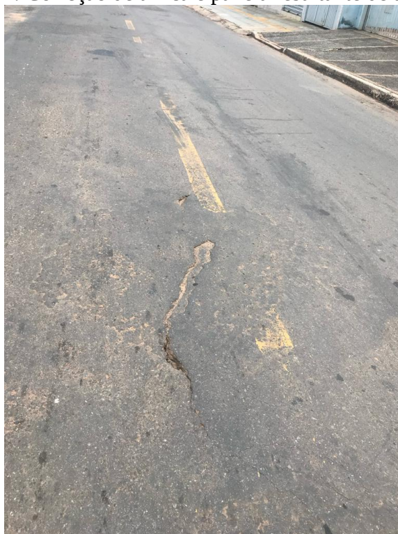
Figura 57 - Patologia 1: Correção de trinca e panela resultante de afundamento - 5ª etapa
