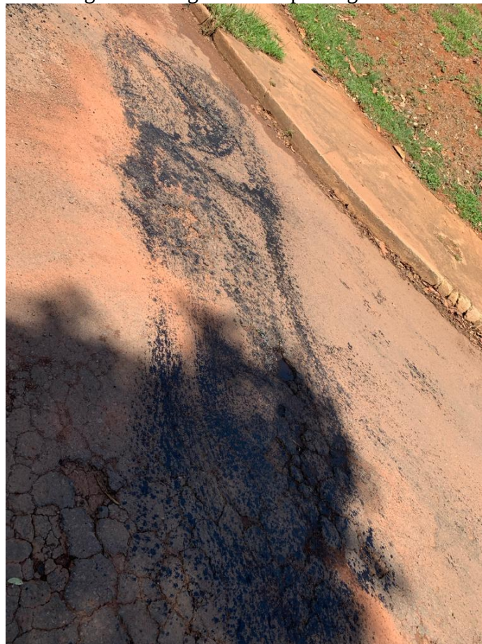
Figura 53 - Abrangência de ligante em 4 patologias associadas - 4ª etapa
