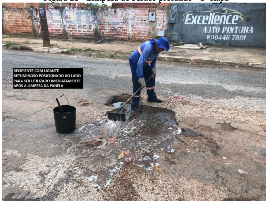
Figura 28 - Limpeza de buraco profundo - 1ª etapa
