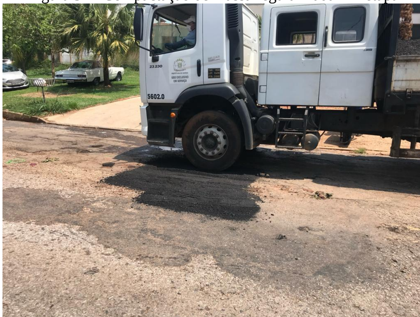
Figura 32 - Compactação de massa regularizada - 1ª etapa
