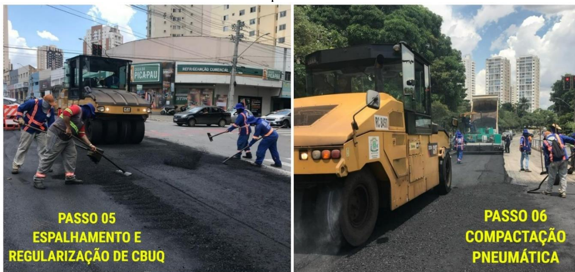
Figura 63 - Espalhamento/Regularização de CBUQ e Compactação Pneumática – Etapa Complementar 1
