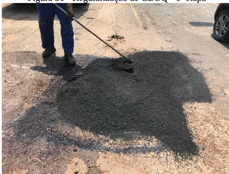
Figura 31 - Regularização de CBUQ - 1ª etapa
