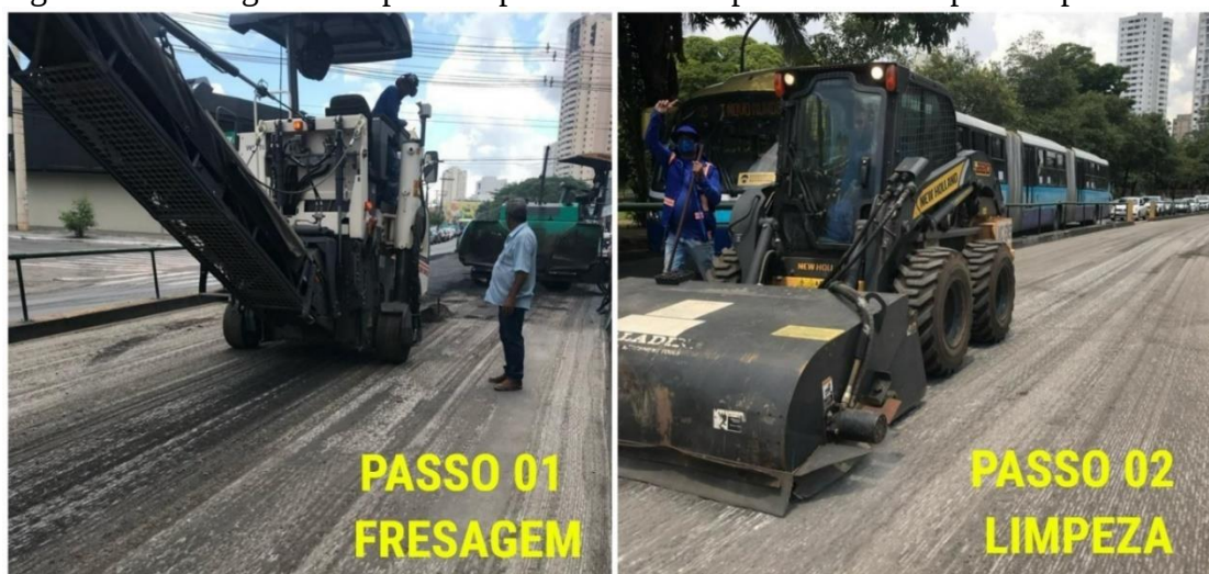
Figura 61 - Fresagem e limpeza no processo de recapeamento – Etapa Complementar 1
