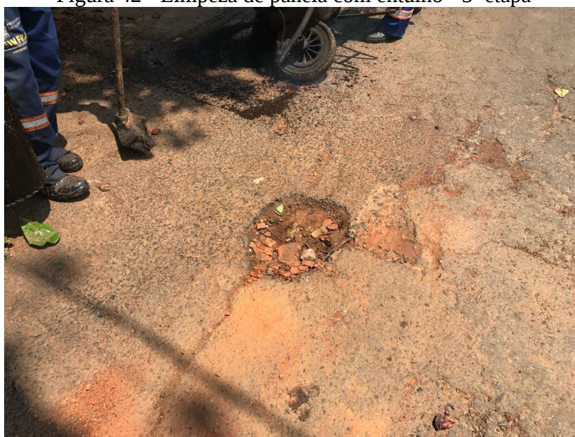
Figura 42 - Limpeza de panela com entulho - 3ª etapa
