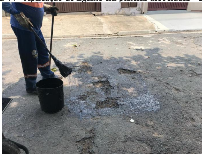
Figura 44 - Aplicação de ligante em panelas associadas - 3ª etapa
