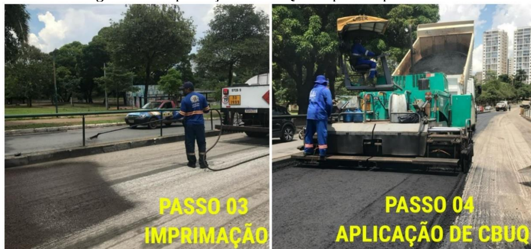
Figura 62 - Imprimação e CBUQ – Etapa Complementar 1
