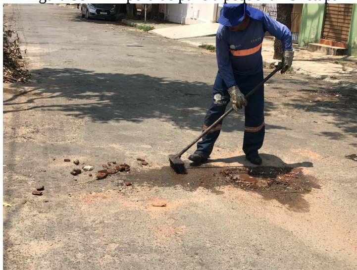
Figura 38 - Limpeza de panela pequena - 3ª etapa
