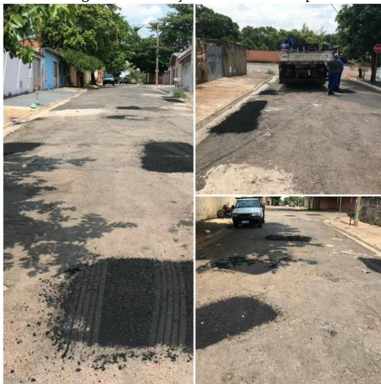
Figura 46 - Serviço concluído - 3ª etapa
