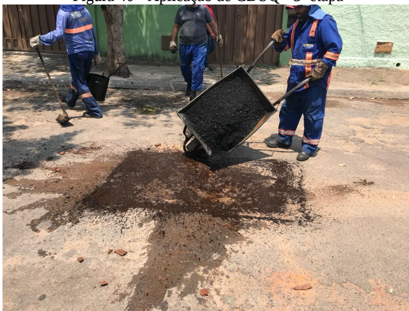
Figura 40 - Aplicação de CBUQ - 3ª etapa
