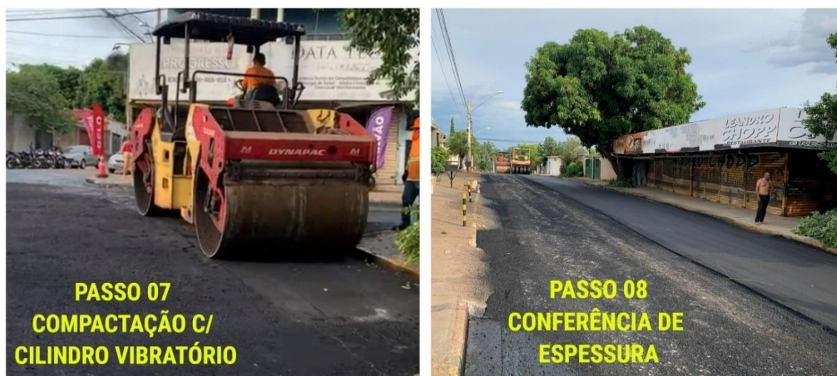
Figura 68 - Compactação com cilindro vibratório e conferência de espessura – Etapa Complementar 2
