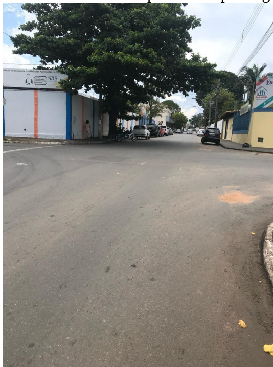
Figura 55 - Padrão do trecho recapeado sem patologias - 5ª etapa
