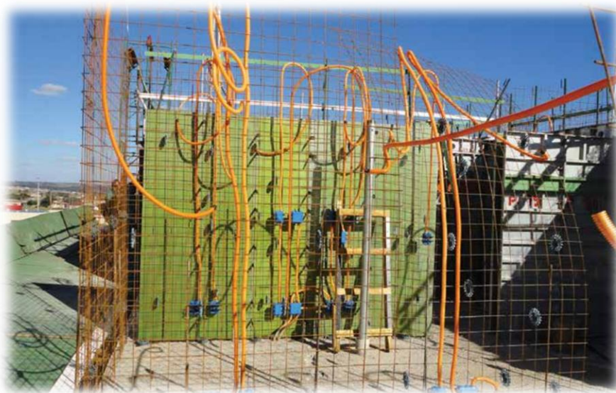
Figura 5. Armação das paredes como suporte para instalações elétricas.
