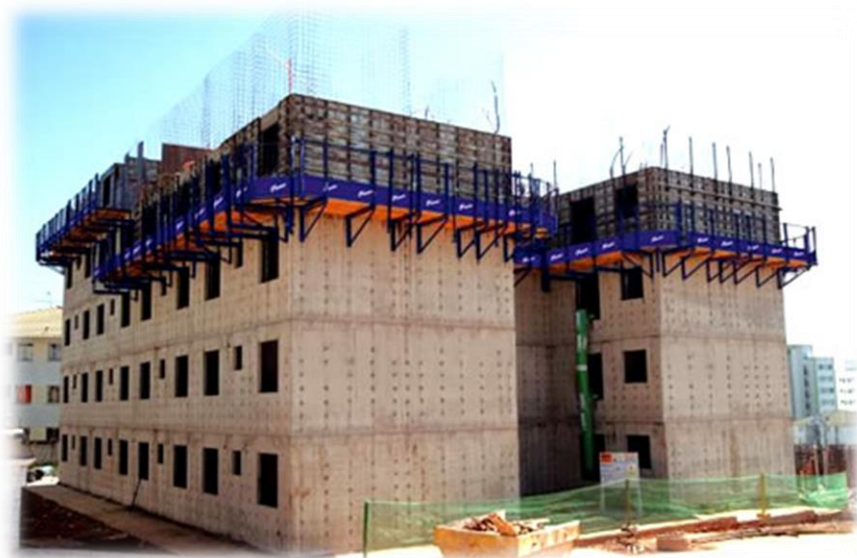
Figura 4. Obra em parede de concreto
