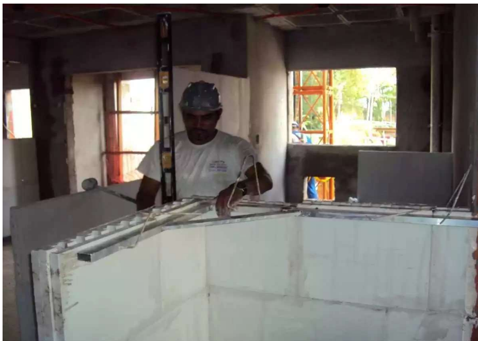
Figura 2 – Alvenaria de vedação com blocos de gesso
