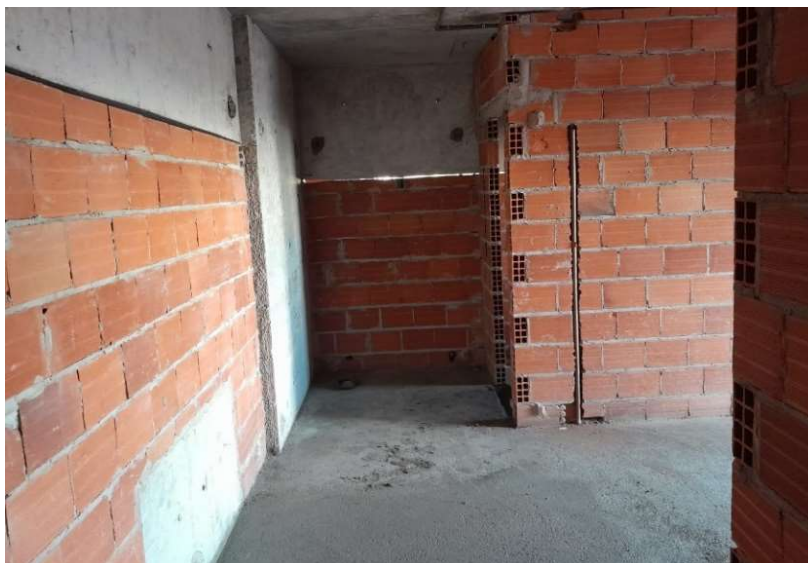
Figura 1 - Alvenaria de vedação com blocos de cerâmica
