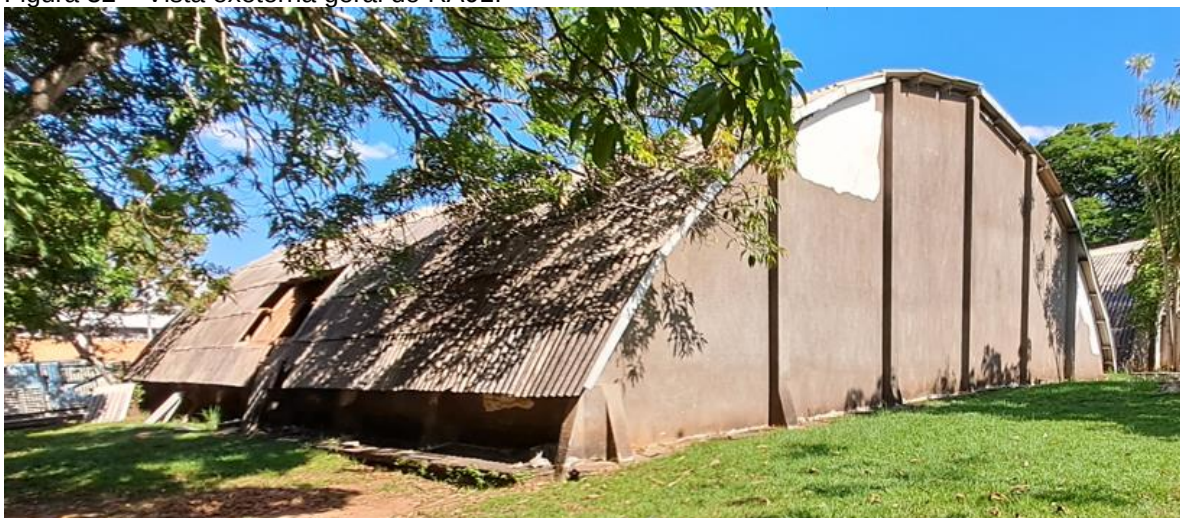
Figura 32 – Vista exeterna geral do RA01.
