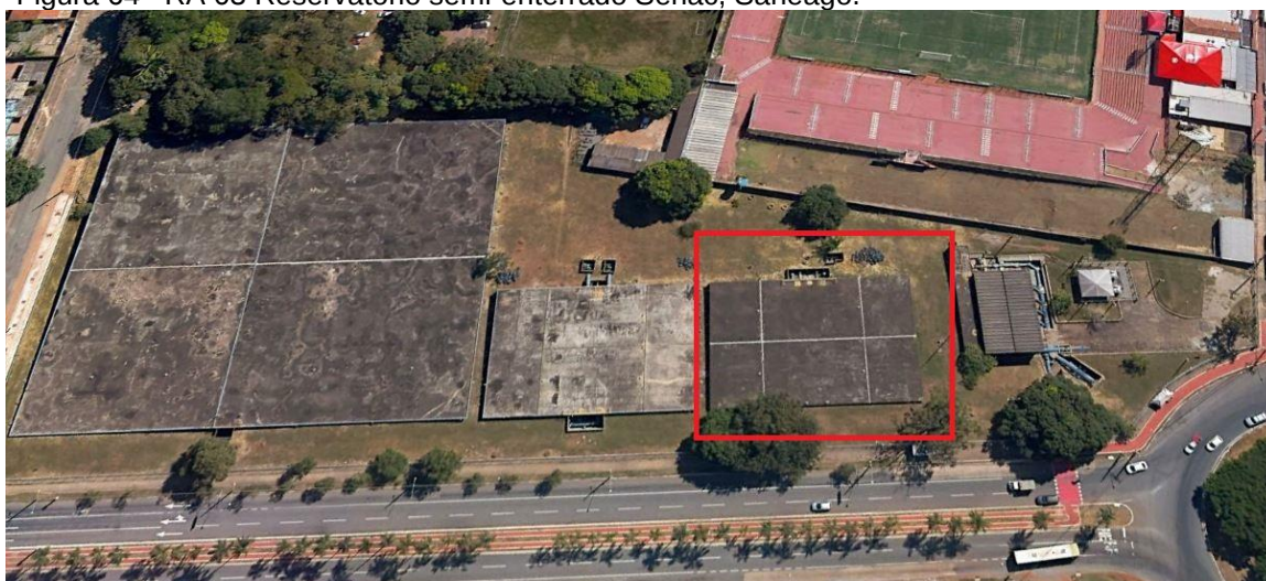
Figura 64– RA 03 Reservatório semi-enterrado Senac, Saneago.
