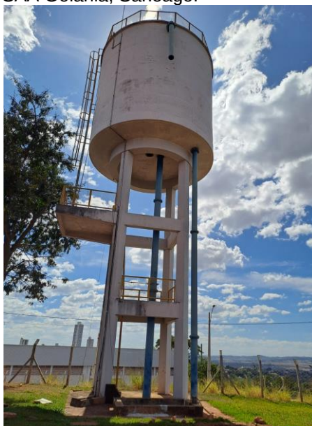
Figura 7 – Reservatório elevado SAA Goiânia, Saneago.
