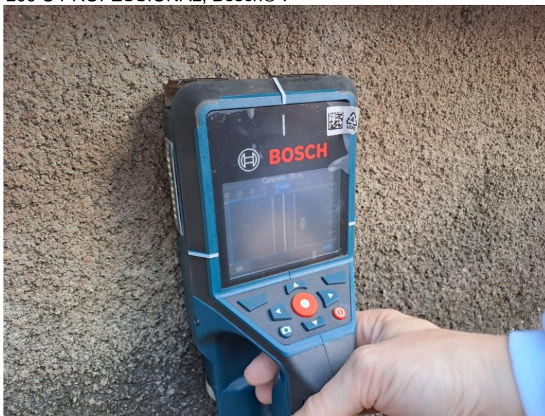
Figura 49 – Escaneamento da parede para identificação do cobrimento parede RA02 utilizando o scanner de parede “D-TECT 200 C PROFESSIONAL, Bosch®”.
