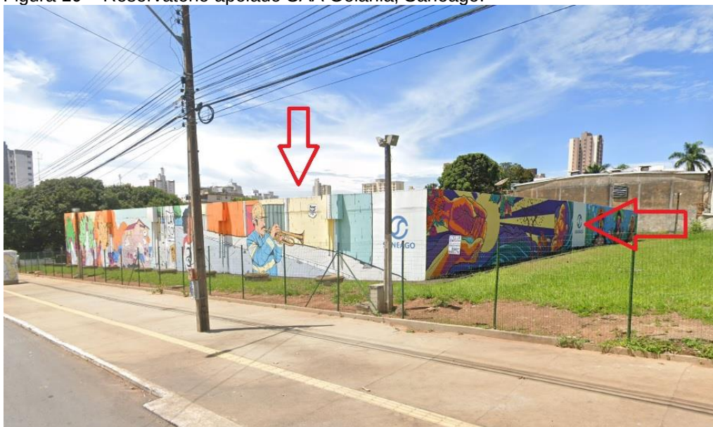
Figura 10 – Reservatório apoiado SAA Goiânia, Saneago.
