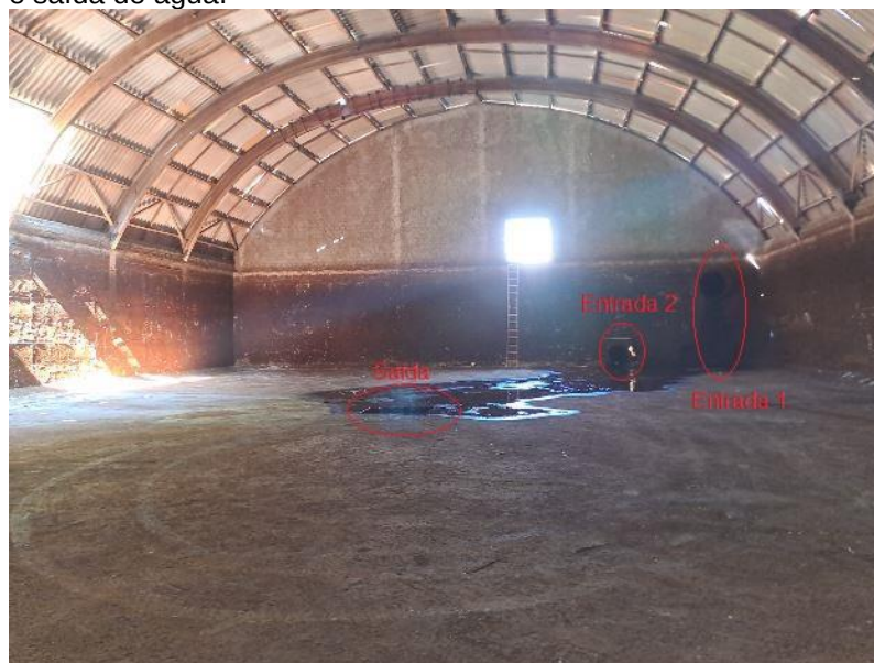
Figura 37 – Vista interna geral do RA01, identificando as entradas e saída de água.
