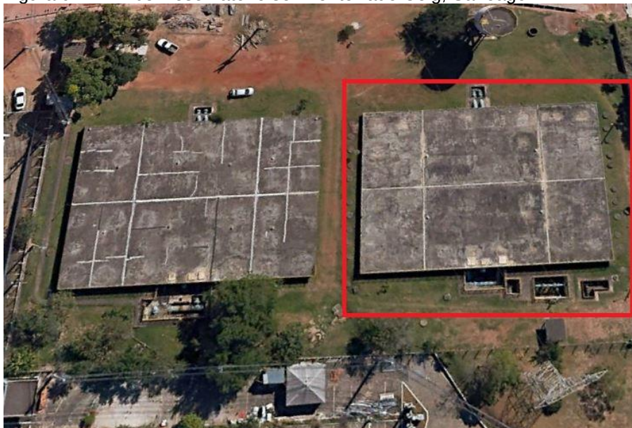
Figura 94 – RA 05 Reservatório semi-enterrado Celg, Saneago.
