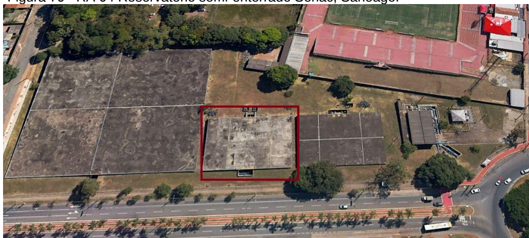
Figura 79 –RA 04 Reservatório semi-enterrado Senac, Saneago.
