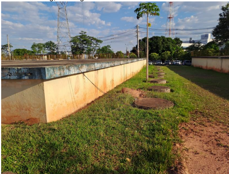
Figura 96 – Vista externa geral do RA 05 Reservatório semi-enterrado Celg, Saneago
