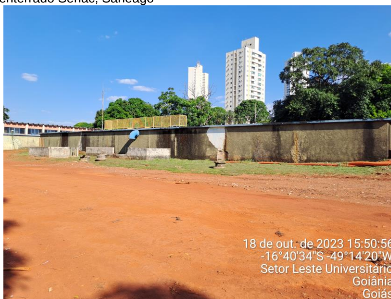
Figura 65 – Vista externa geral do RA 03 Reservatório semi-enterrado Senac, Saneago
