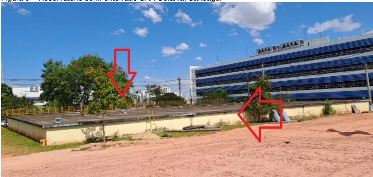
Figura 9 – Reservatório semi-enterrado SAA Goiânia, Saneago.
