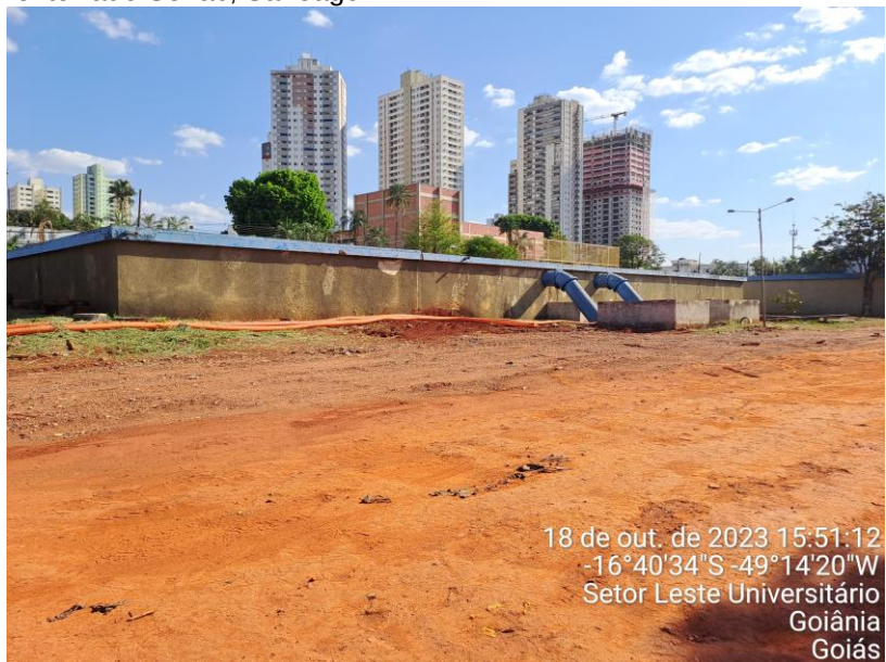
Figura 80 – Vista externa geral do RA 04 Reservatório semi-enterrado Senac, Saneago.
