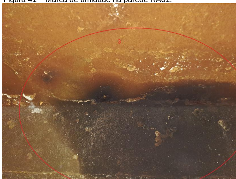
Figura 41 – Marca de umidade na parede RA01.
