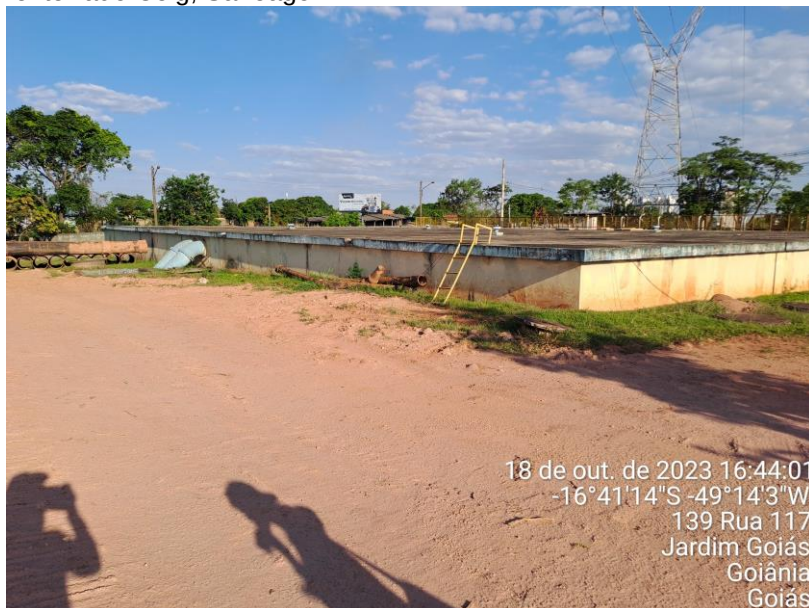
Figura 95 – Vista externa geral do RA 05 Reservatório semi-enterrado Celg, Saneago.
