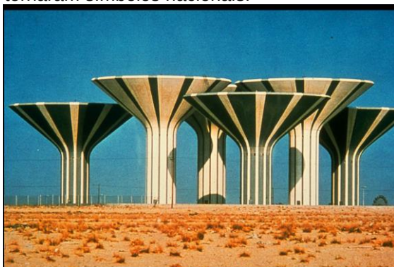
Figura 12 – A esquerda reservatórios de concreto em formato de cogumelo e à direita as Torres de Água do Kuwait (Abraj Al-Kuwait em árabe), reservatório de concreto que se tornaram símbolos nacionais.
