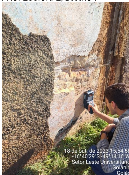
Figura 69 – Escaneamento da parede para identificação do cobrimento parede RA04 utilizando o scanner de parede “D-TECT 200 C PROFESSIONAL, Bosch®”.
