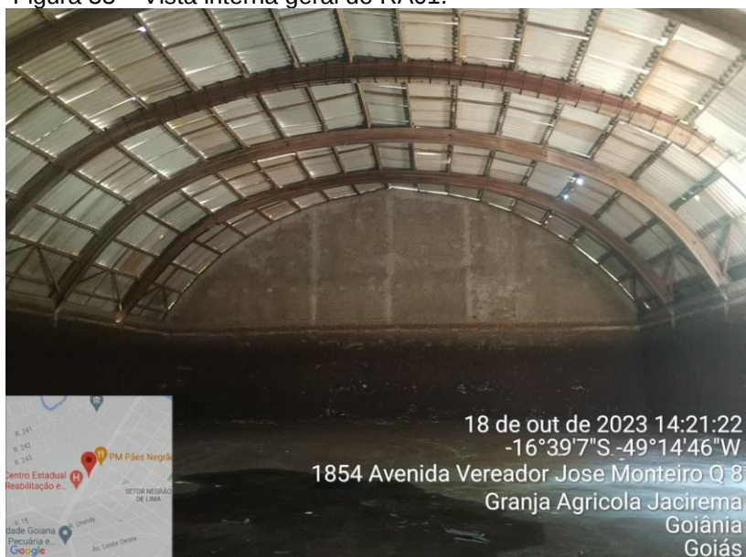
Figura 33 – Vista interna geral do RA01.
