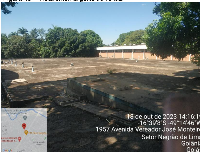
Figura 48 – Vista externa geral do RA02.
