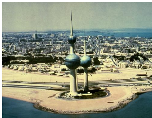
Figura 12 – A esquerda reservatórios de concreto em formato de cogumelo e à direita as Torres de Água do Kuwait (Abraj Al-Kuwait em árabe), reservatório de concreto que se tornaram símbolos nacionais.
