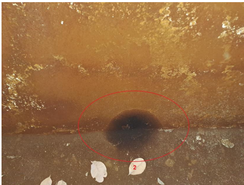
Figura 41 – Marca de umidade na parede RA01.
