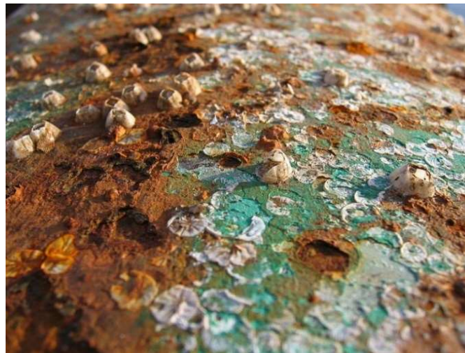
Figura 10 - Corrosão alveolar em superfície metálica
