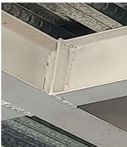
Figura 35 - Vigas da cobertura - W150x13
