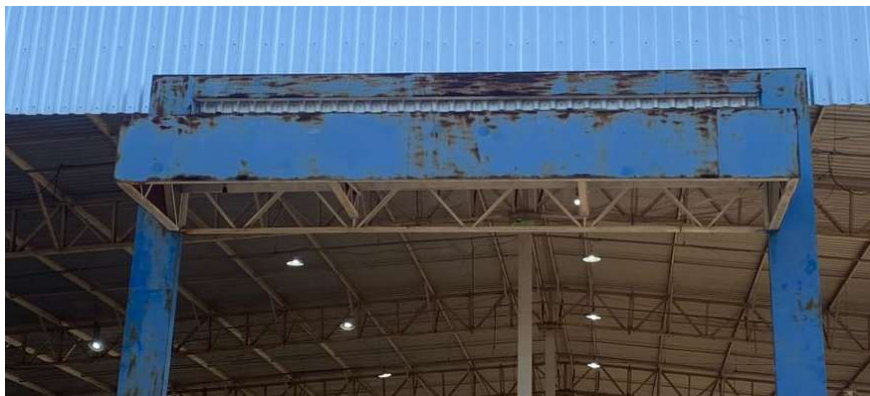
Figura 46 - Entrada do Galpão
