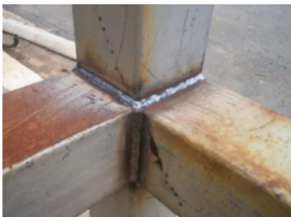
Figura 4 - Ligação soldada
