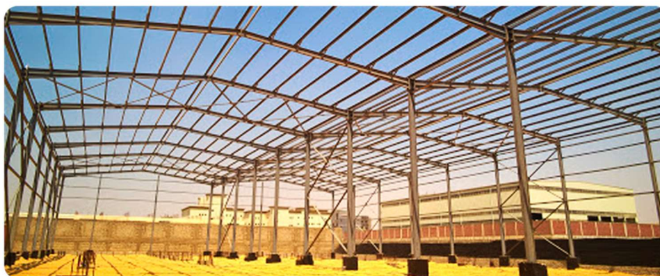
Figura 1 - Construção - Estrutura metálica
