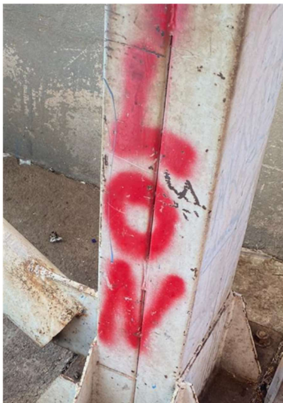
Figura 52 – Porosidade na pintura da peça metálica
