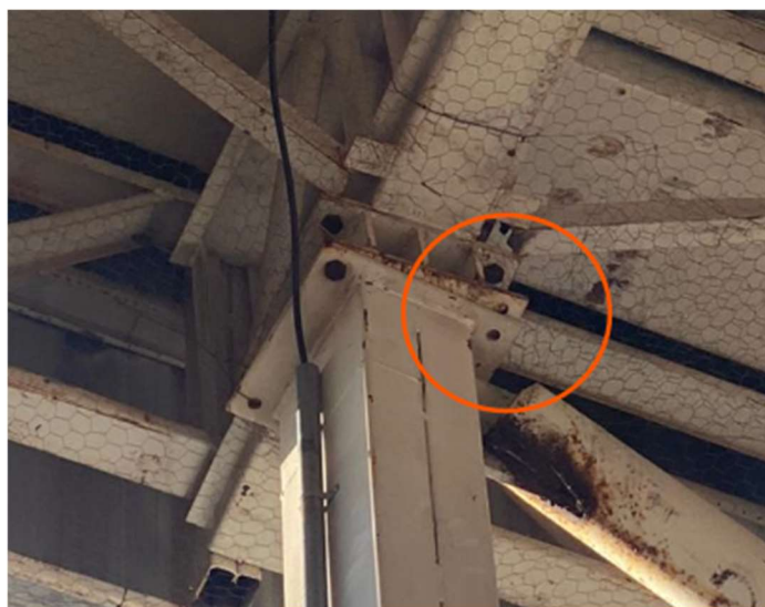
Figura 50 – Ligação parafusada 1
