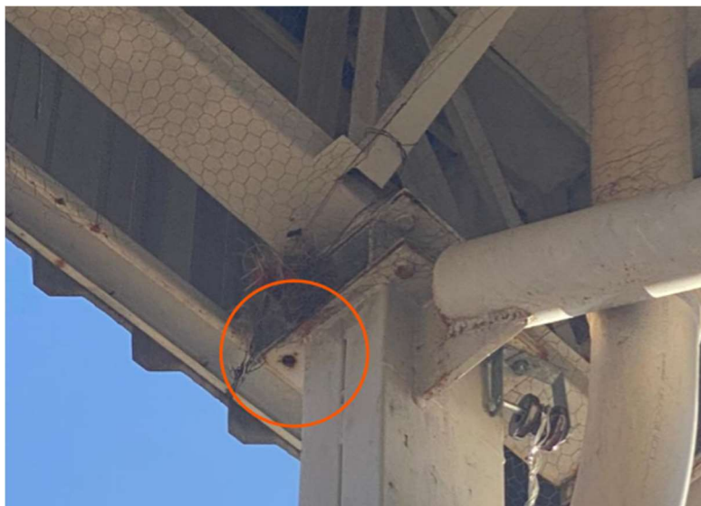
Figura 51 – Ligação parafusada 2
