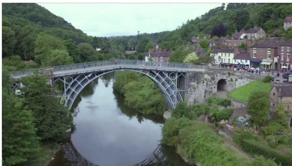
Figura 2 - Ponte de Coalbrookdale
