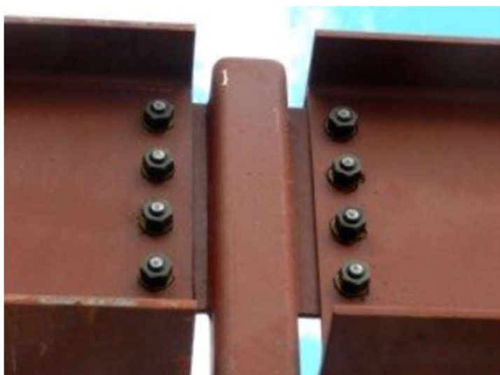
Figura 5 - Ligação parafusada
