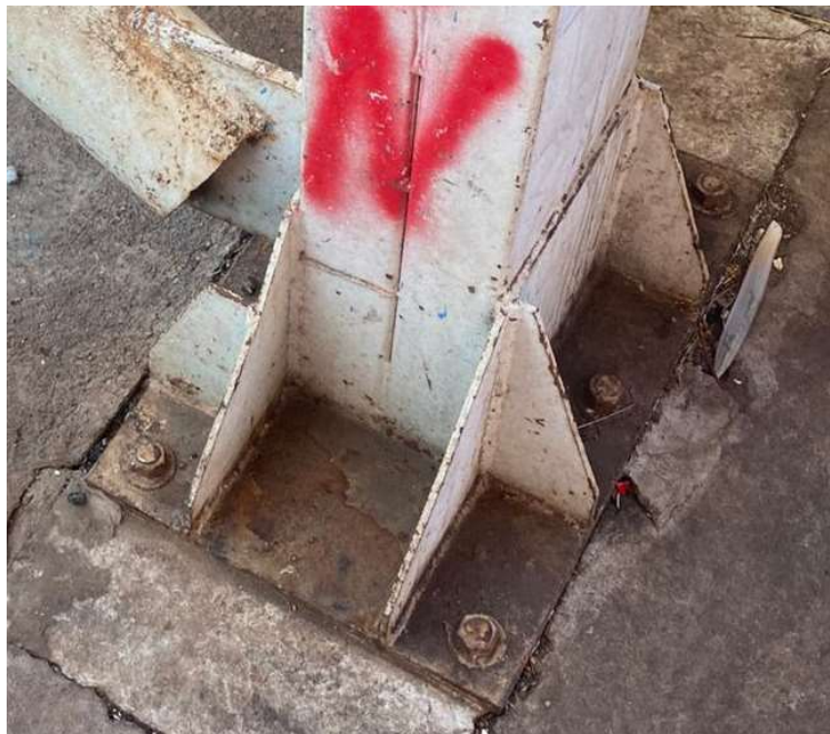
Figura 48 - Base do pilar metálico
