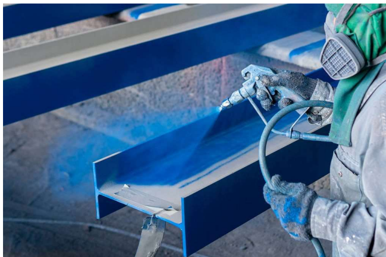
Figura 18 - Pintura de um perfil metálico
