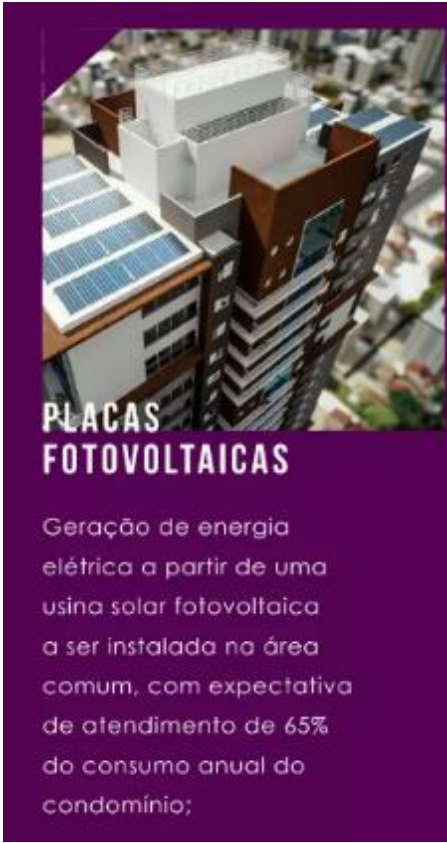
Figura 306. 2 – Fontes de energia edifício A Fonte: Book do edifício, 2024
