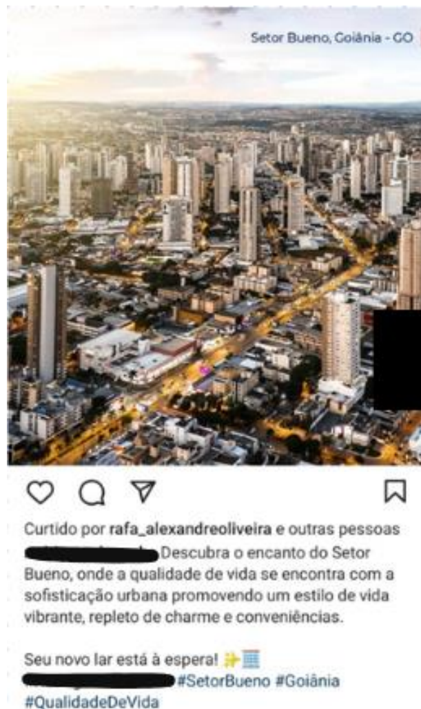
Figura 112. 42 – Localidade do Edifício A Fonte: Instagram da Construtora, 2024
