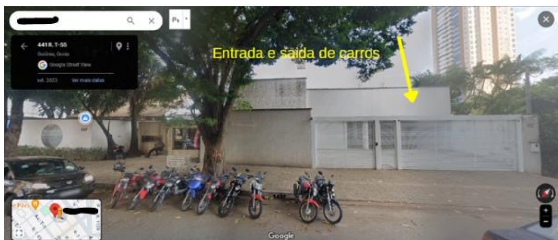
Figura 22. Abertura 3 na quadra do edifício A Fonte: Google Maps, 2023
