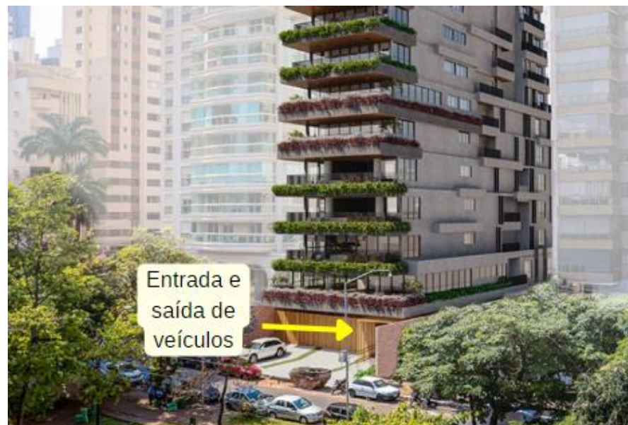
Figura 34. Avaliação 2 da entrada do edifício C Fonte: Site da construtora, 2024
