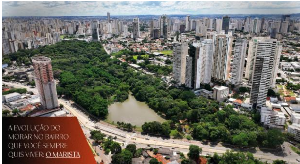
Figura 250. Localidade do Edifício B Fonte: Book do edifício, 2024
