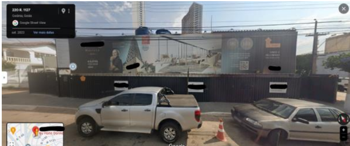
Figura 11. Vista lateral do edifício B Fonte: Google Maps, 2023
