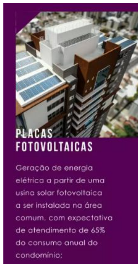
Figura 296. 2 – Fontes de energia edifício A Fonte: Book do edifício, 2024
