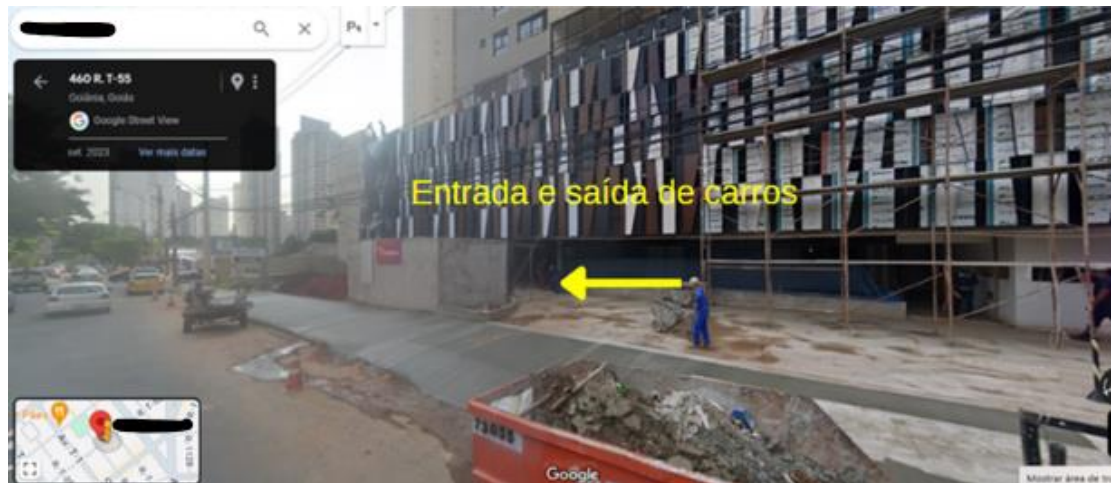
Figura 19. Abertura 2 na quadra do edifício A Fonte: Google Maps, 2023
