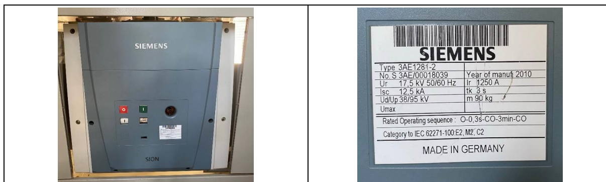
Figura 72 – Disjuntor do estudo de prova 01 e sua placa de informação.
