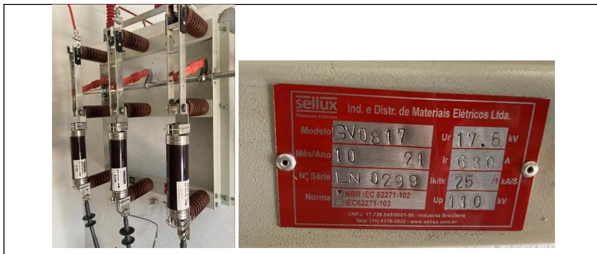
Figura 12 – Chave seccionadora com fusível.
