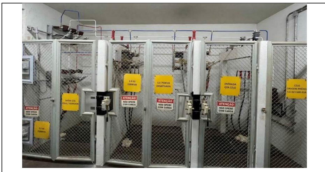
Figura 30 – Sinalização de segurança.
