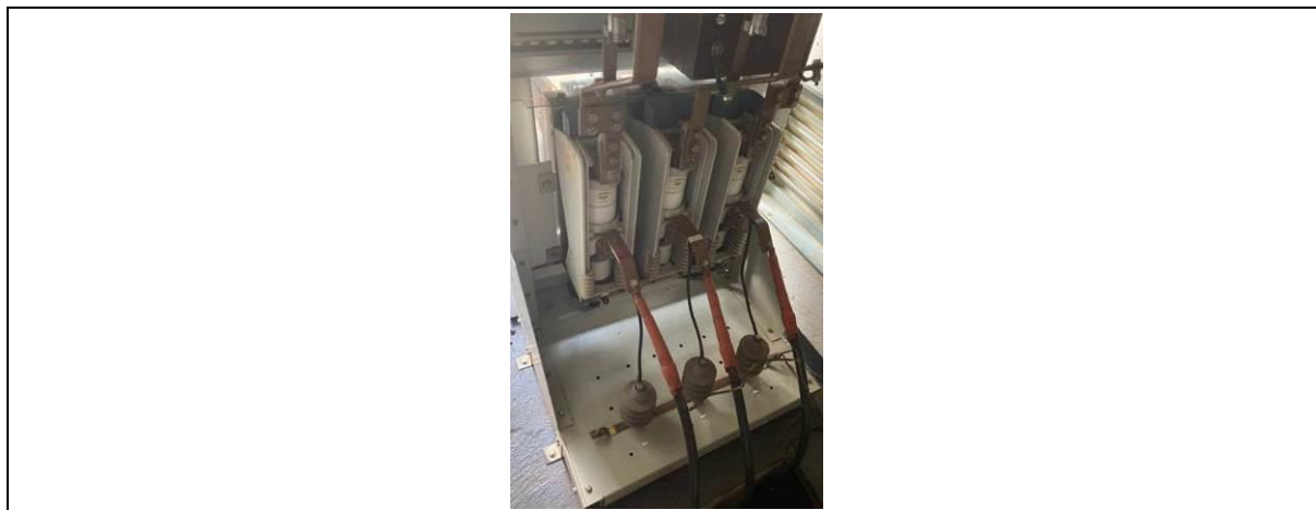
Figura 89 – Mufla de isolamento do estudo de prova 02.
