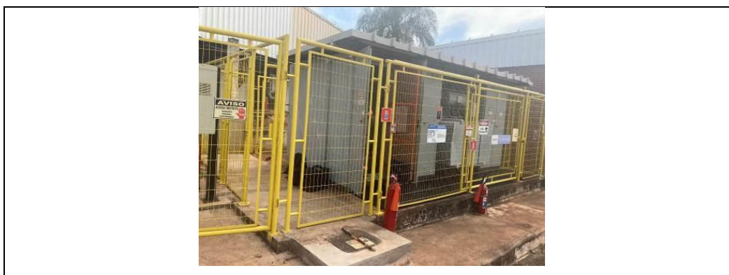
Figura 28 – Grade de proteção em subestações.
