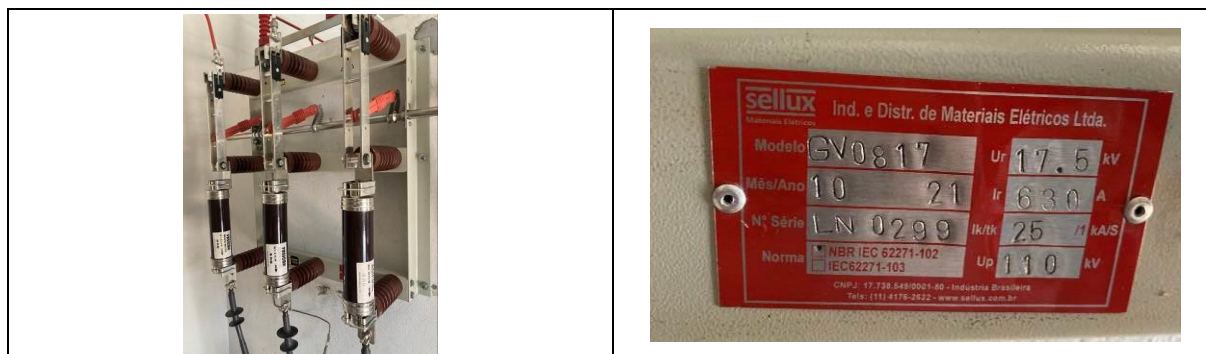
Figura 86 – Chave seccionadora do estudo de prova 04 e sua placa de informação.
