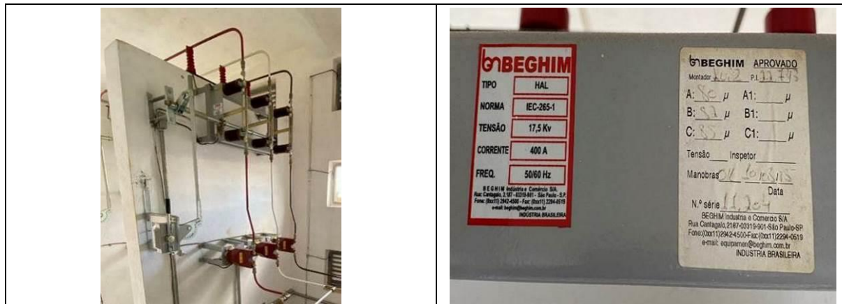
Figura 80 – Chave seccionadora do estudo de prova 01 e sua placa de informação.
