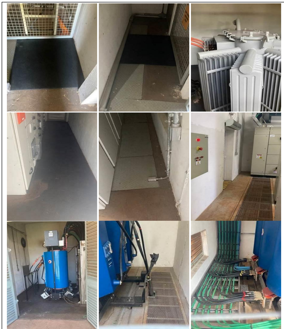
Figura 50 - Subestação e componentes elétricos depois de realizar a limpeza.
