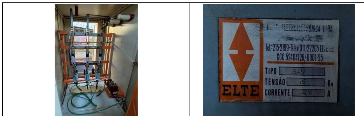
Figura 82 – Chave seccionadora do estudo de prova 02 e sua placa de informação.
