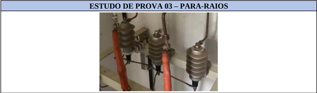
Figura 94 – Para-raios do estudo de prova 01.
