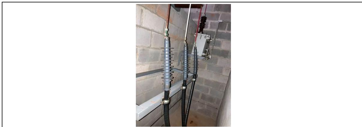
Figura 90 – Mufla de isolamento do estudo de prova 03.
