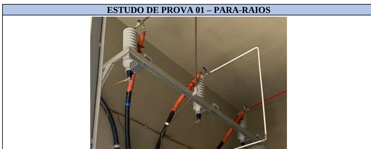
Figura 92 – Para-raios do estudo de prova 01.
