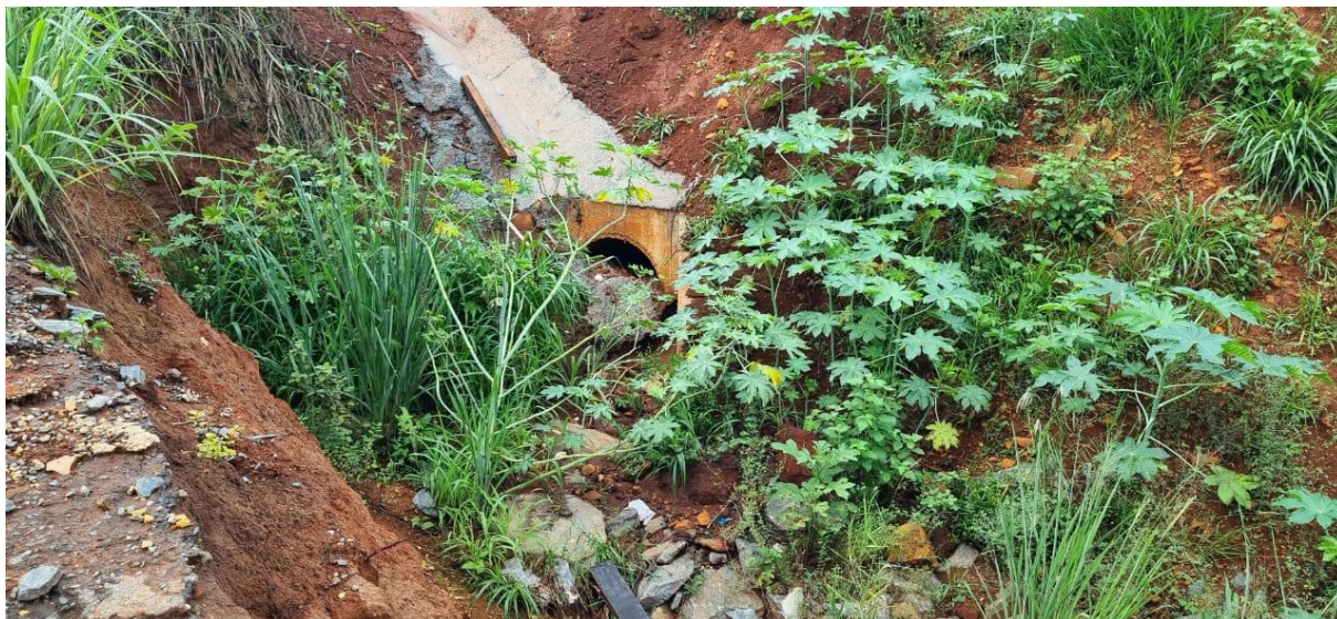
Figura 58: Situação da boca do BSTC após executado
