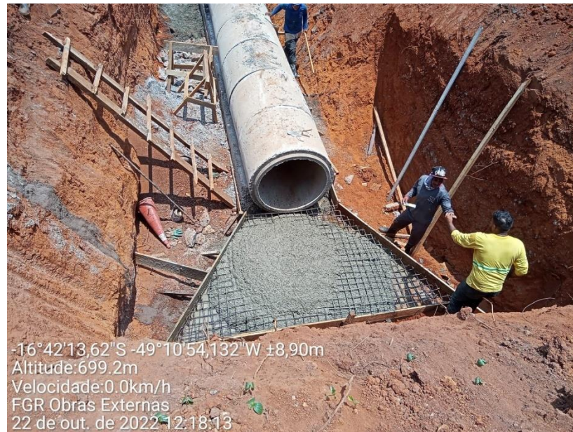
Figura 54: Execução de boca de BSTC
