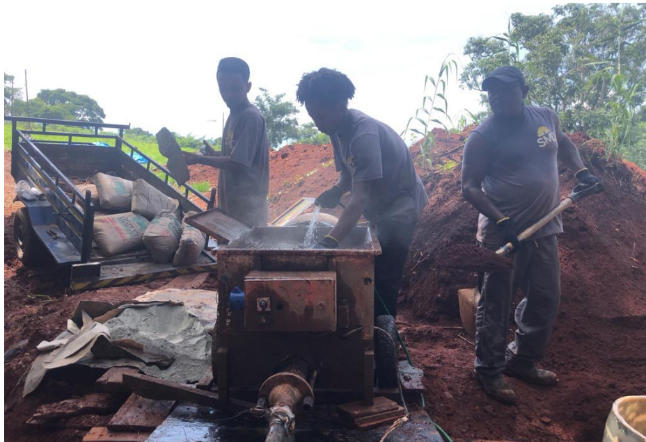
Figura 32: Injeção de solo-cimento com bomba injetora
