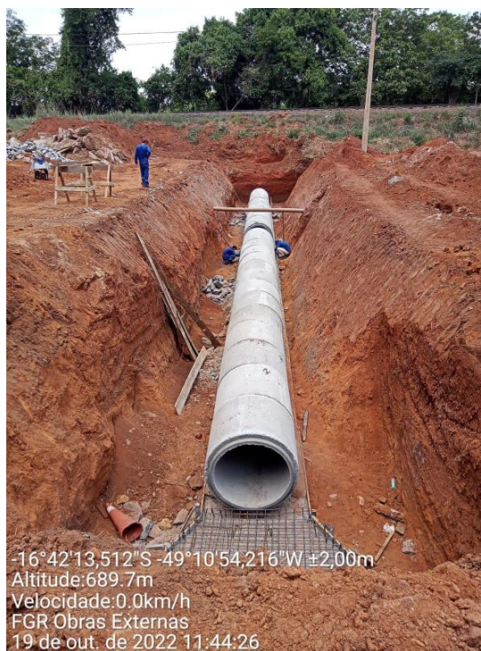
Figura 53: Montagem de tubos do BSTC
