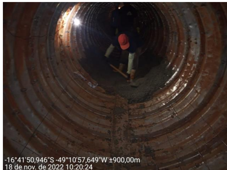
Figura 39: Execução de revestimento parcial do corpo do bueiro
