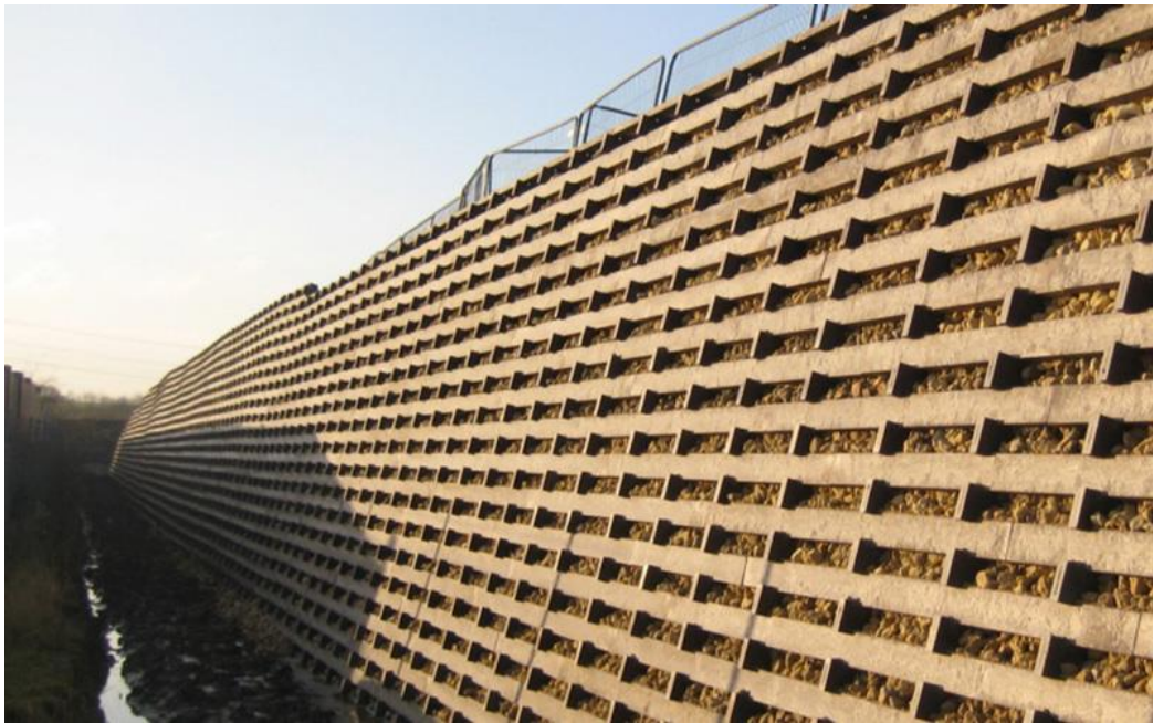
Figura 14: Muro de contenção
