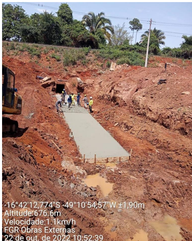
Figura 45: Execução de berço de concreto de BSCC
