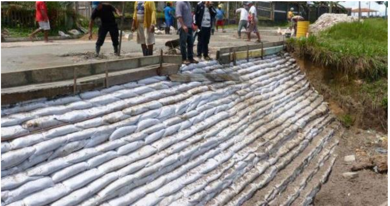
Figura 15: Muro Rip Rap
