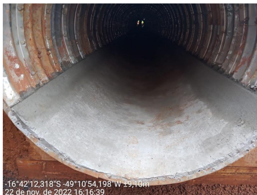
Figura 40: Revestimento do corpo do bueiro acabado
