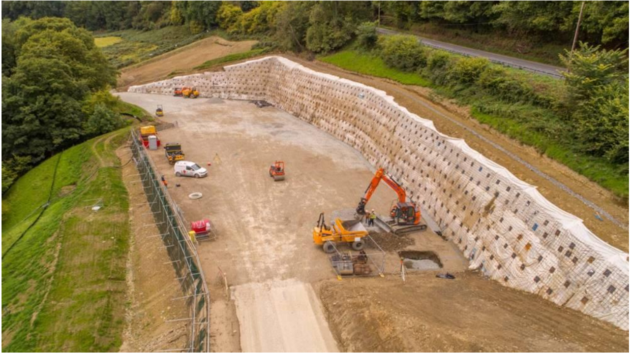
Figura 17: Técnica de Solo Grampeado para contenção
