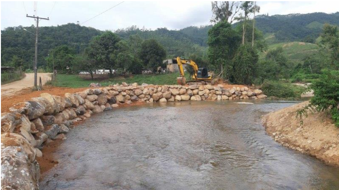
Figura 12: Enrocamento de pedra
