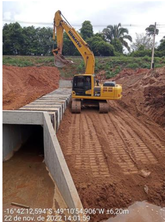
Figura 49: Compactação de aterro
