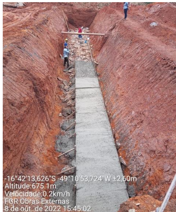
Figura 52: Execução de berço de concreto
