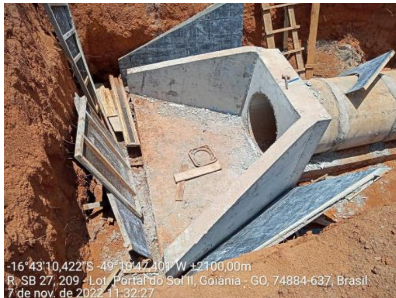
Figura 55: Boca de BSTC construída
