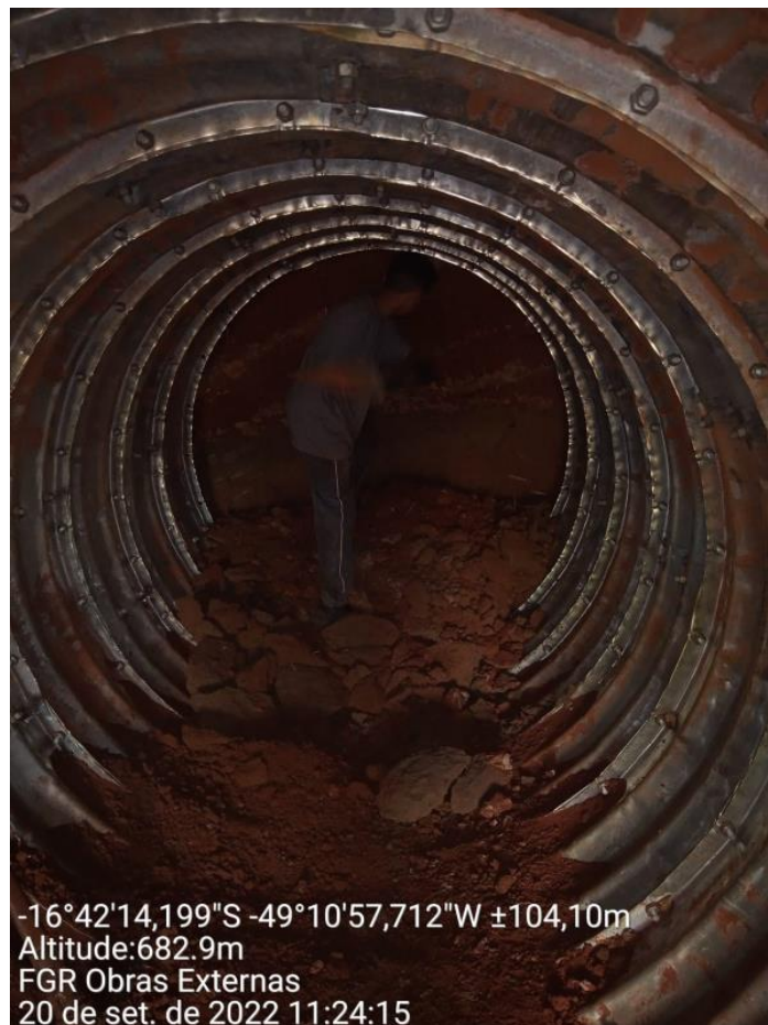
Figura 33: Escavação manual para montagem de anéis metálicos
