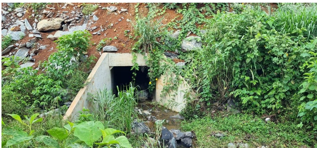
Figura 51: Situação de boca a montante de BSCC após executado
