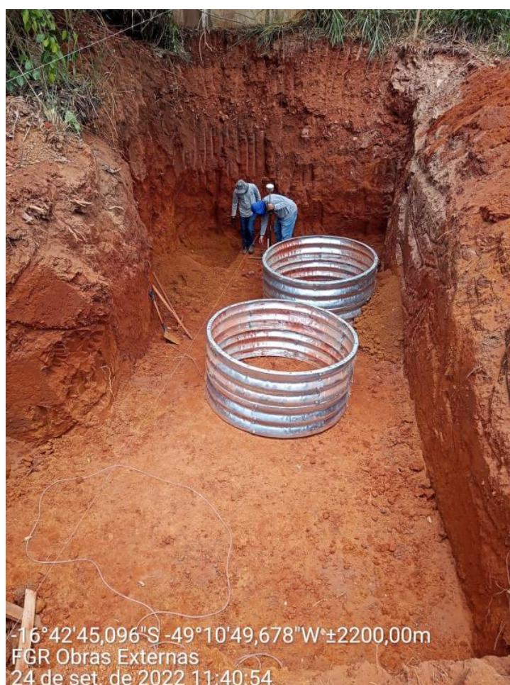
Figura 34: Controle topográfico de execução
