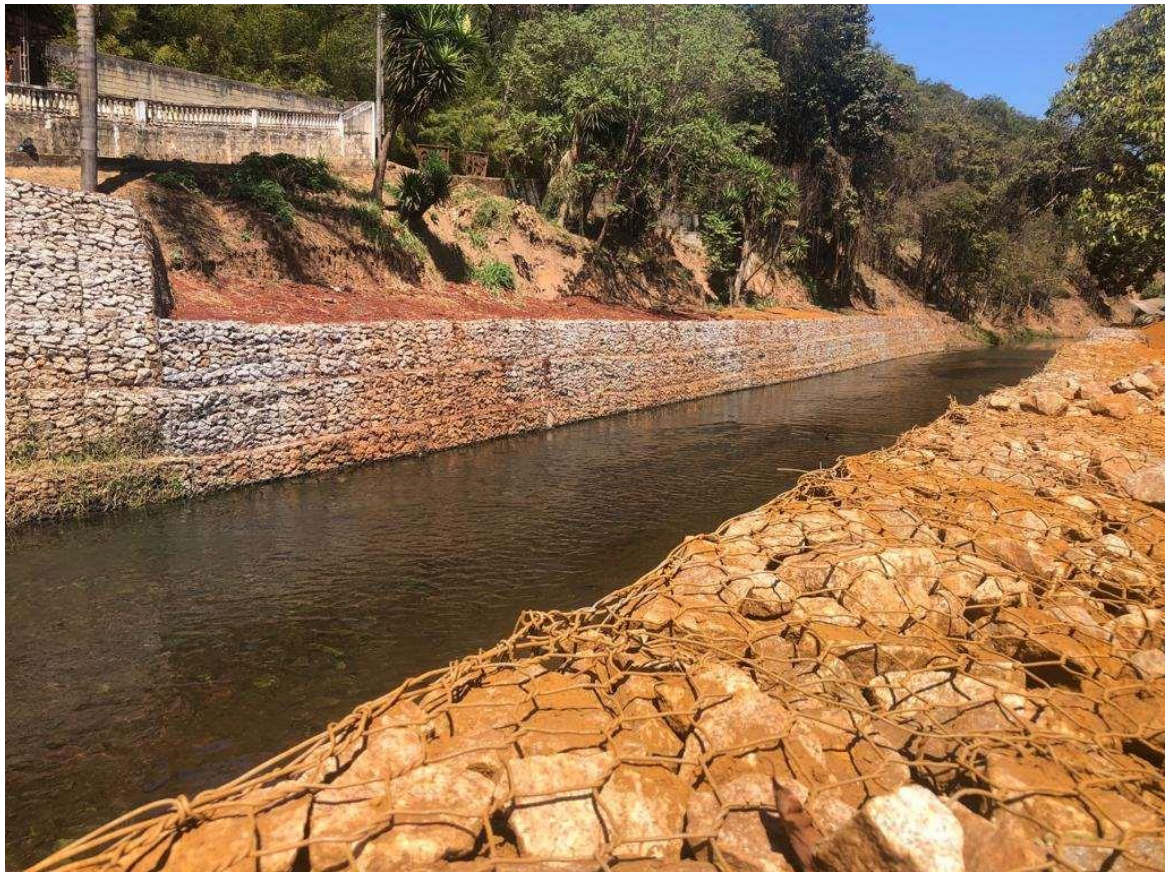
Figura 11: Muro de gabião
