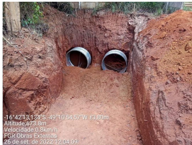
Figura 36: Início da escavação mecanizada
