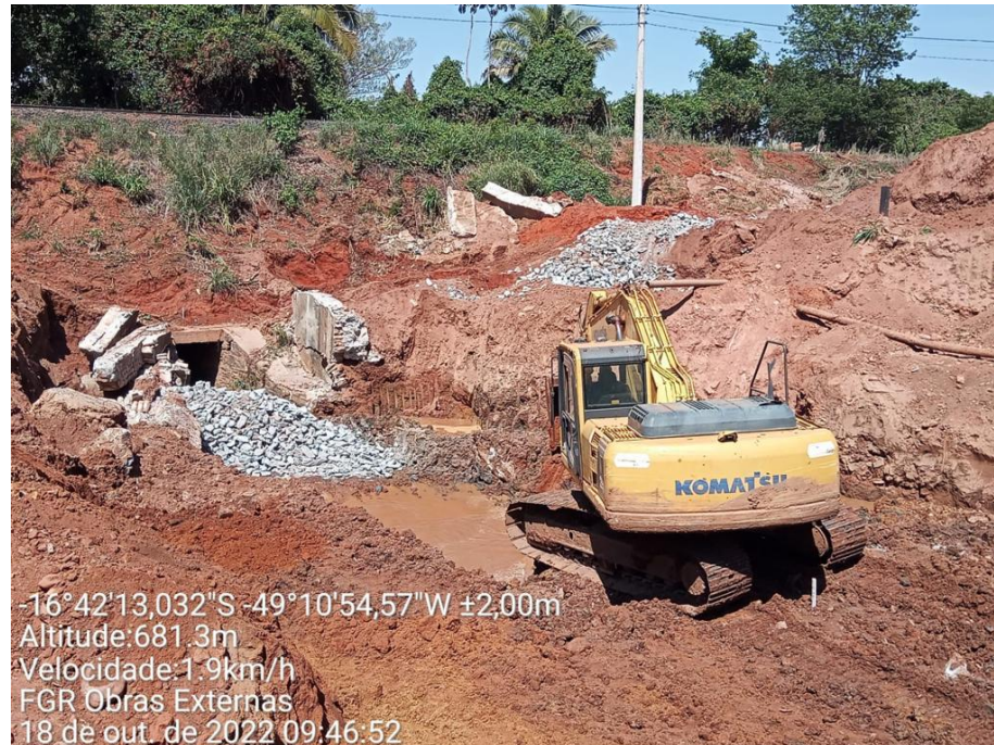
Figura 43: Escavação mecanizada de bueiro
