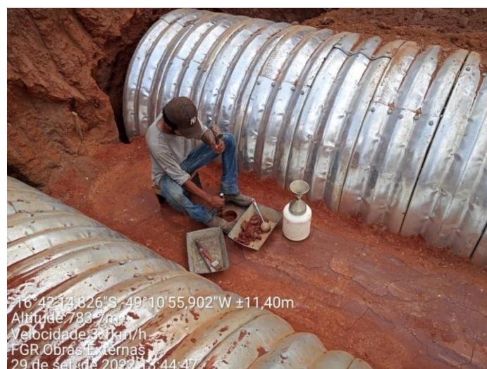
Figura 38: Controle tecnológico de aterro
