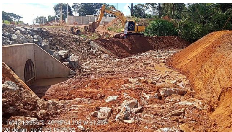
Figura 50: Enrocamento de pedras e canalização de acesso ao bueiro
