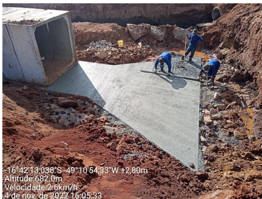
Figura 47 : Execução de lastro de concreto da boca do bueiro
