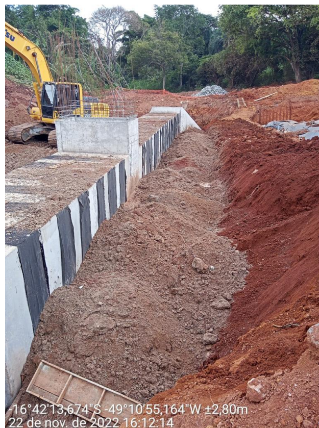
Figura 48: Reaterro de BSCC com substituição de material escavado
