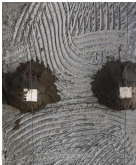
Figura 15– Execução de taliscamento
