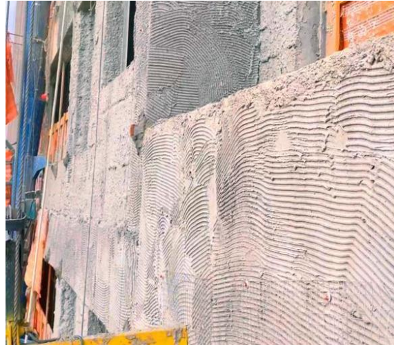
Figura 13- Chapisco desempenado na estrutura
