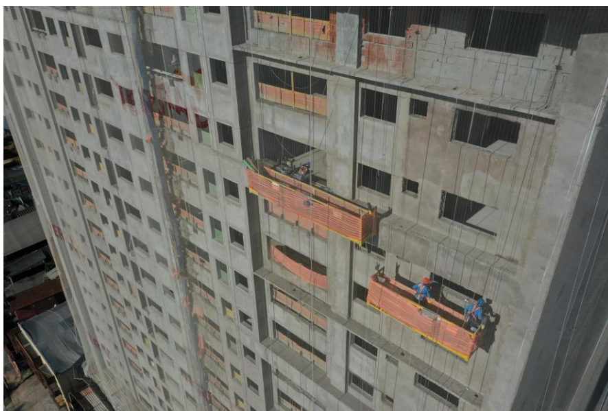
Figura 16– Elementos de fachada requadrados
