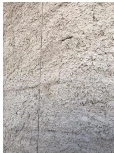
Figura 14– Chapisco chapado na alvenaria
