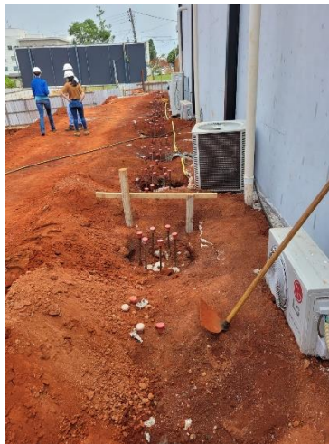
Figura 36 – Execução da estaca trado
