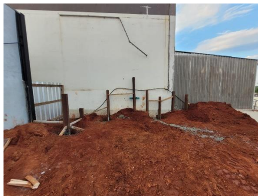
Figura 37 – Execução do trilho metálico
