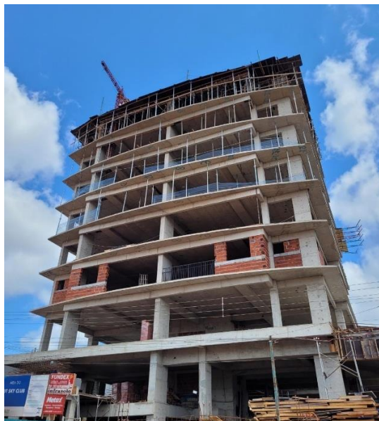
Figura 19 - Fase atual de execução do empreendimento (Fachada Lateral)
