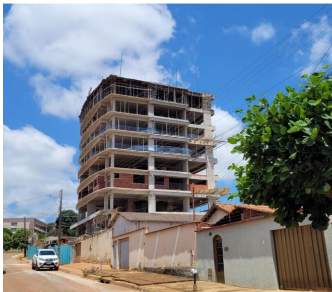
Figura 20 - Fase atual de execução do empreendimento (Fachada posterior)
