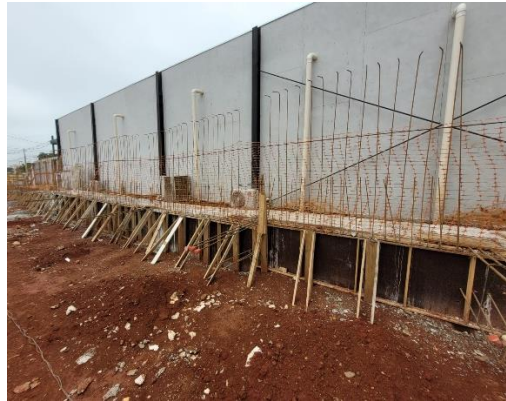
Figura 38 – Execução da viga de coroamento
