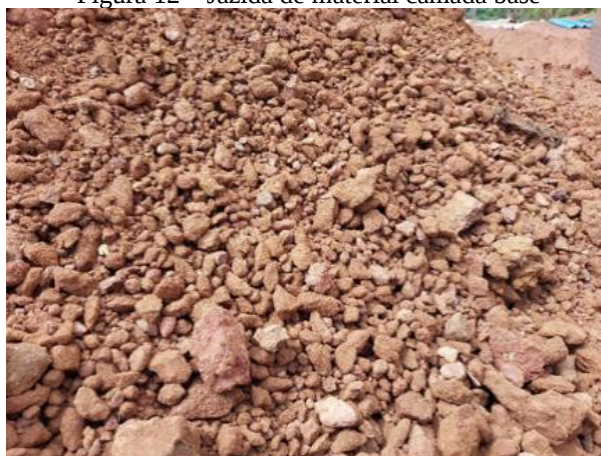
Figura 12 – Jazida de material camada base
