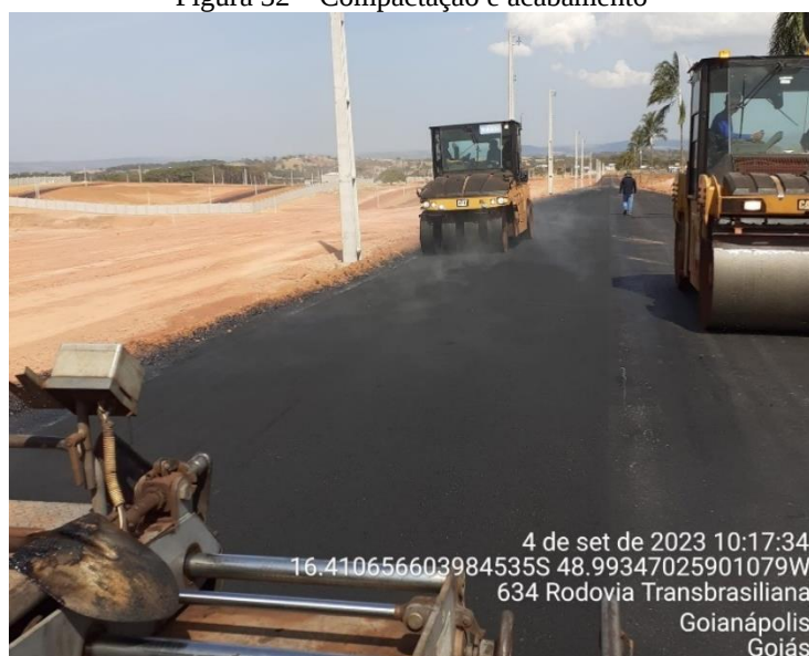
Figura 32 – Compactação e acabamento
