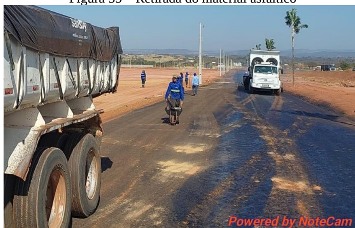
Figura 35 – Retirada do material asfáltico
