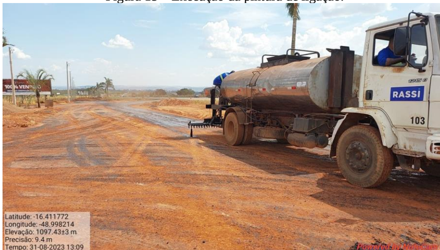
Figura 15 – Execução da pintura de ligação.
