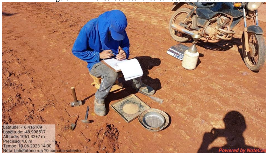
Figura 27 – Análise laboratorial da camada compactada
