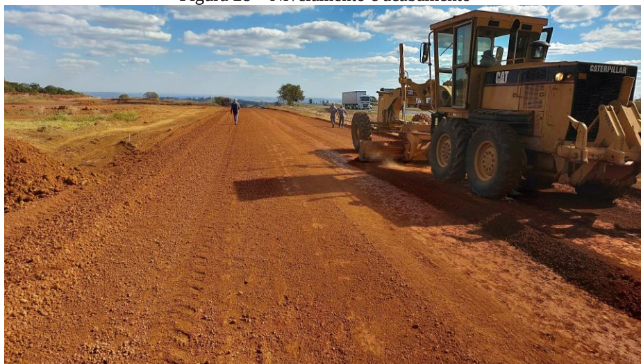
Figura 28 – Nivelamento e acabamento
