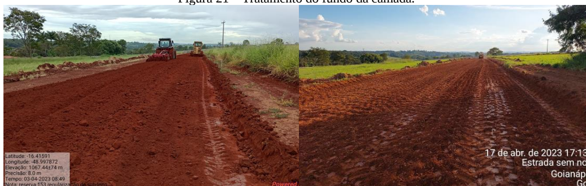
Figura 21 – Tratamento do fundo da camada.
