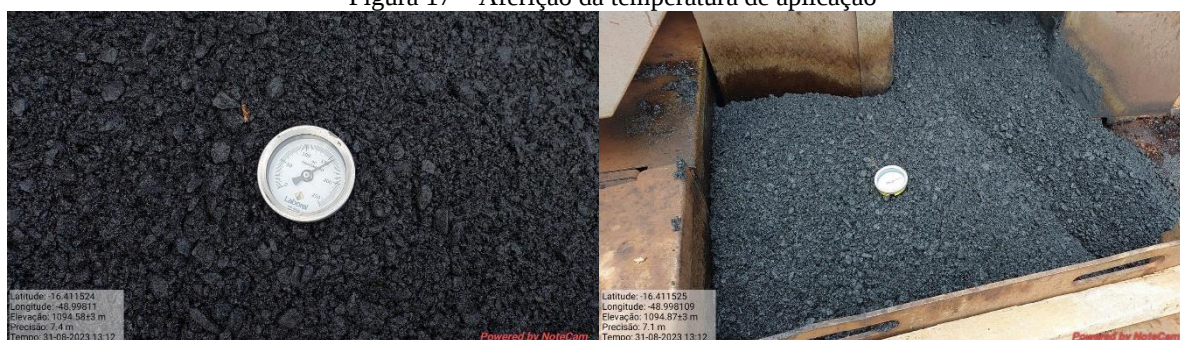
Figura 17 – Aferição da temperatura de aplicação
