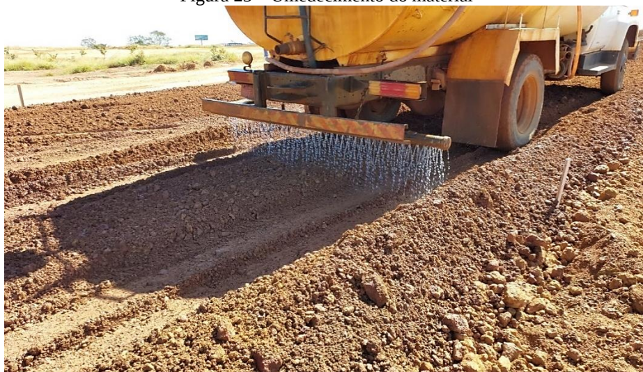
Figura 23 – Umedecimento do material
