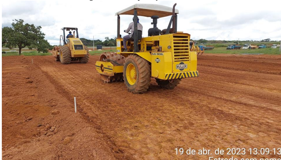
Figura 26 – Compactação da camada
