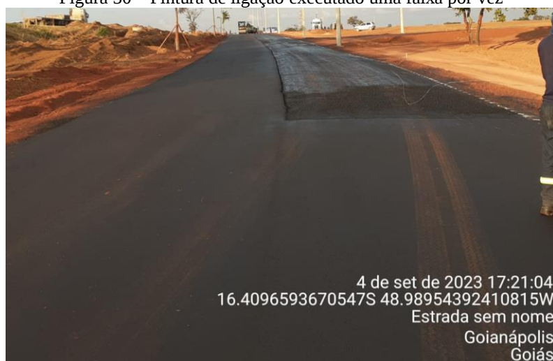
Figura 30 – Pintura de ligação executado uma faixa por vez
