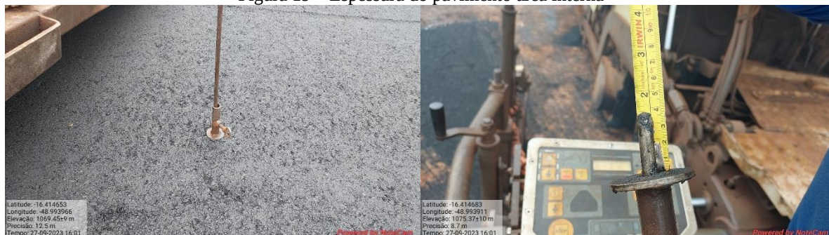
Figura 19 – Espessura do pavimento área interna
