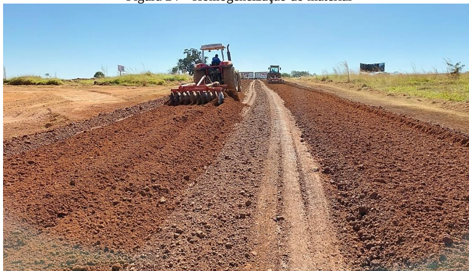
Figura 24 – Homogeneização do material
