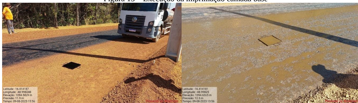
Figura 13 – Execução da imprimação camada base
