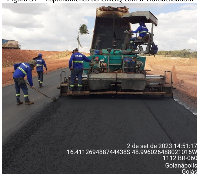
Figura 31 – Espalhamento do CBUQ com a vibroacabadora
