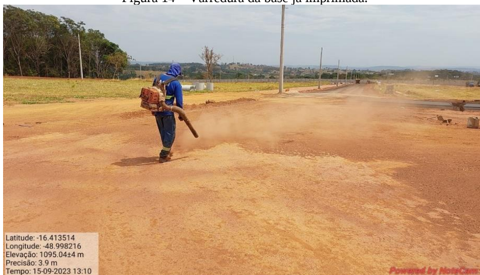
Figura 14 – Varredura da base já imprimada.
