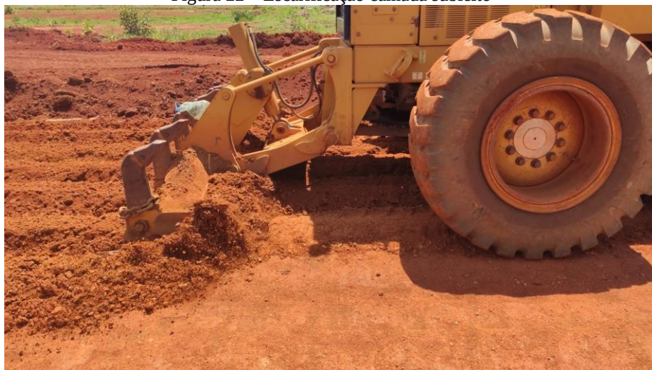
Figura 22 – Escarificação camada subleito
