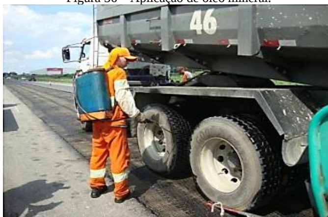
Figura 36 – Aplicação de óleo mineral.
