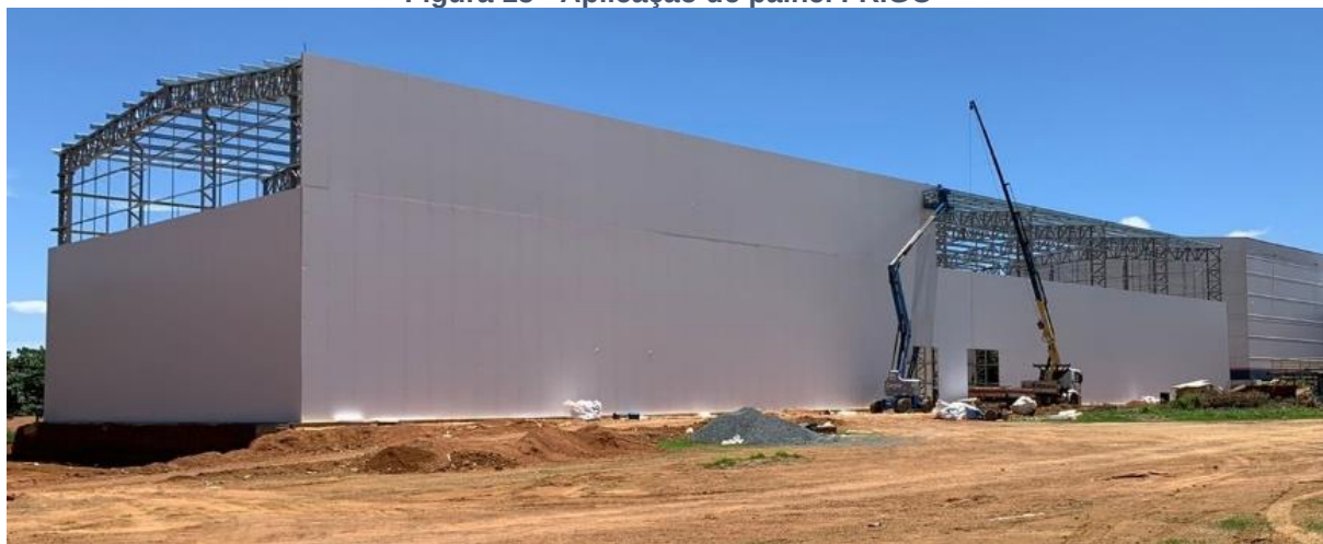
Figura 15 - Aplicação de painel FRIGO
