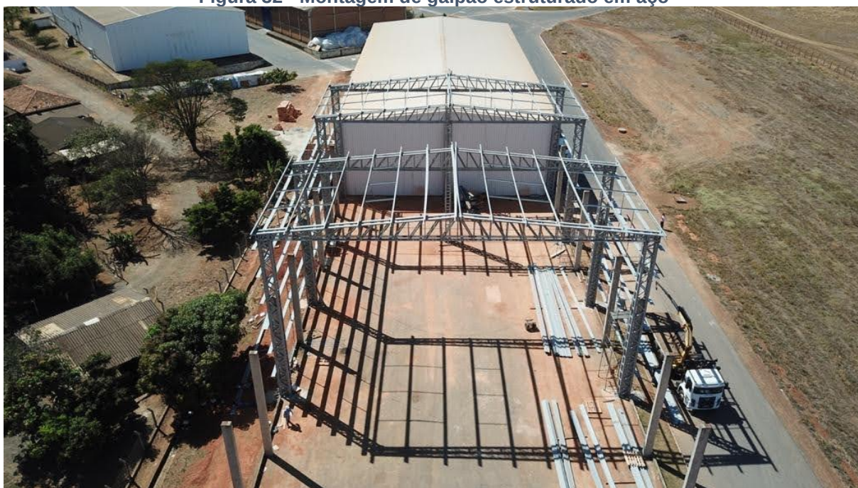
Figura 32 - Montagem de galpão estruturado em aço
