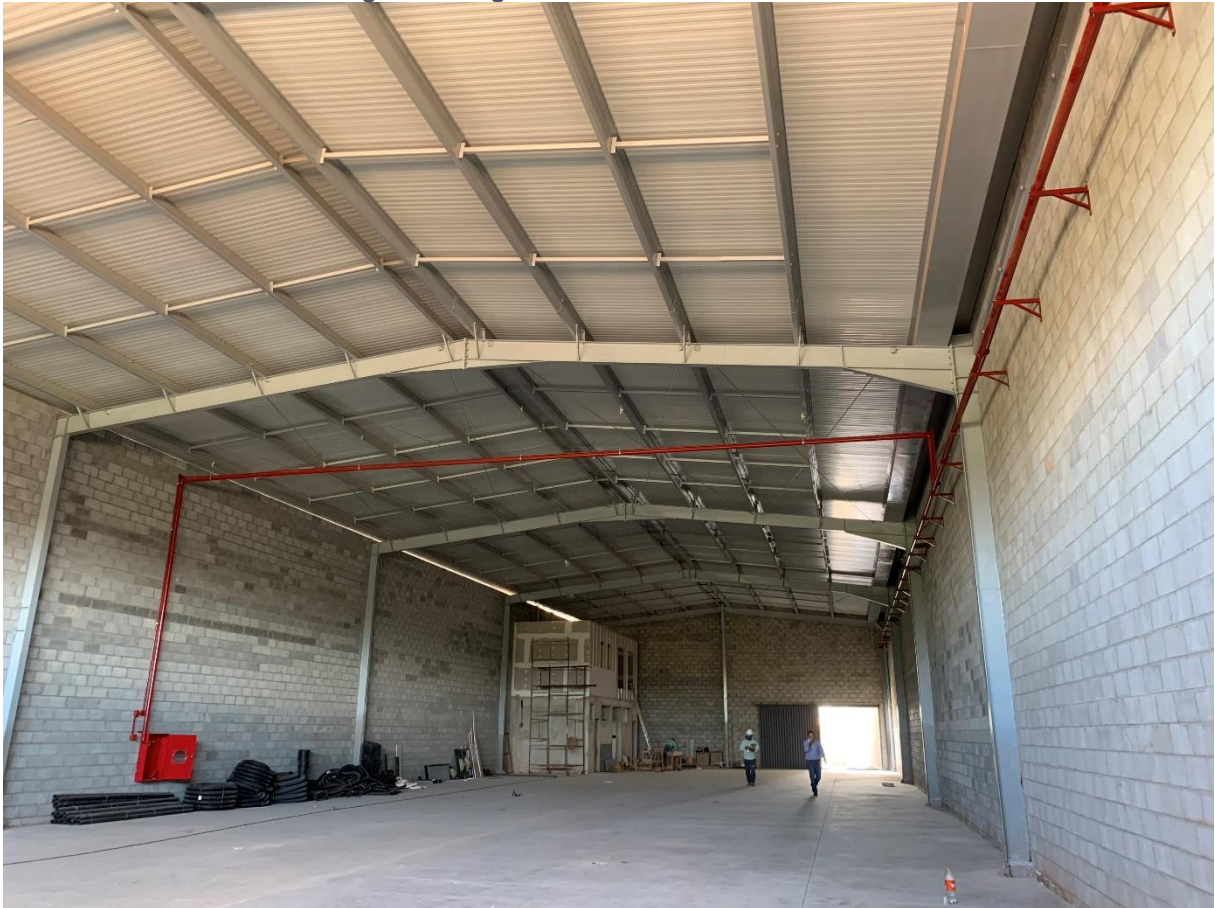
Figura 3 - Viga de cobertura em alma cheia
