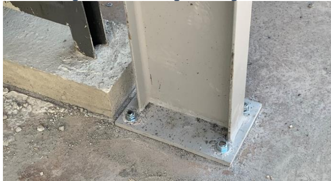
Figura 21 - Base rígida ou egastada
