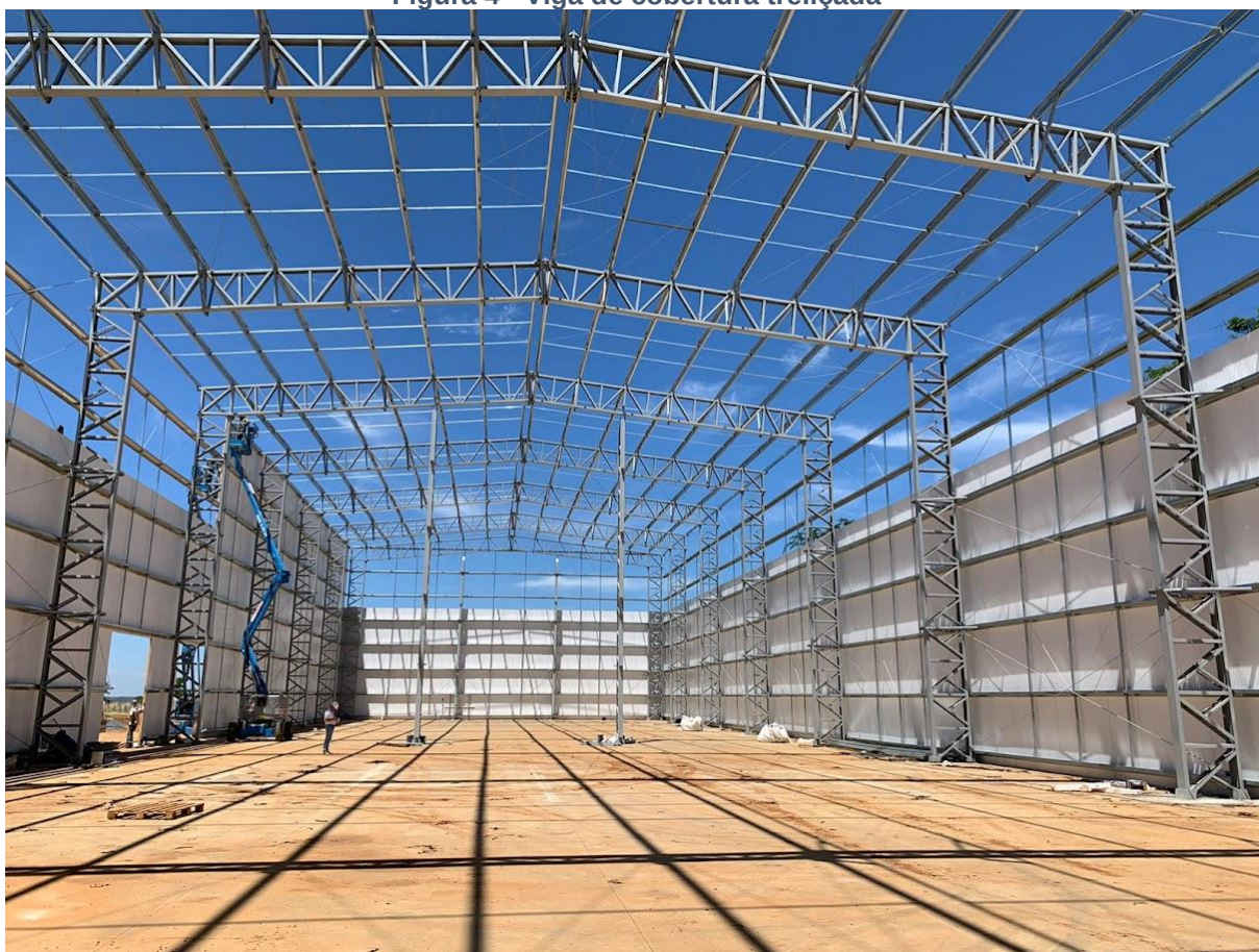
Figura 4 - Viga de cobertura treliçada
