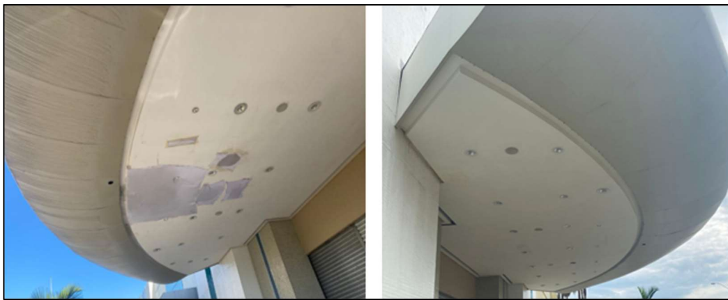
Figura 16 - Marquise da entrada principal antes (a esquerda) e depois (a direita) da reforma
