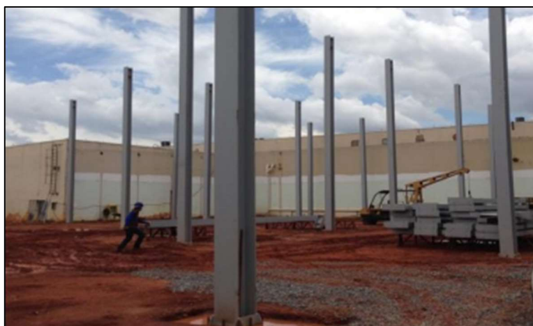
Figura 9 - Montagem dos pilares - obra do Shopping Cidade Jardim
