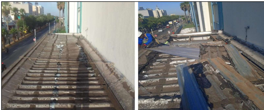
Figura 17 - Cobertura da marquise da 3 antes da reforma (a esquerda) e durante a reforma (a direita)
