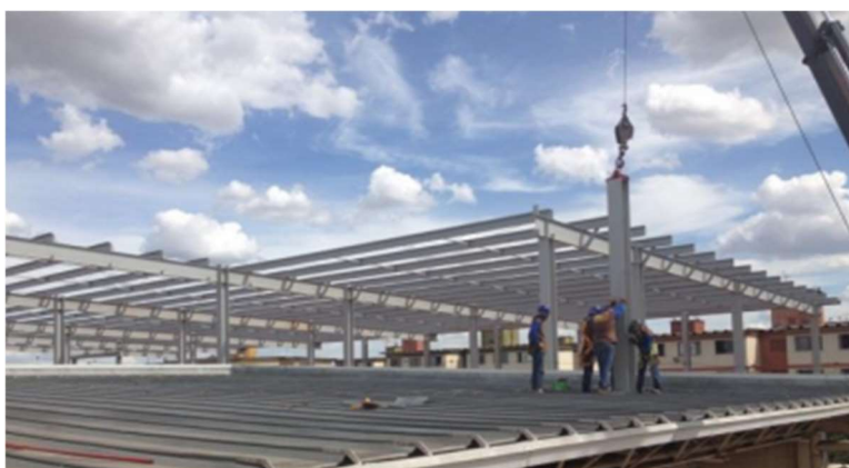
Figura 10 - Montagem dos elementos de cobertura - obra do Shopping Cidade Jardim
