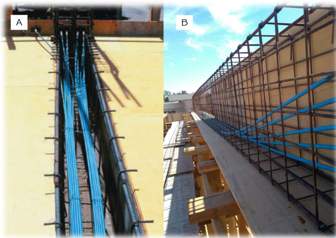
Figura A14 – Viga com estribos abertos para montagem dos cabos (A) e com estribos fechados após posicionamento de projeto dos cabos (B)
