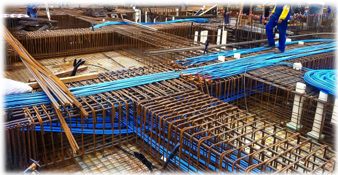
Figura A1 – Vigas em concreto protendido com monocordoalhas engraxadas
