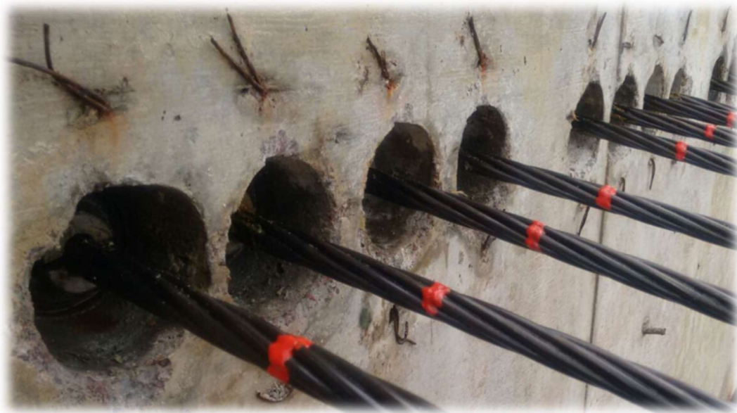
Figura A101 – Molde da forma de nicho para acoplamento do macaco hidráulico
