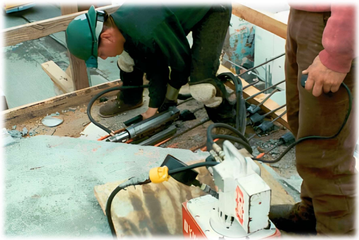
Figura A19 – Operação da protensão com um macaco hidráulico
