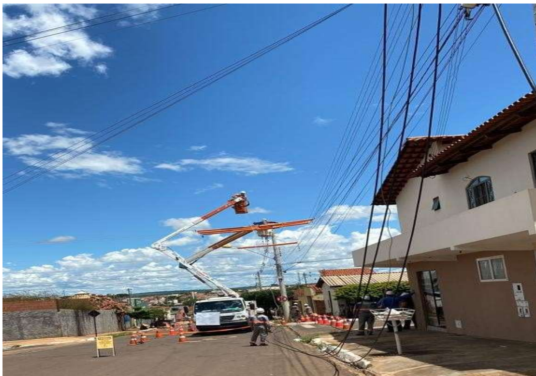
Figura 26: Posicionamento dos novos condutores na Linha Viva de Jataí-GO.
