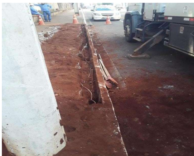
Figura 10: Aterramento do poste que receberia a rede de 13.8kV com 6 hastes e demais protocolos de segurança.
