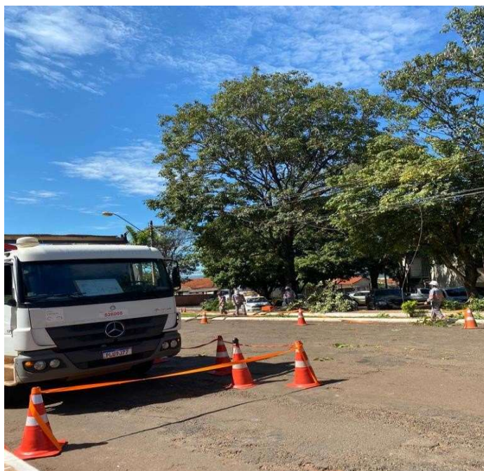
Figura 23: Sinalização para poda de árvores para manutenção da Linha Viva em Jataí-GO. Fonte: Arquivo Pessoal.
