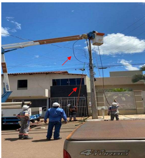
Figura 28: Cabo by-pass e Método a Distância em Linha Viva em Jataí-GO. Fonte: Arquivo Pessoal.
