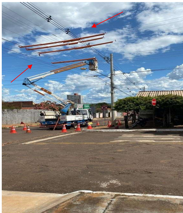
Figura 27: Instalação de isoladores para configuração dos novos condutores na Linha Viva em Jataí-GO. Fonte: Arquivo Pessoal.
