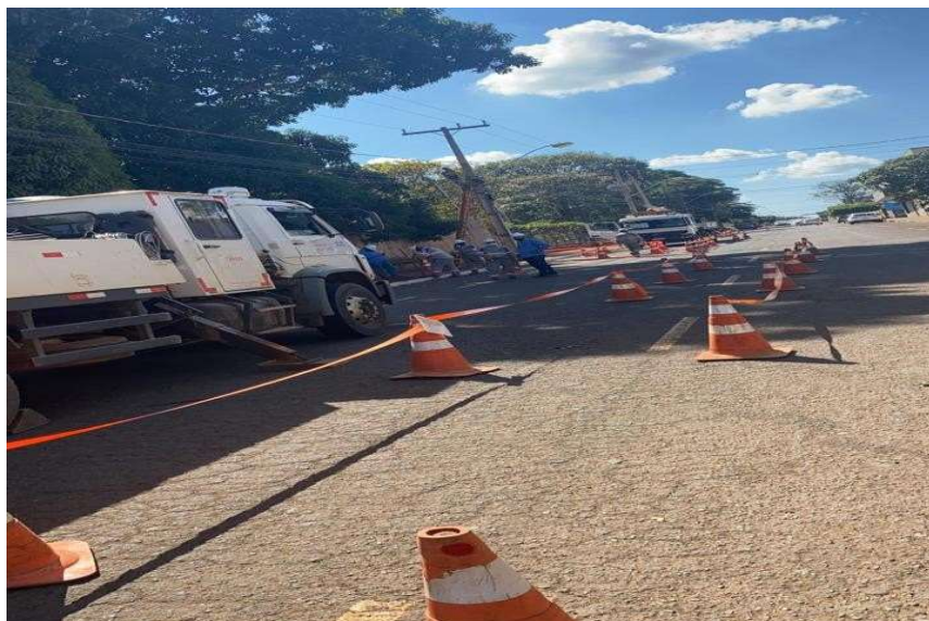
Figura 6: Protocolo de segurança para isolamento da área de trabalho. Fonte: Arquivo Pessoal.
