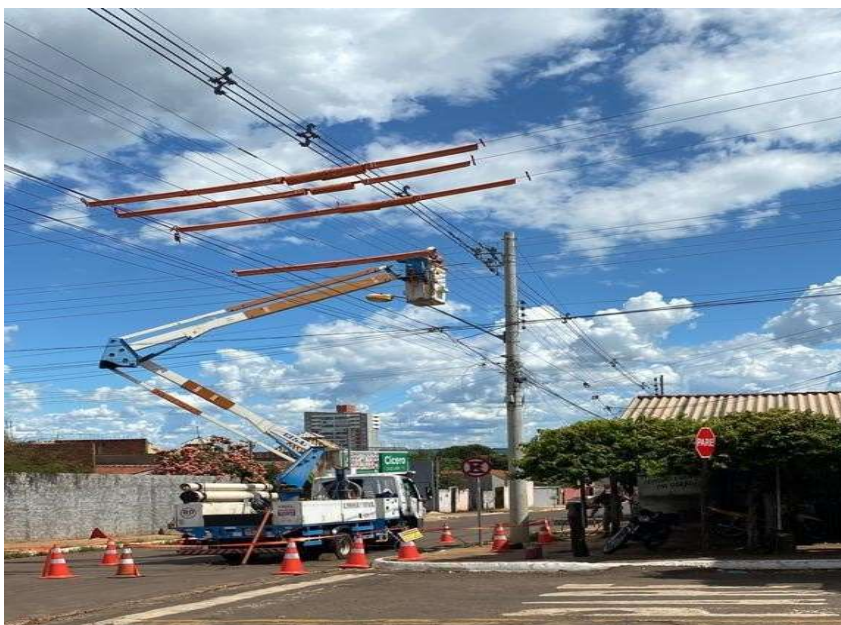
Figura 29: Instalação de novo trecho de Rede Aérea Compacta (13.8kV) em Linha Viva de Jataí-GO. Fonte: Arquivo Pessoal.
