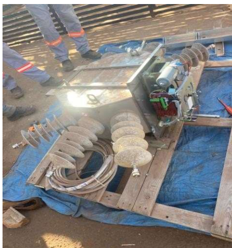
Figura 3: Chave telecomandada sendo preparada para instalação.
