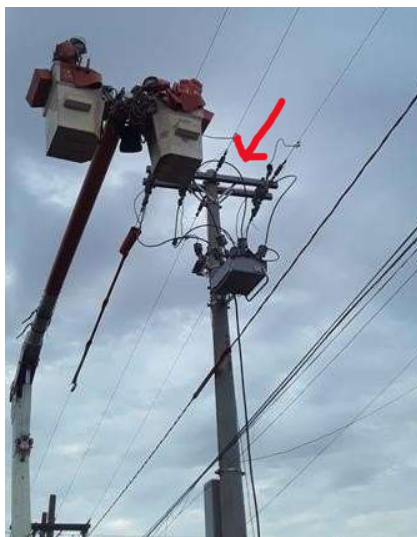
Figura 16: Cruzeta utilizada para compor a Configuração de rede N4 do poste instalado. Fonte: Arquivo Pessoal.
