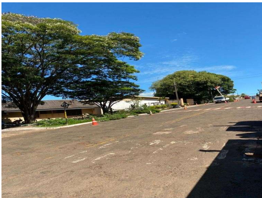
Figura 22: Poda de árvores, manutenção da Linha Viva. Fonte: Arquivo Pessoal.
