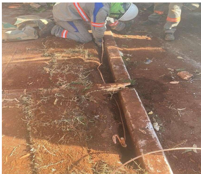
Figura 19: Poste instalado para receber chave telecomandada. Fonte: Arquivo Pessoal.
