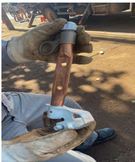
Figura 12: Lâmina utilizada como chave-faca, e uso de luva para Rede Primária 13.8 kV. Fonte: Arquivo Pessoal
