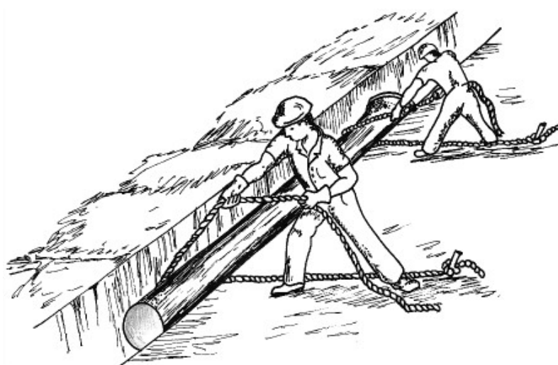
Figura 23 - Descida manual do tubo
