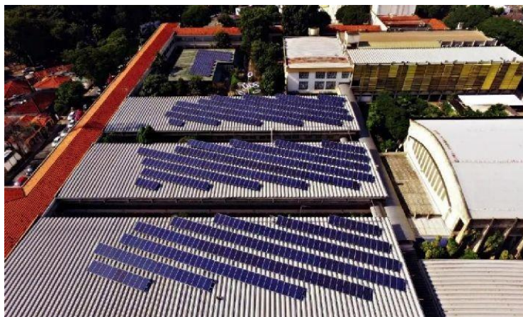
Figura 4.4 – Vista aérea da usina solar fotovoltaica do IFG Campus Goiânia.
