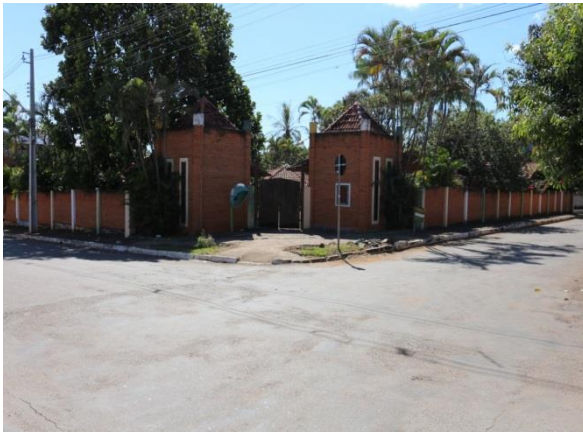
Figura 3: Brinquedoteca, vista externa a partir da contra-esquina.
