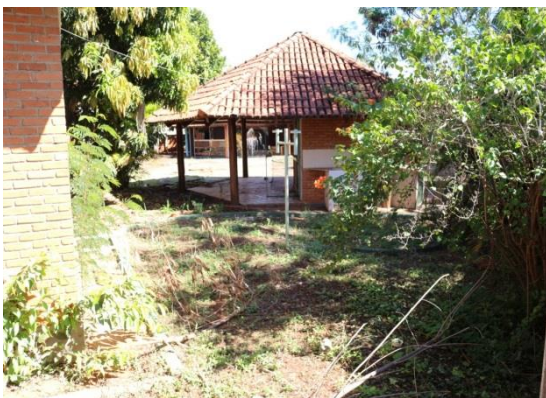
Figura 4: Brinquedoteca, vista interna, mato crescendo.
