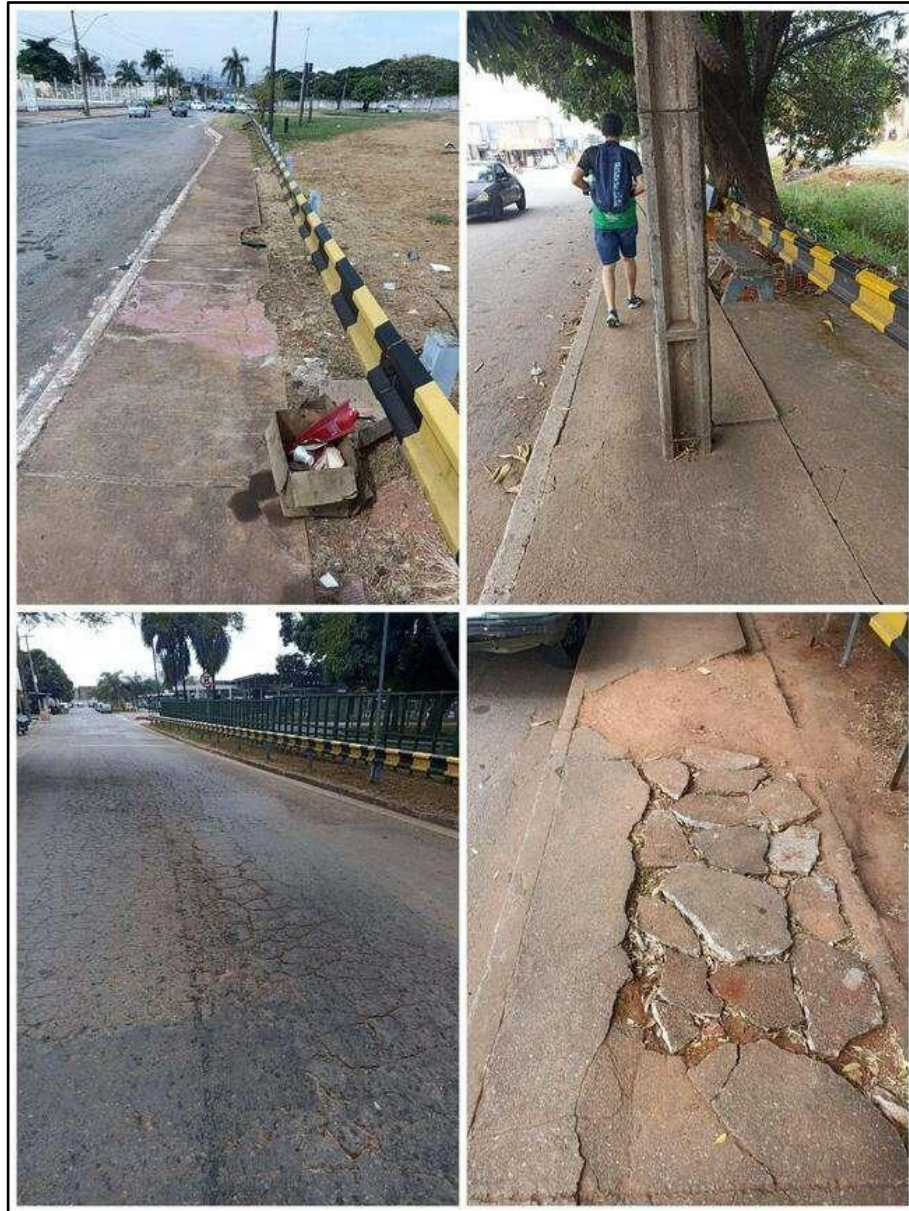
Figura 4.2 - Calçadas entorno do Terminal Padre Pelágio
