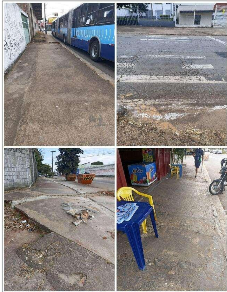
Figura 4.1 - Ambiente externo do Terminal Padre Pelágio
