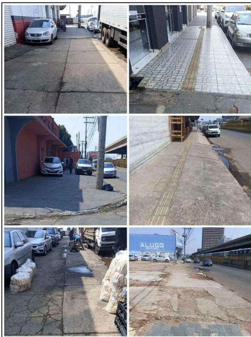
Figura 4.19 - Ambiente externo do Terminal Dergo
