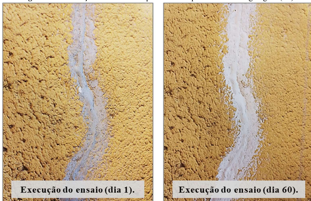
Figura 83 – Execução do ensaio complementar na parede lateral da garagem (P1).
