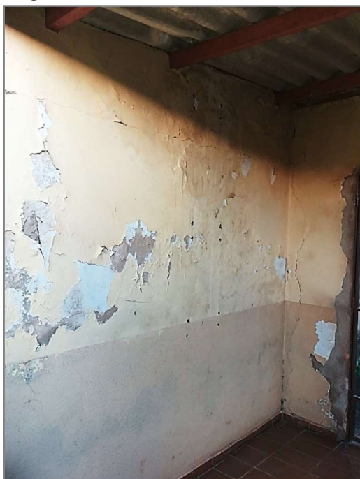
Figura 71 – Pulverulência na área de serviço.
