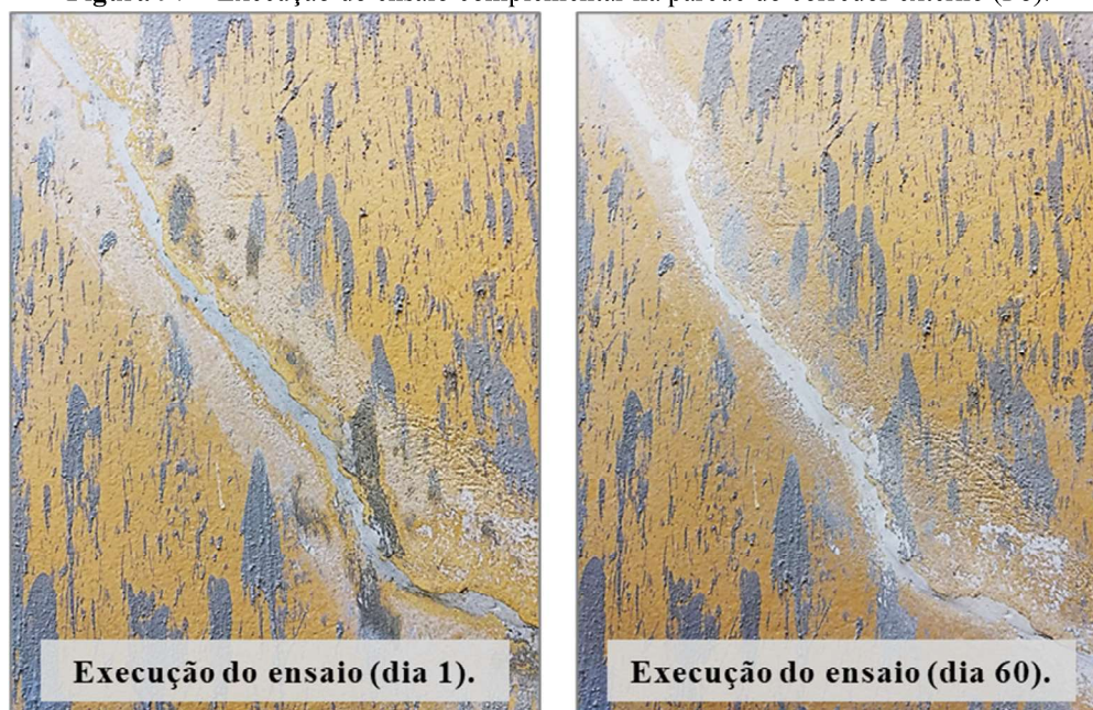
Figura 97 – Execução do ensaio complementar na parede do corredor externo (P8).
