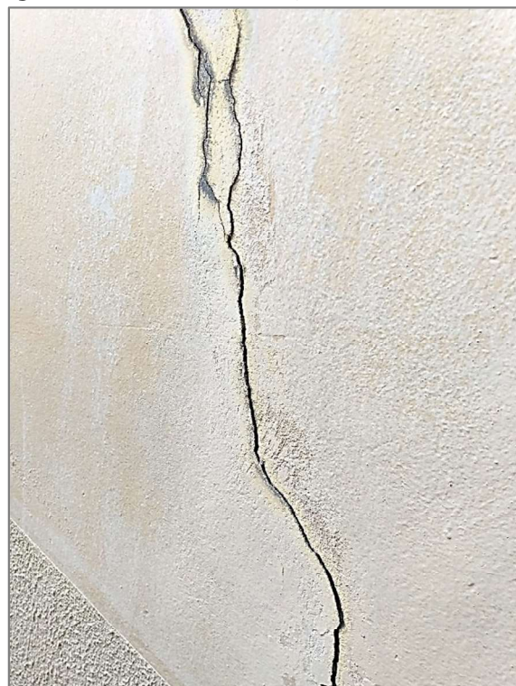
Figura 75 – Fissuração de canto no corredor externo. Figura 76 – Detalhe da fissuração de canto no corredor.
