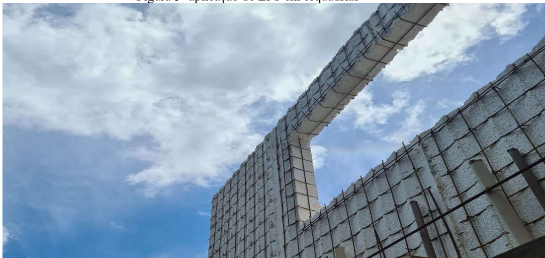
Figura 5- aplicação de EPS em esquadrias
