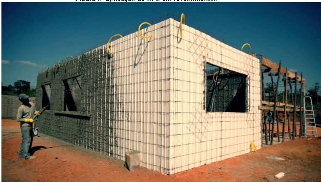
Figura 6- aplicação de EPS em revestimentos
