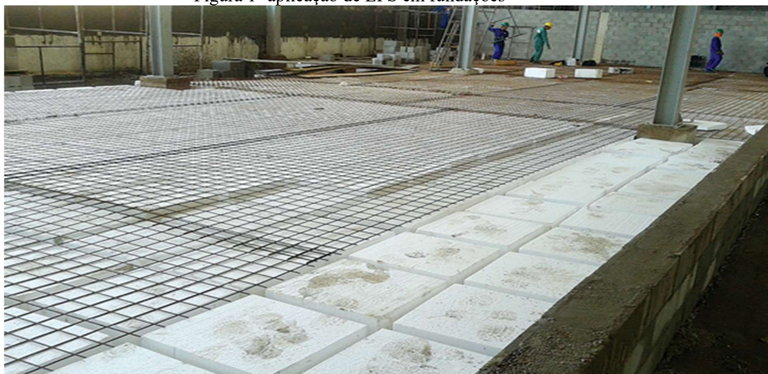
Figura 1- aplicação de EPS em fundações
