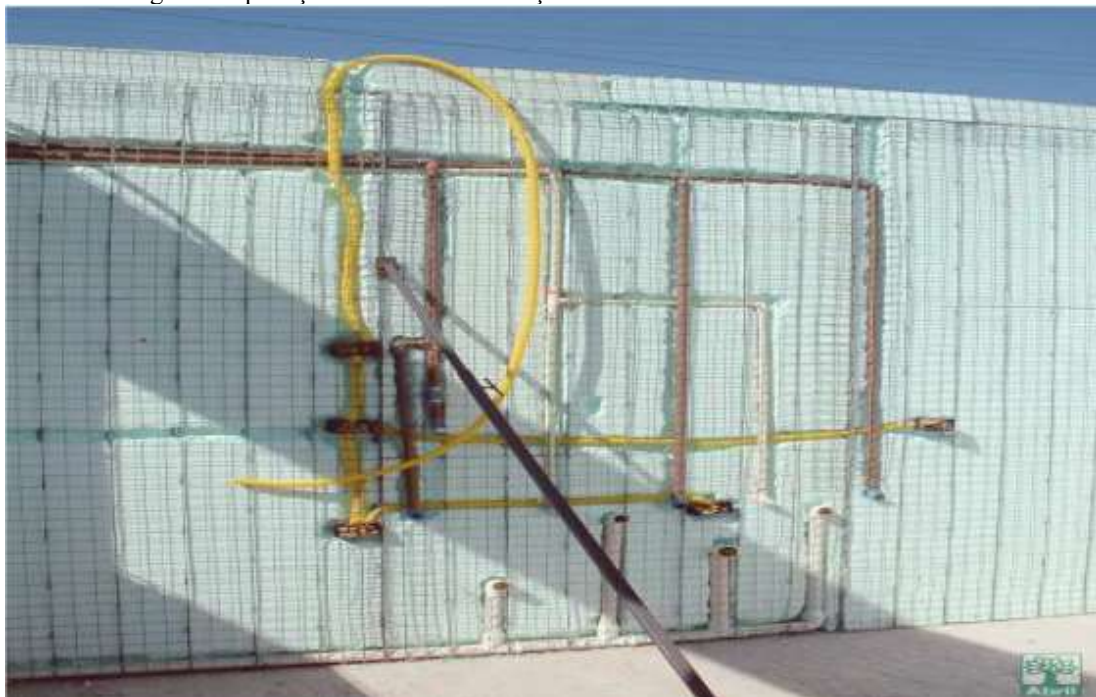
Figura 4- aplicação de EPS em instalações elétricas e hidrossanitárias
