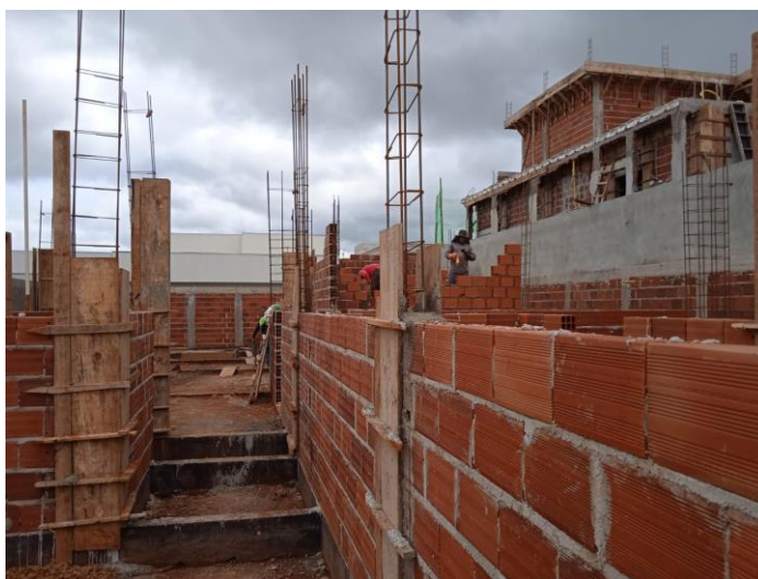
Figura 11 – Obra da edificação em estudo
