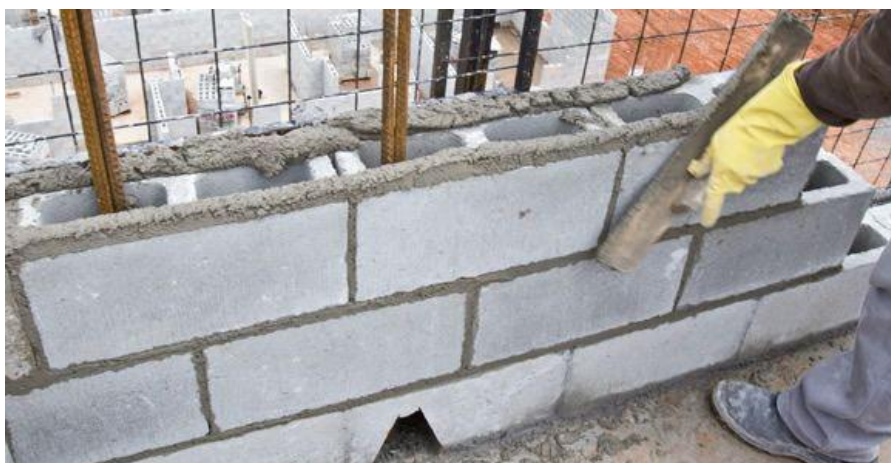
Figura 3 – Argamassa de assentamento
