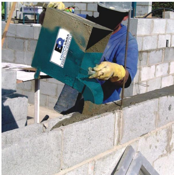
Figura 4 – Grauteamento das canaletas
