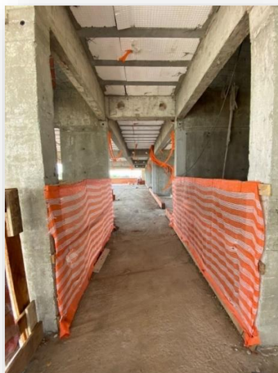
Figura 23: Guarda corpo e rodapé no vão do elevador
