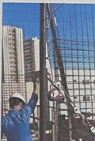
Foto 12 – Flecha final do cabo de aço – 600mm.
