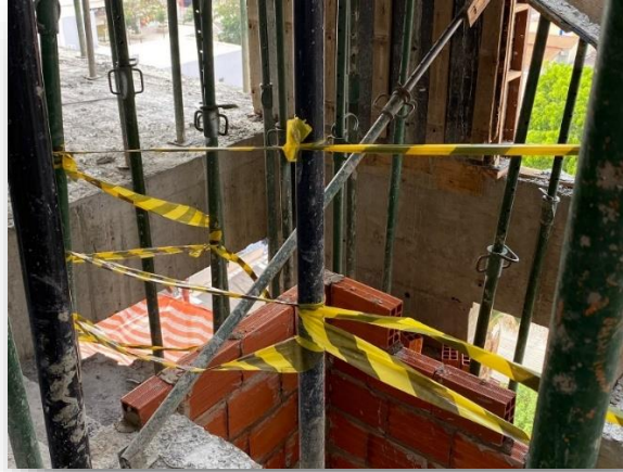
Figura 20: Vão da escada
