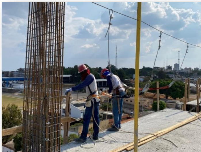
Figura 31: Carpinteiro ancorado na linha de vida
