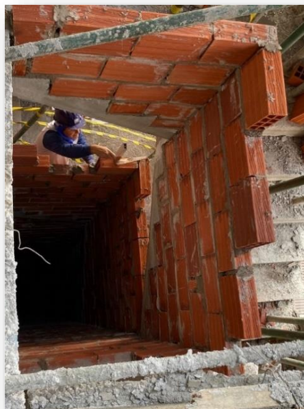
Figura 19: Vão da escada
