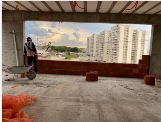
Figura 30: Pedreiro ancorado na linha de vida
