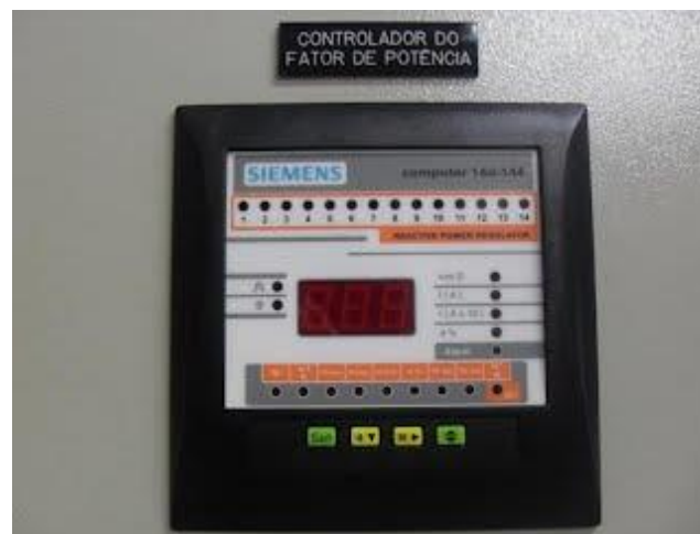
Figura 15 - Representação do Controlador de fator de potência
