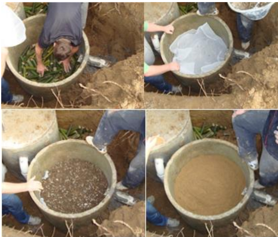
Imagem 8- Montagem do sistema de tratamento
