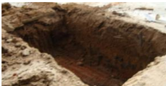
Imagem 6- Buraco usado para acondicionamento dos tubos de concreto
