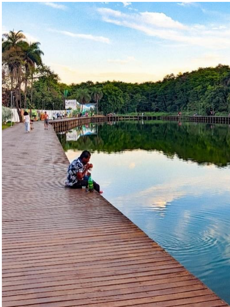
Figura 1 – Deck sem proteção. Fonte: O autor.
