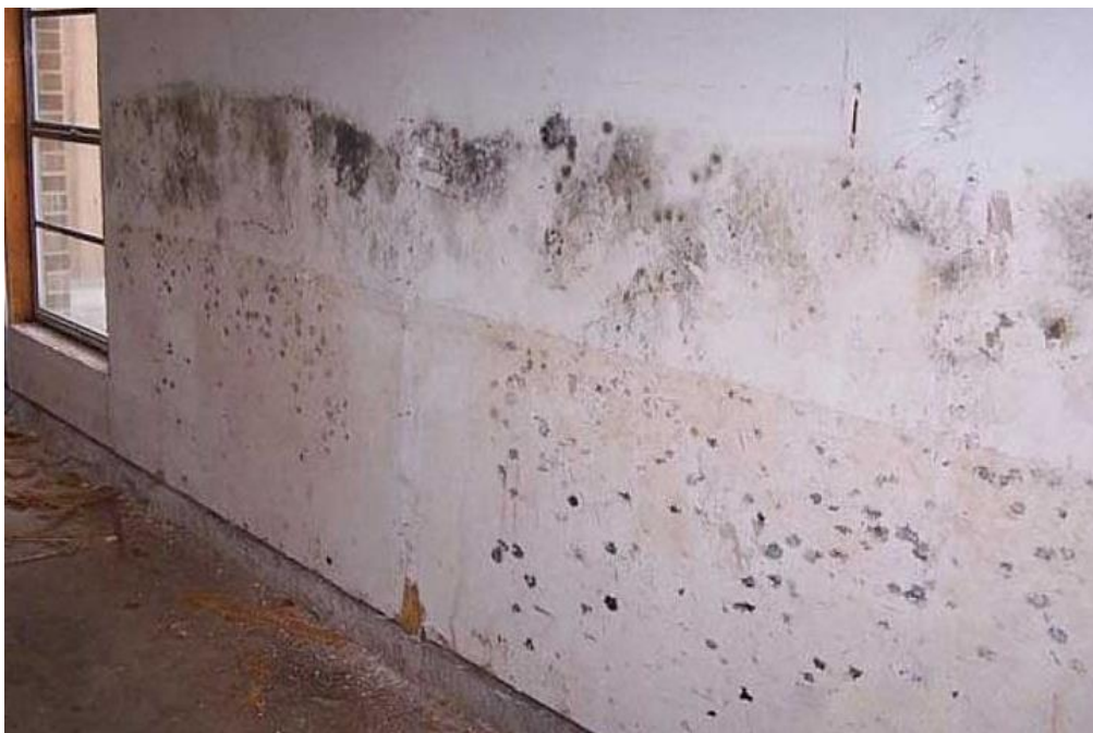
Figura 63 — Manchas causadas pelo mofo e bolor
