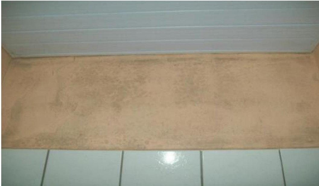
Figura 63 — Manchas causadas pelo mofo e bolor
