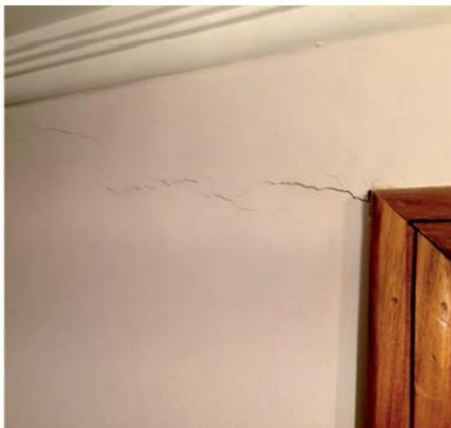
Figura 39 — Fissuras de flexão em alvenarias apoiadas sobre vigas de concreto armado e com a presença de aberturas
