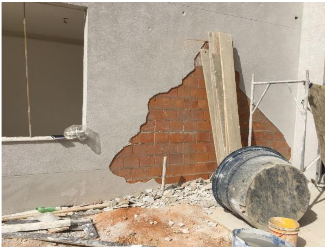
Figura 66 — Deslocamento de argamassa projetada da alvenaria com eflorescência
