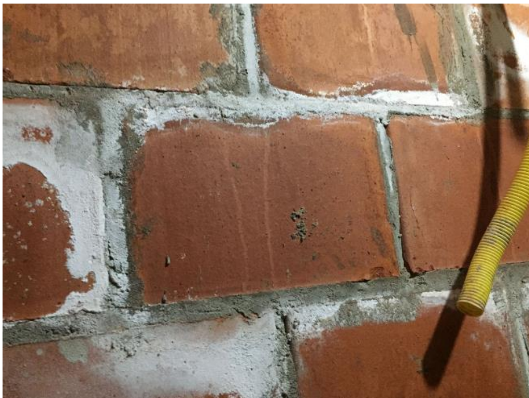
Figura 66 — Deslocamento de argamassa projetada da alvenaria com eflorescência
