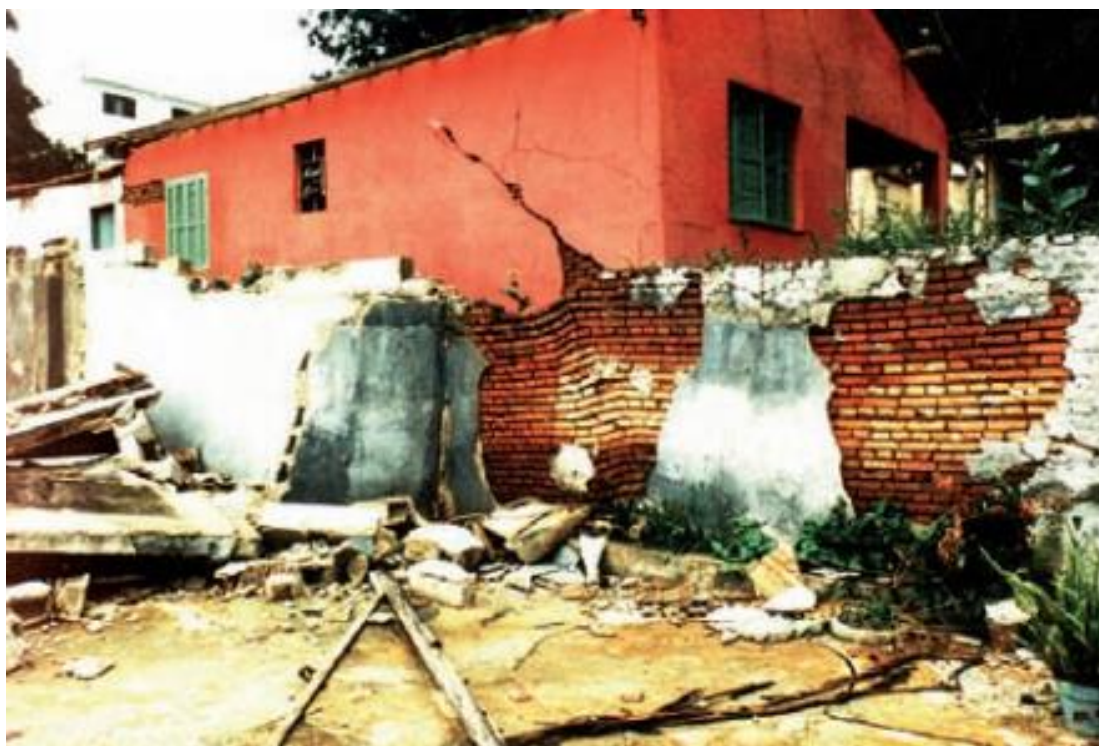
Figura 55 — Posição do recalque claramente indicada pelas fiadas de tijolos: a fissura principal que se desenvolveu na parede da casa sobre o muro inclina-se em direção ao ponto de maior recalque
