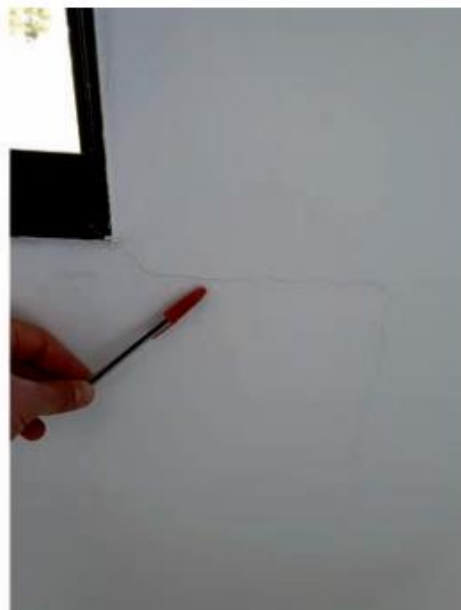
Figura 39 — Fissuras de flexão em alvenarias apoiadas sobre vigas de concreto armado e com a presença de aberturas
