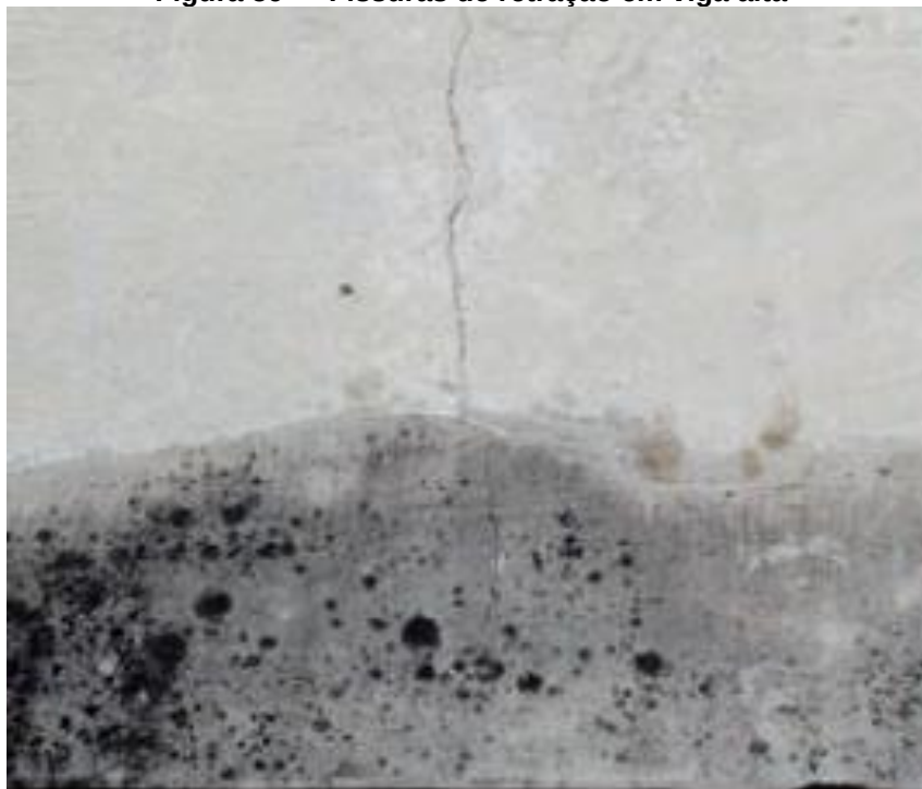
Figura 59 — Fissuras de retração em viga alta
