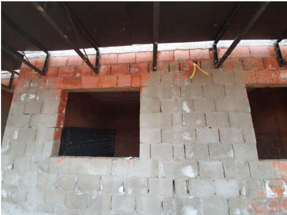
Figura 68 — Eflorescência em alvenaria estrutural de tijolo cerâmico com chapisco
