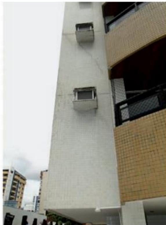
Figura 40 — Trincas na alvenaria provocadas por flexão da região em balanço da viga
