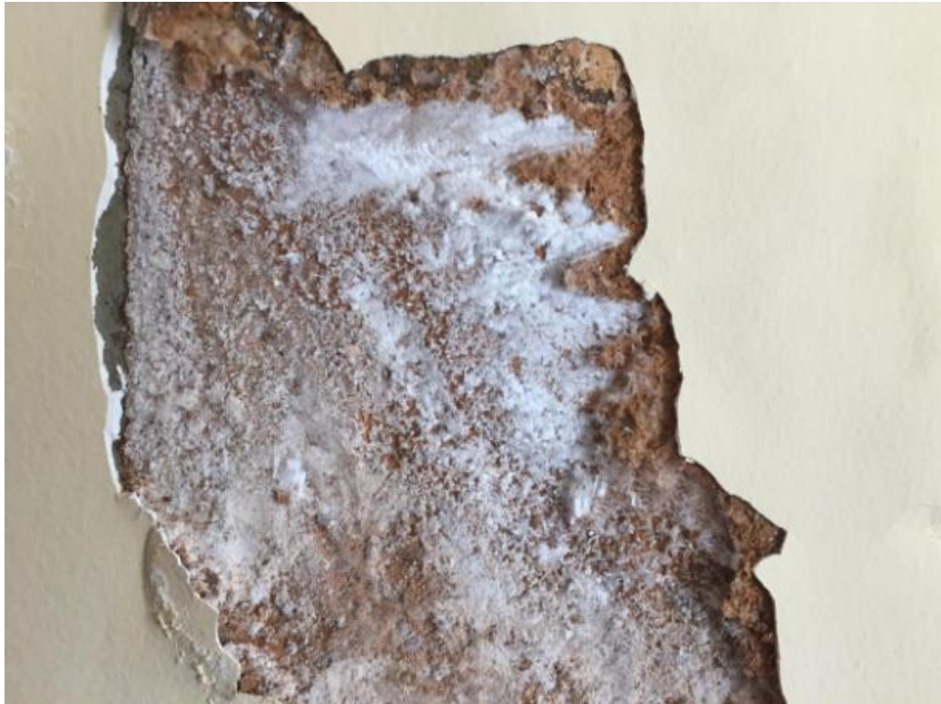
Figura 68 — Eflorescência em alvenaria estrutural de tijolo cerâmico com chapisco
