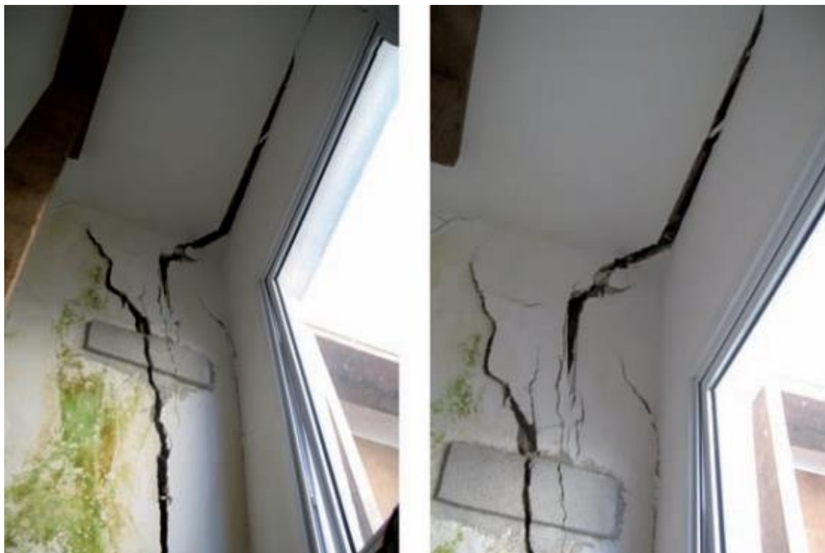
Figura 55 — Posição do recalque claramente indicada pelas fiadas de tijolos: a fissura principal que se desenvolveu na parede da casa sobre o muro inclina-se em direção ao ponto de maior recalque
