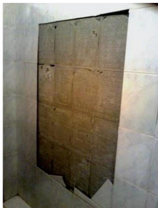
Figura 43 — Compressão da alvenaria, arqueamento e expulsão do revestimento cerâmico em parede apoiada na extremidade de balanço viga
