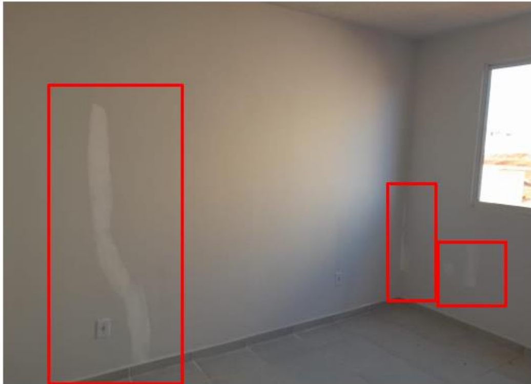
Figura 24 - Fissuras e trincas corrigidas
