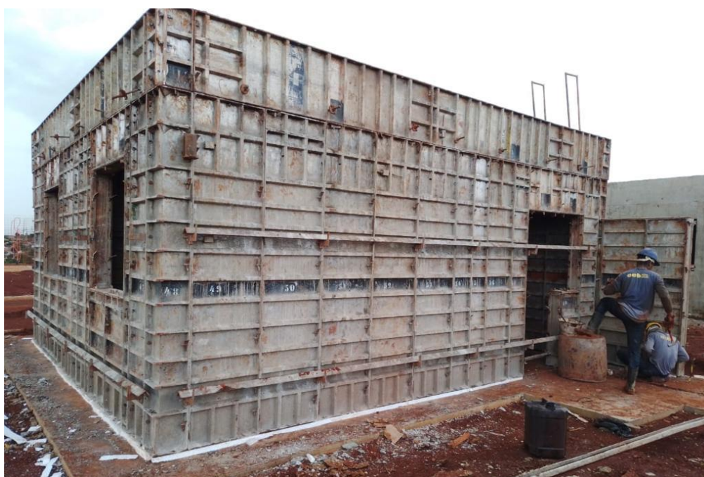
Figura 19 - Casa de parede de concreto
