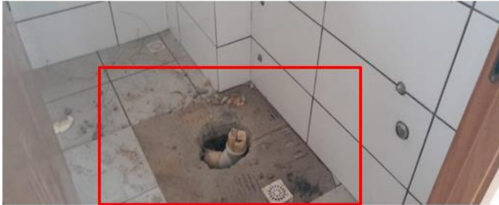
Figura 26 - Quebra de cerâmica e radier para colocar a tubulação do vaso sanitário
