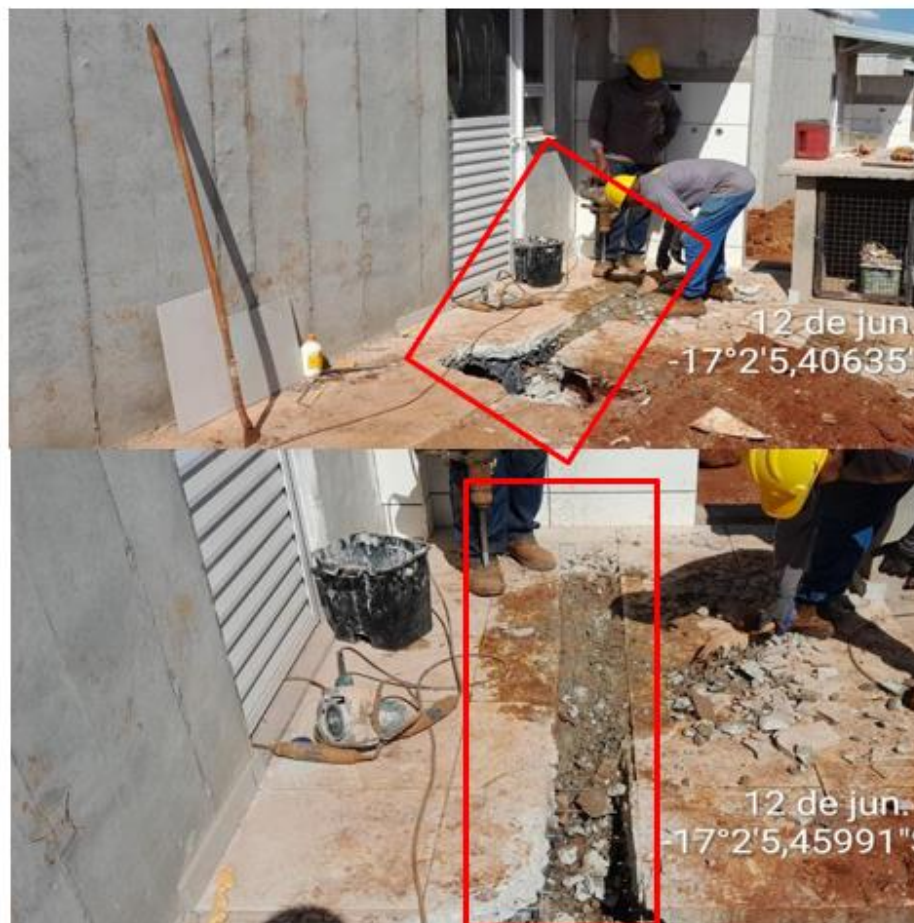
Figura 27 - Quebra de cerâmica e radie para colocar a tubulação do tanque da área de serviço
