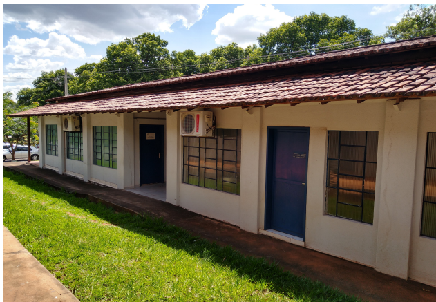
Figura 25 - Local de instalação do sistema off-grid do FótonLab/UFG
