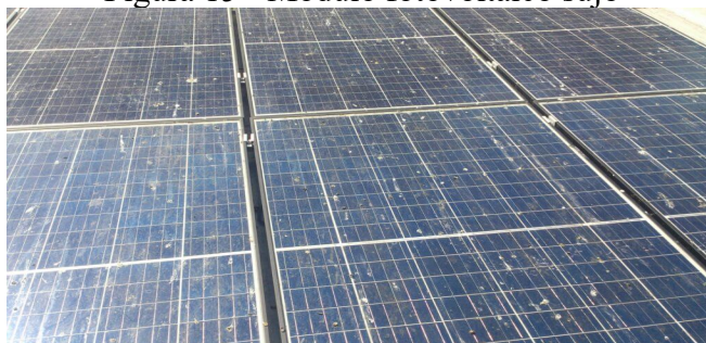
Figura 15 - Módulo fotovoltaico sujo
