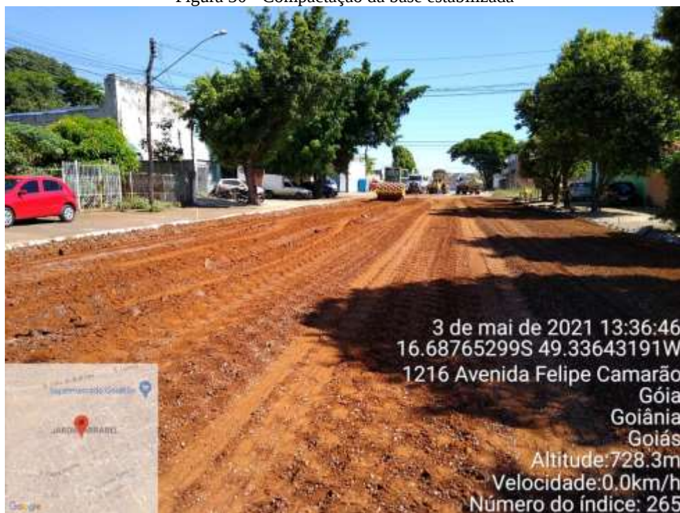
Figura 30 - Compactação da base estabilizada
