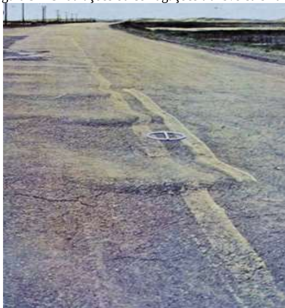
Figura 9 – Ondulações ou corrugações transversais na via
