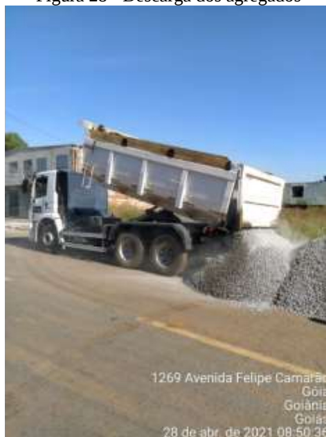
Figura 28 - Descarga dos agregados
