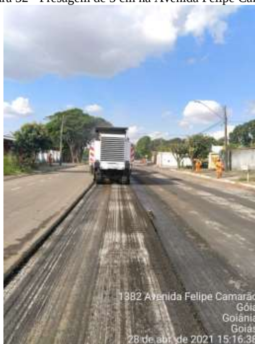
Figura 32 - Fresagem de 3 cm na Avenida Felipe Camarão
