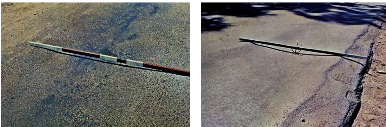
Figuras 8a e 8b– Afundamento plástico local e afundamento plástico de trilha de roda
