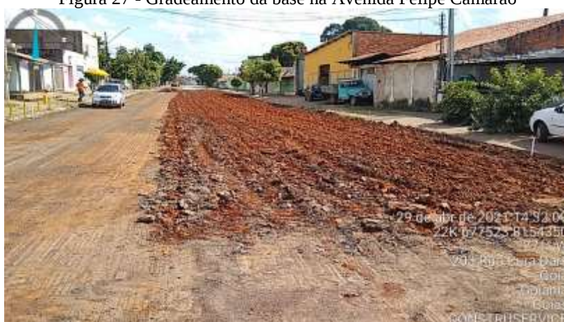
Figura 27 - Gradeamento da base na Avenida Felipe Camarão
