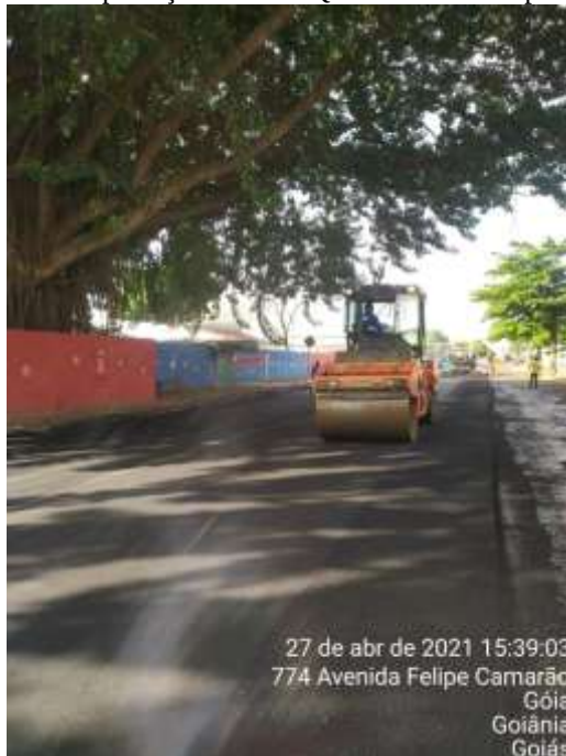
Figura 33 - Compactação do CBUQ da Avenida Felipe Camarão.
