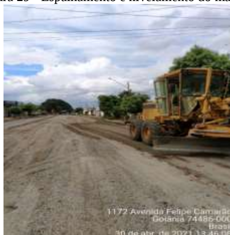
Figura 29 - Espalhamento e nivelamento do material
