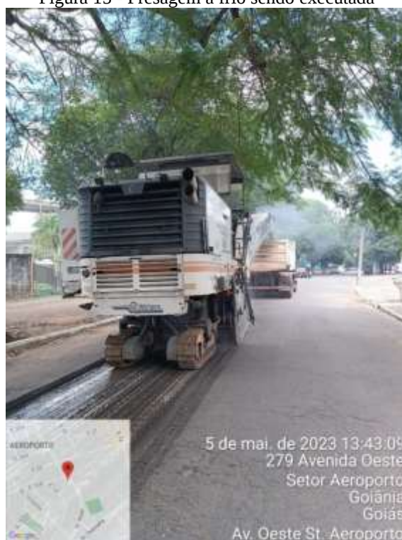
Figura 15 - Fresagem a frio sendo executada
