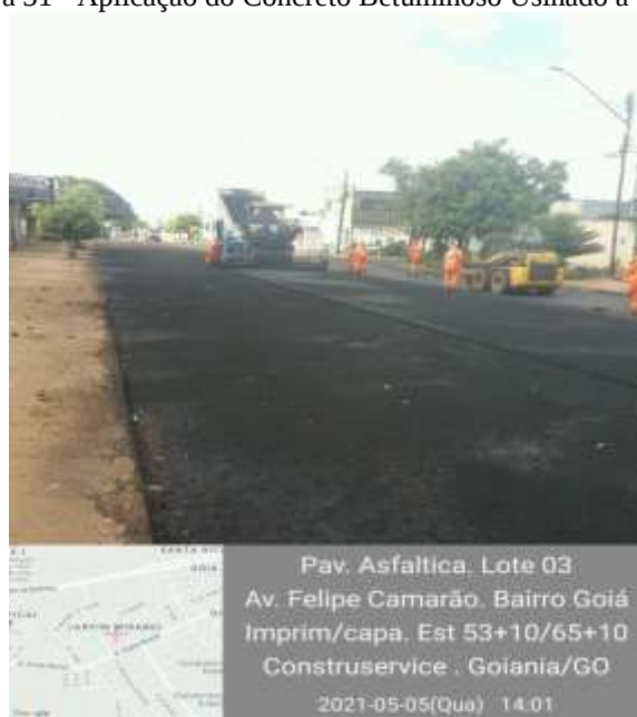
Figura 31 - Aplicação do Concreto Betuminoso Usinado a Quente
