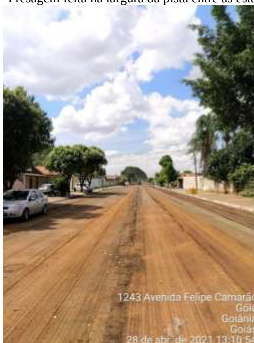
Figura 26 - Fresagem feita na largura da pista entre as estacas 53 e 65
