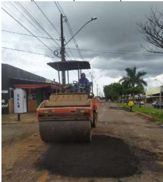
Figura 14 – Execução de remendo superficial
