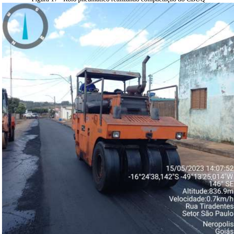
Figura 17 - Rolo pneumático realizando compactação do CBUQ
