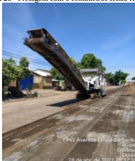
Figura 25 - Fresagem com 6 centímetros sendo realizada
