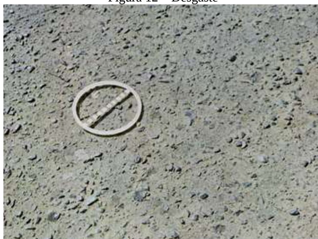
Figura 12 – Desgaste
