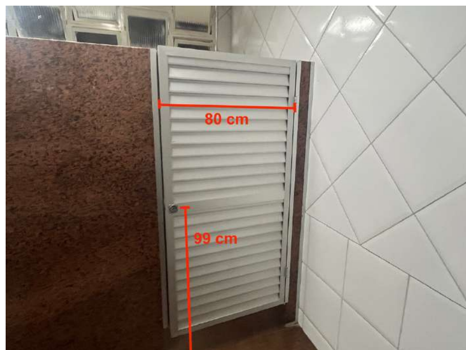
Figura 92: Banheiro feminino superior – Porta e maçaneta. Fonte: autora.
