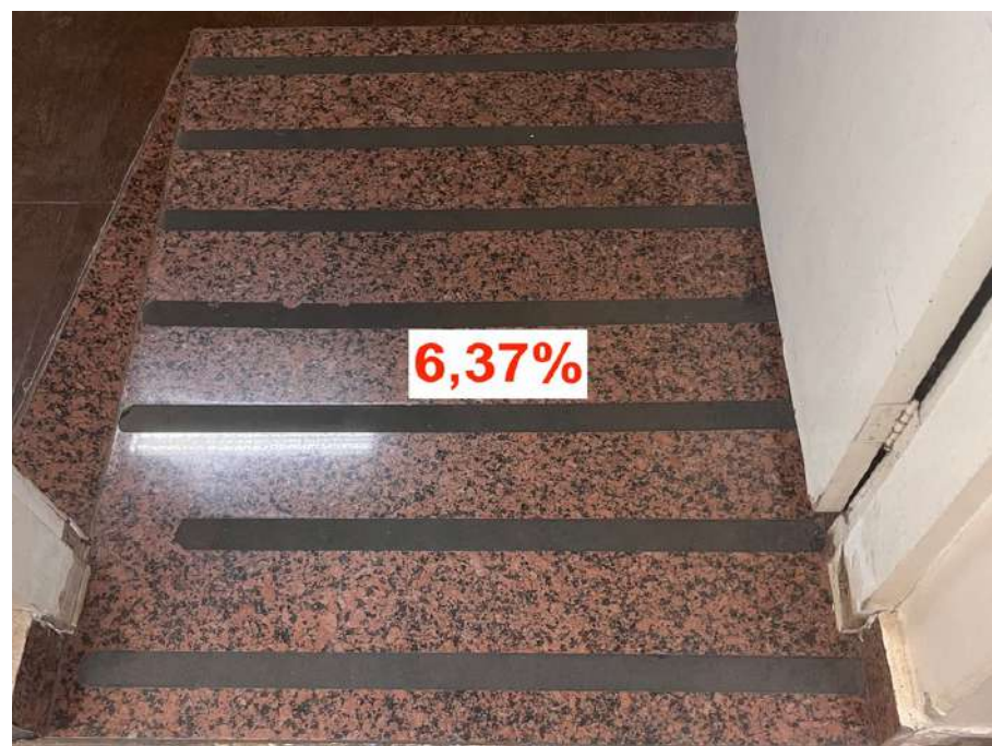
Figura 94: Banheiro masculino superior – Inclinação rampa, desnível de 13 cm. Fonte: autora.
