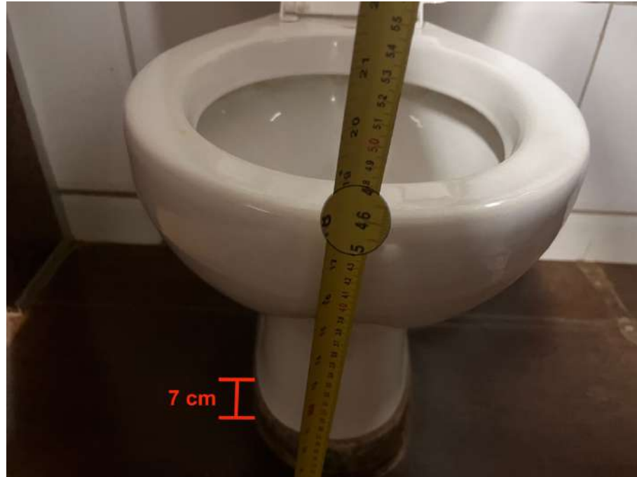
Figura 83: Banheiro masculino térreo – Dimensões bacia sanitária. Fonte: autora.
