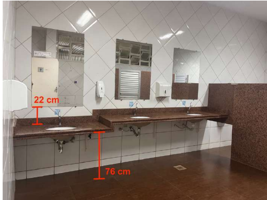
Figura 79: Banheiro masculino térreo – Bancada pia e espelho. Fonte: autora.
