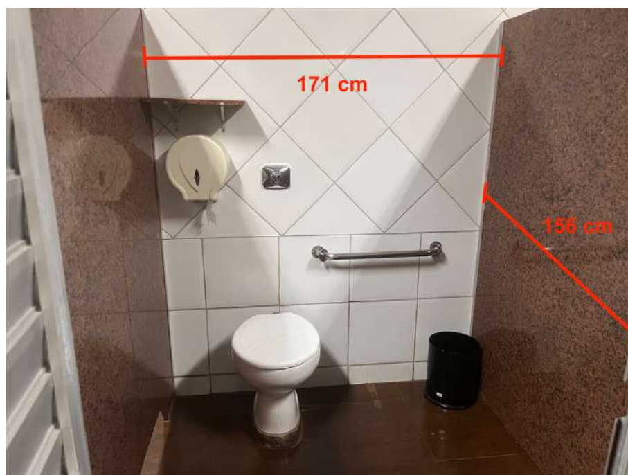
Figura 82: Banheiro masculino térreo – Dimensões. Fonte: autora.
