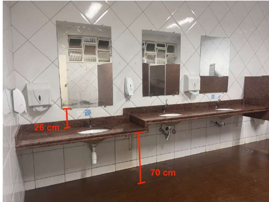
Figura 95: Banheiro masculino superior – Bancada pia e espelho. Fonte: autora.
