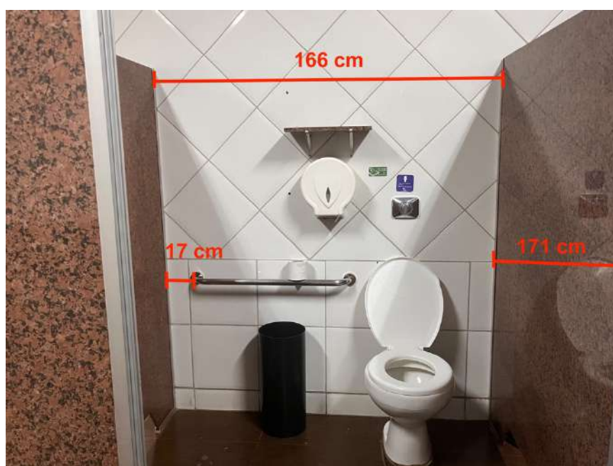
Figura 74: Banheiro feminino térreo – Dimensões. Fonte: autora.
