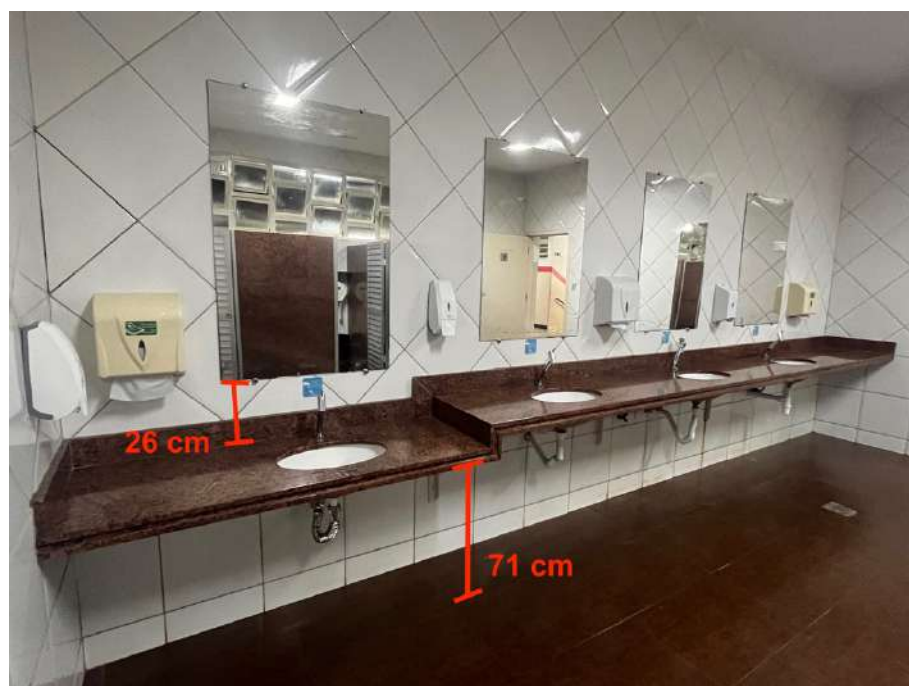
Figura 88: Banheiro feminino superior – Bancada pia e espelho. Fonte: autora.
