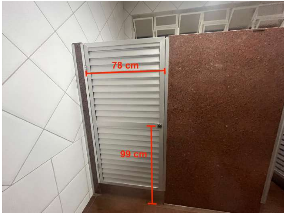
Figura 99: Banheiro masculino superior – Porta e maçaneta. Fonte: autora.
