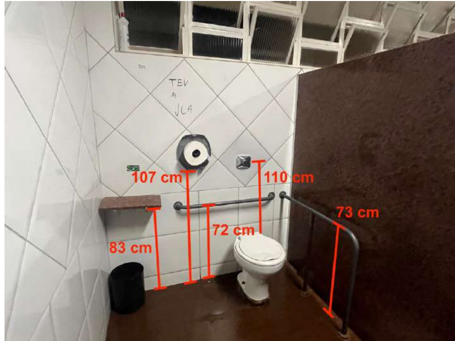
Figura 97: Banheiro masculino superior – Dimensões internas. Fonte: autora.
