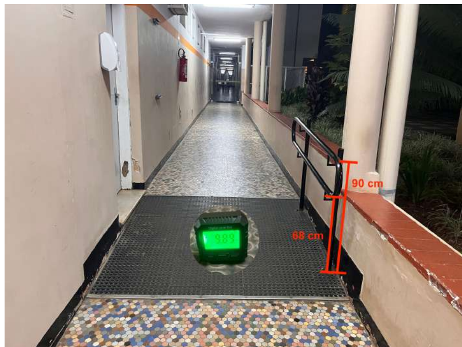
Figura 42: Rampa 01 desnível de 14 cm. Fonte: autora.
