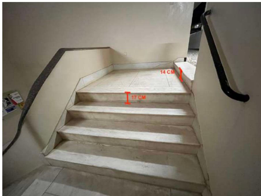
Figura 33: Bloco 100 escada 01. Fonte: autora.
