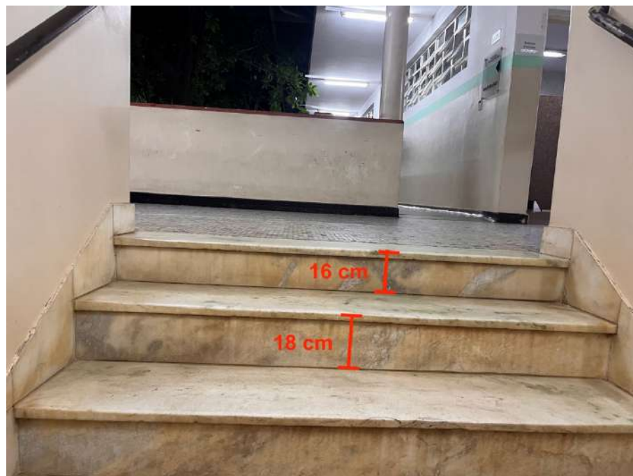
Figura 39: Bloco 200 escada 03. Fonte: autora.
