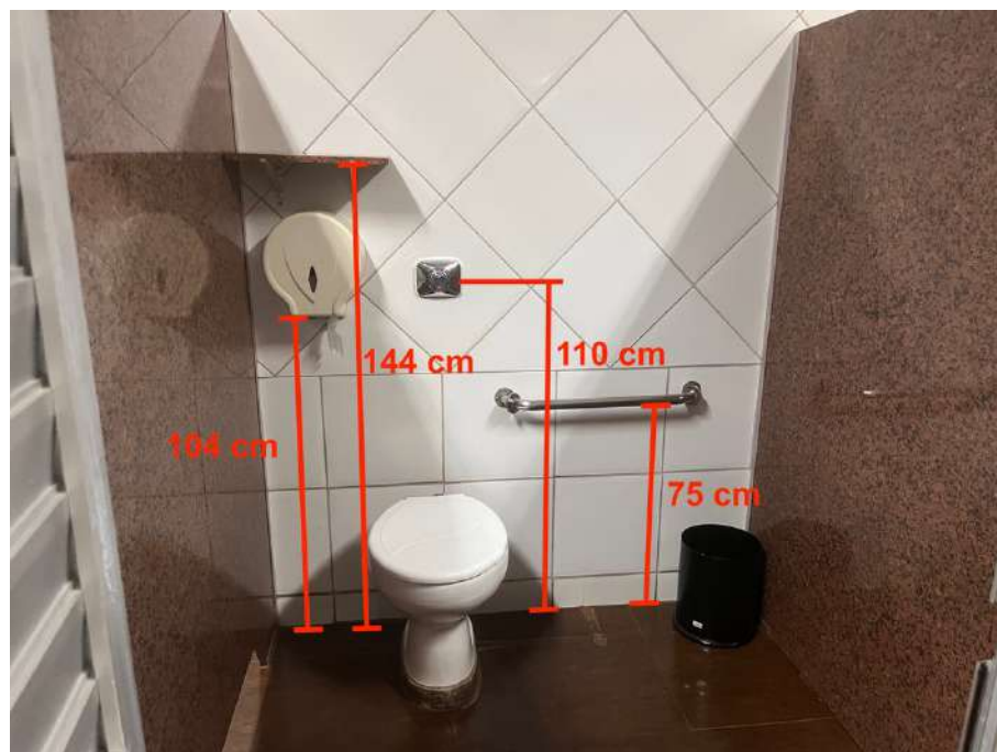
Figura 81: Banheiro masculino térreo – Dimensões internas. Fonte: autora.
