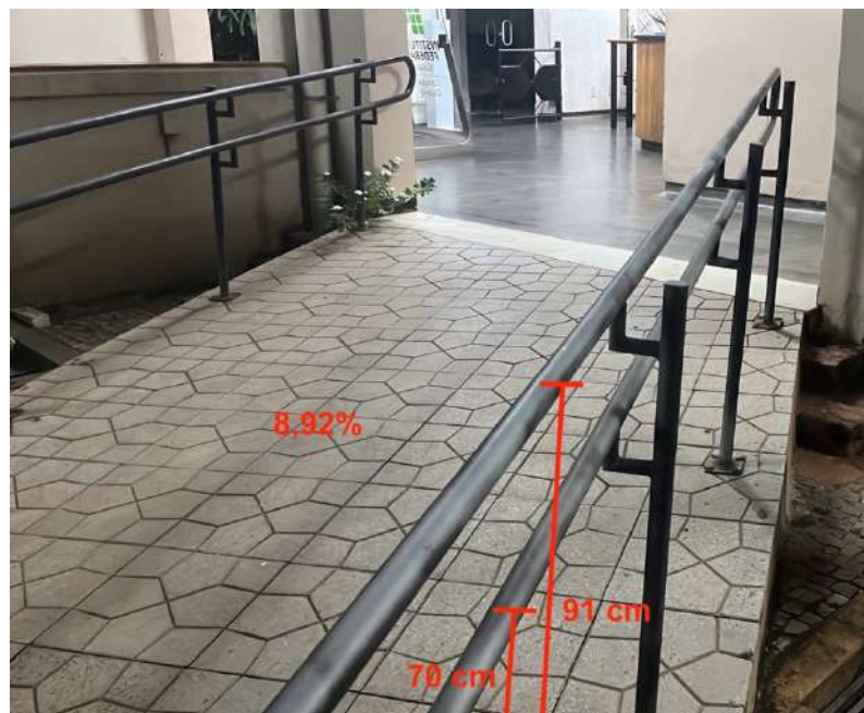
Figura 48: Rampa 04 desnível de 32 cm. Fonte: autora.
