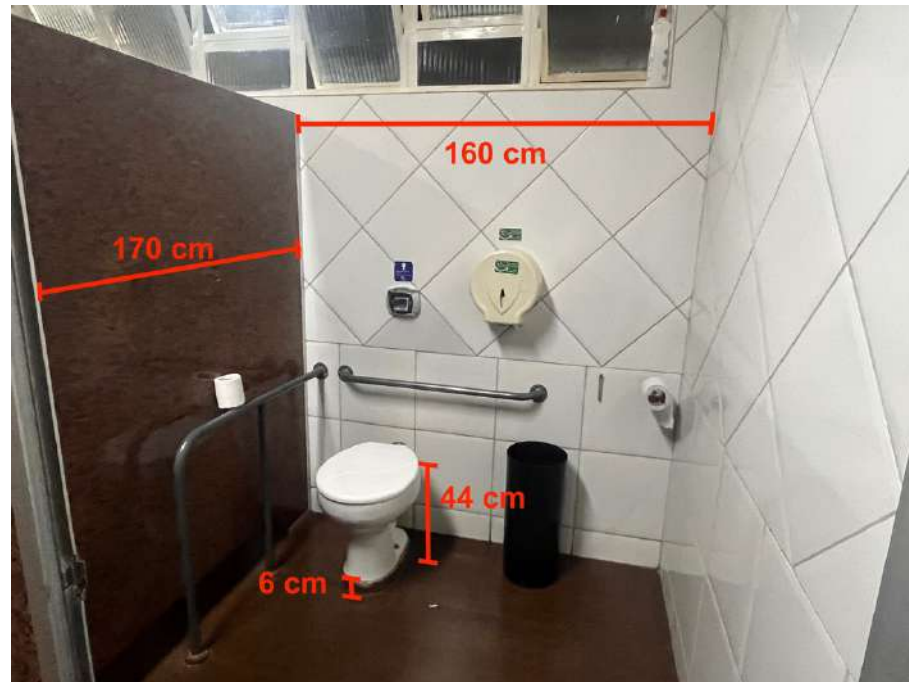
Figura 91: Banheiro feminino superior – Dimensões e bacia sanitária. Fonte: autora.
