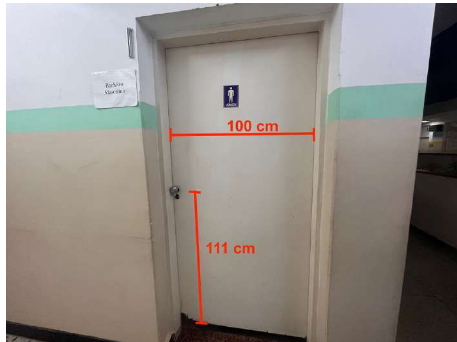
Figura 93: Banheiro masculino superior – Porta de entrada. Fonte: autora.
