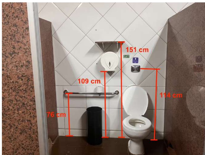
Figura 73: Banheiro feminino térreo – Dimensões internas. Fonte: autora.
