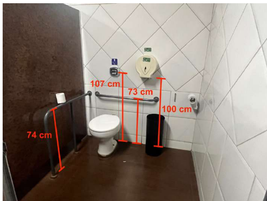
Figura 90: Banheiro feminino superior – Dimensões internas. Fonte: autora.
