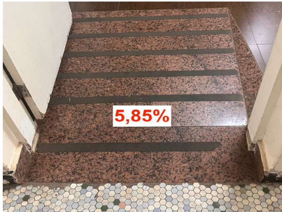
Figura 87: Banheiro feminino superior – Inclinação rampa, desnível de 16 cm. Fonte: autora.
