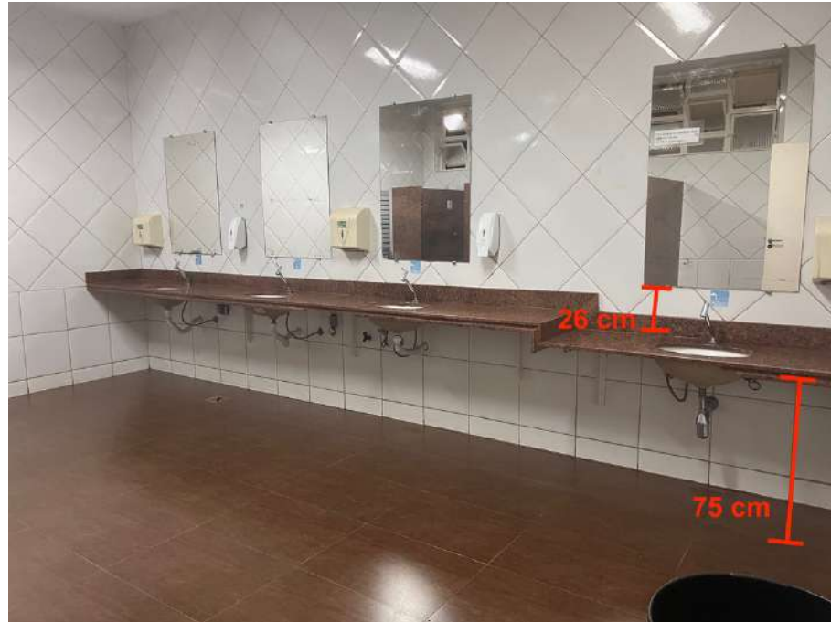
Figura 71: Banheiro feminino térreo – Bancada pia e espelho. Fonte: autora.
