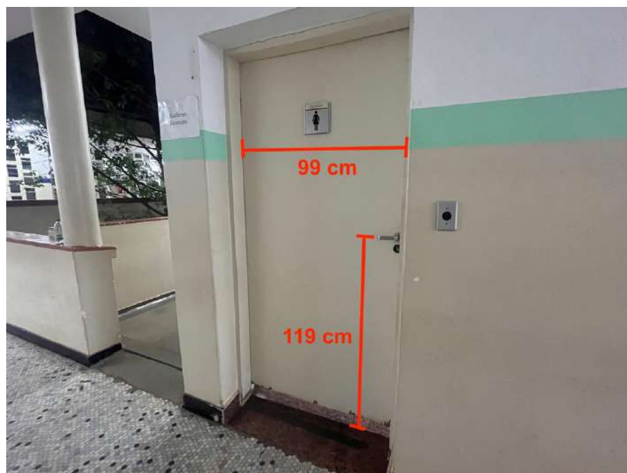
Figura 86: Banheiro feminino superior – Porta de entrada. Fonte: autora.
