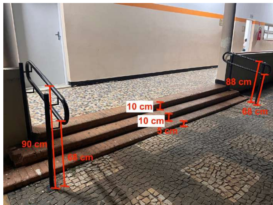
Figura 37: Escada acesso ao bloco 100. Fonte: autora.
