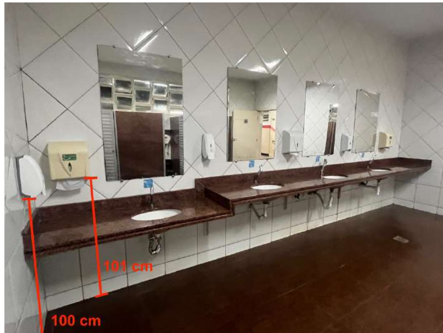
Figura 89: Banheiro feminino superior – Dispenser de papel toalha e sabonete. Fonte: autora.
