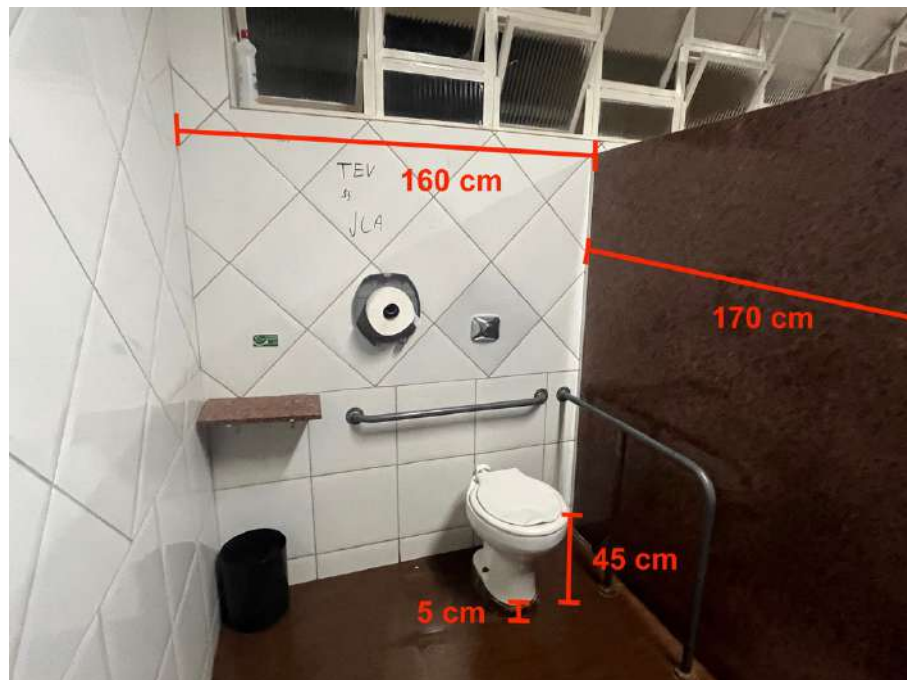
Figura 98: Banheiro masculino superior – Dimensões e bacia sanitária. Fonte: autora.
