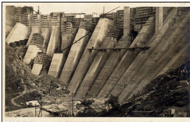
Figura 8. Elevação da Barragem do Ribeirão das Lajes
