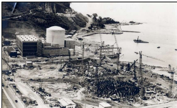
Figura 21. Vista Geral da Unidade I da Usina Eletronuclear de Angra dos Reis (RJ)
