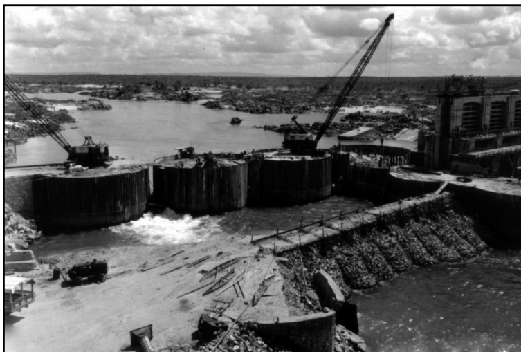
Figura 13. Usina Hidrelétrica de Paulo Afonso I
